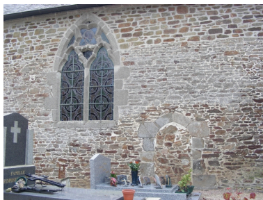
Façade nord Phot. Stéphanie Ménard IVR53_20073506099NUCA
