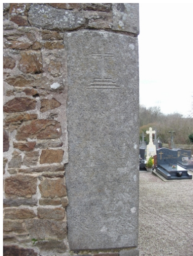
Pierre tombale insérée dans la maçonnerie de l'église Phot. Stéphanie Ménard IVR53_20073506101NUCA
