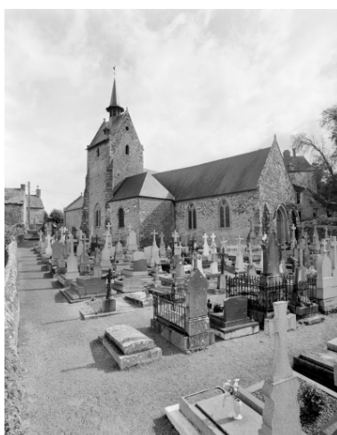
Elévation Nord-Ouest : vue générale
