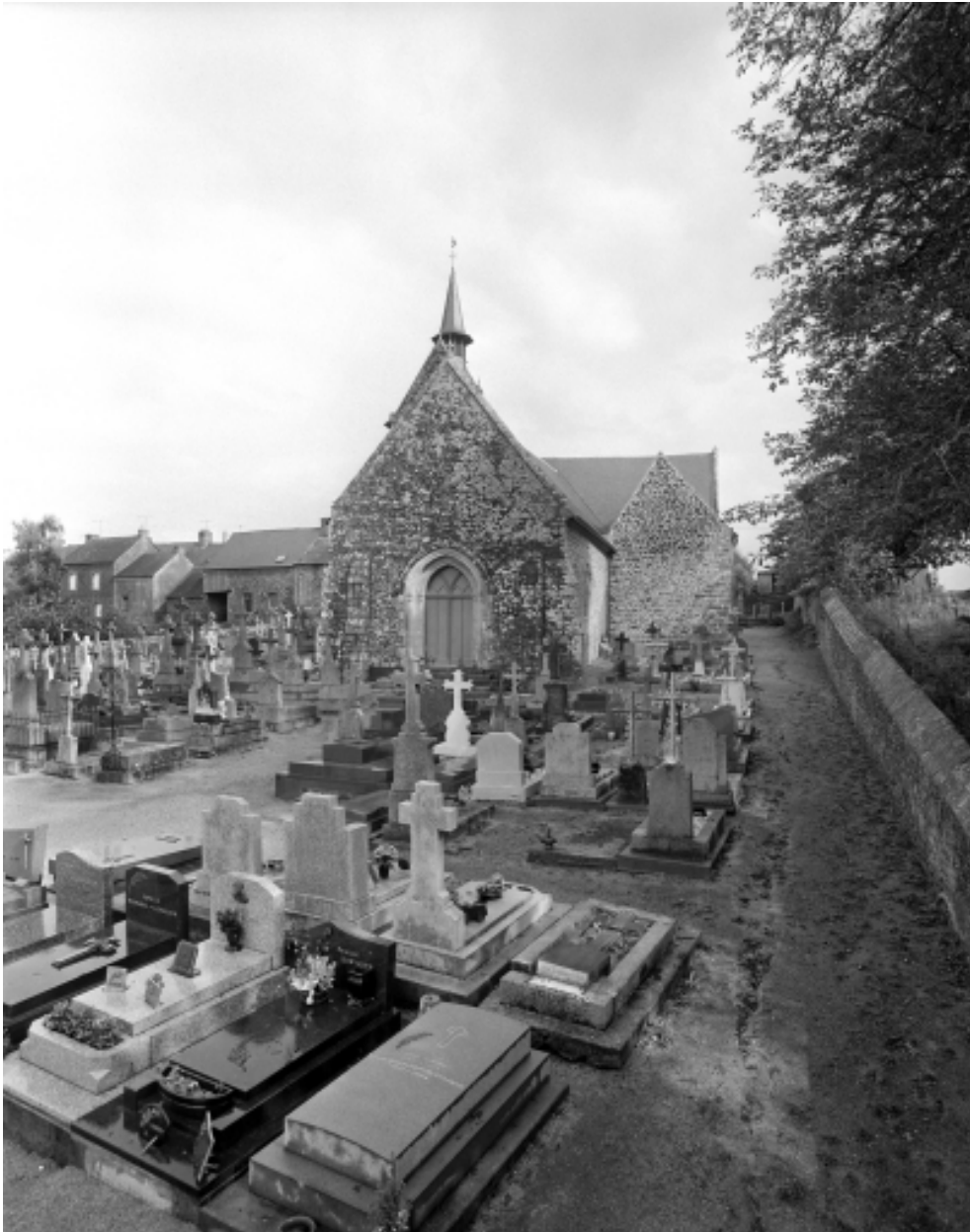
Elévation Ouest : vue générale
