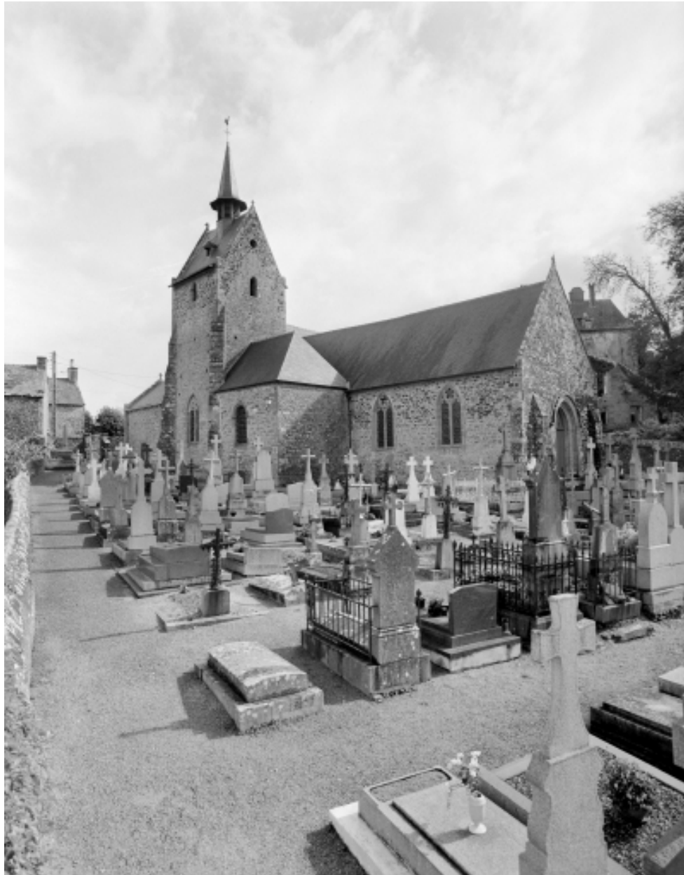
Elévation Nord-Ouest : vue générale
