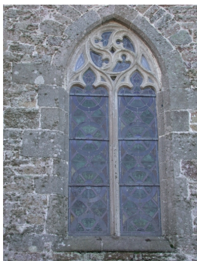
Chapelle nord, sous clocher, (baie 3) Phot. Marie-Dominique Menant IVR53_20073506465NUCA
