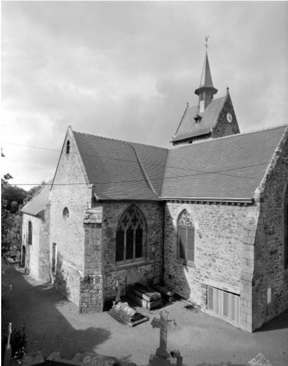
Elévation Sud-Est : vue générale
