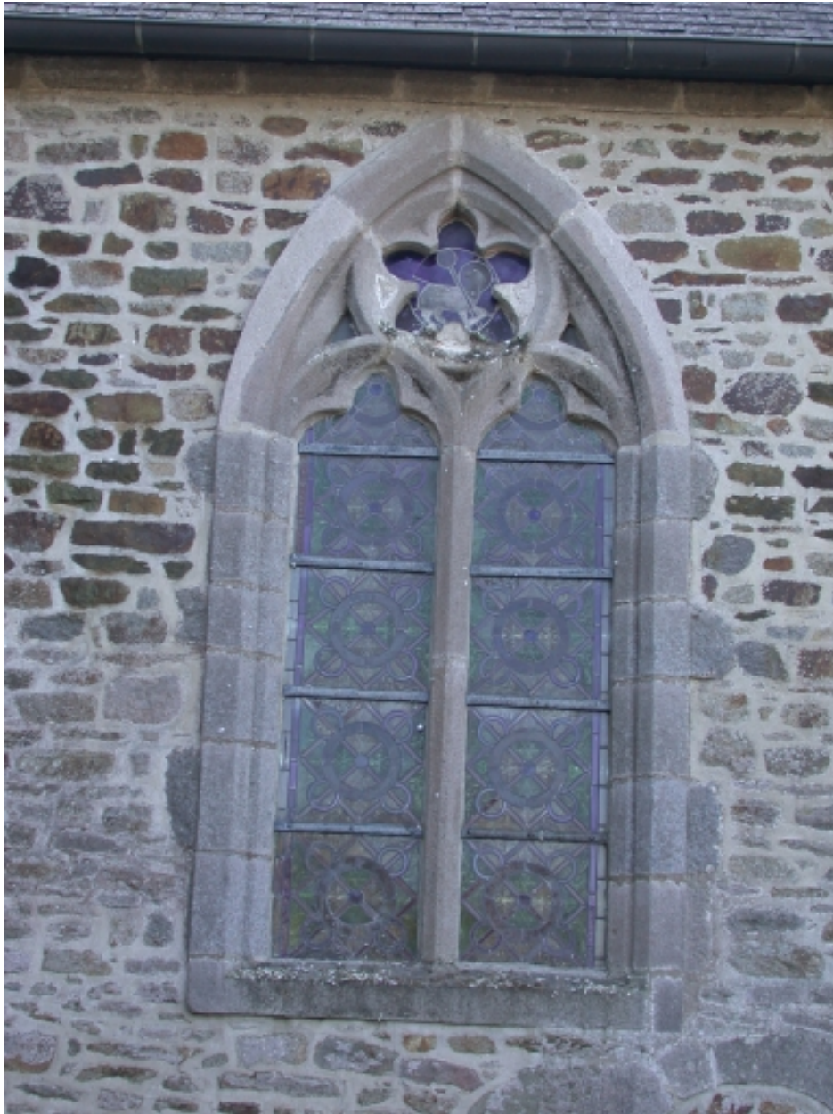
Nef, mur nord, (baie 9)
