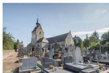
L'église et le cimetière, vue générale Phot. Charlotte Barraud IVR53_20193501491NUCA
