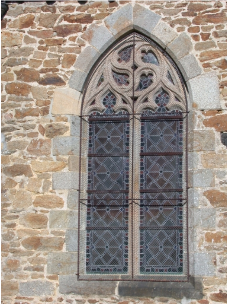
Choeur, mur sud, (baie 2)
