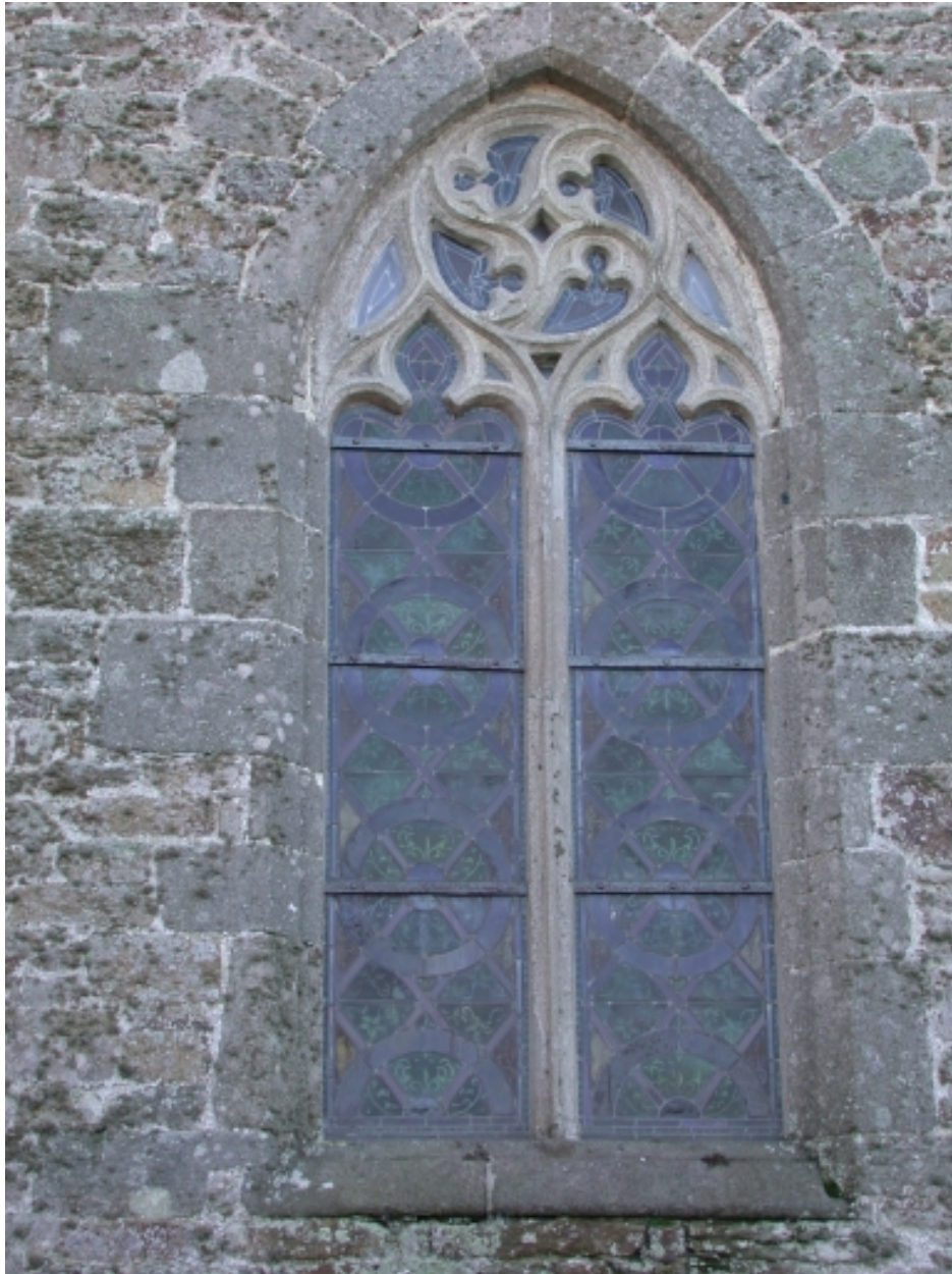
Chapelle nord, sous clocher, (baie 3)
