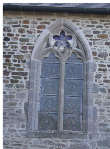
Nef, mur nord, (baie 9) Phot. Marie-Dominique Menant IVR53_20073506470NUCA
