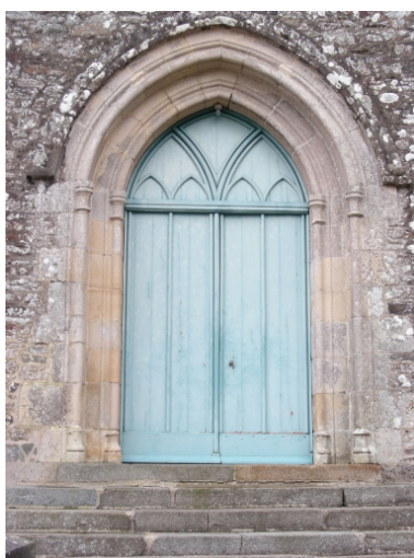
Porte ouest Phot. Stéphanie Ménard IVR53_20073506098NUCA
