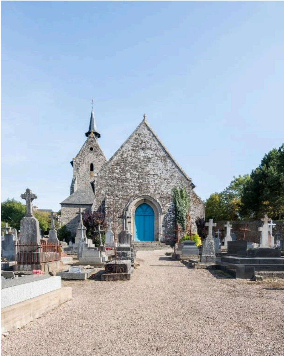
Façade occidentale, vue d'ensemble
