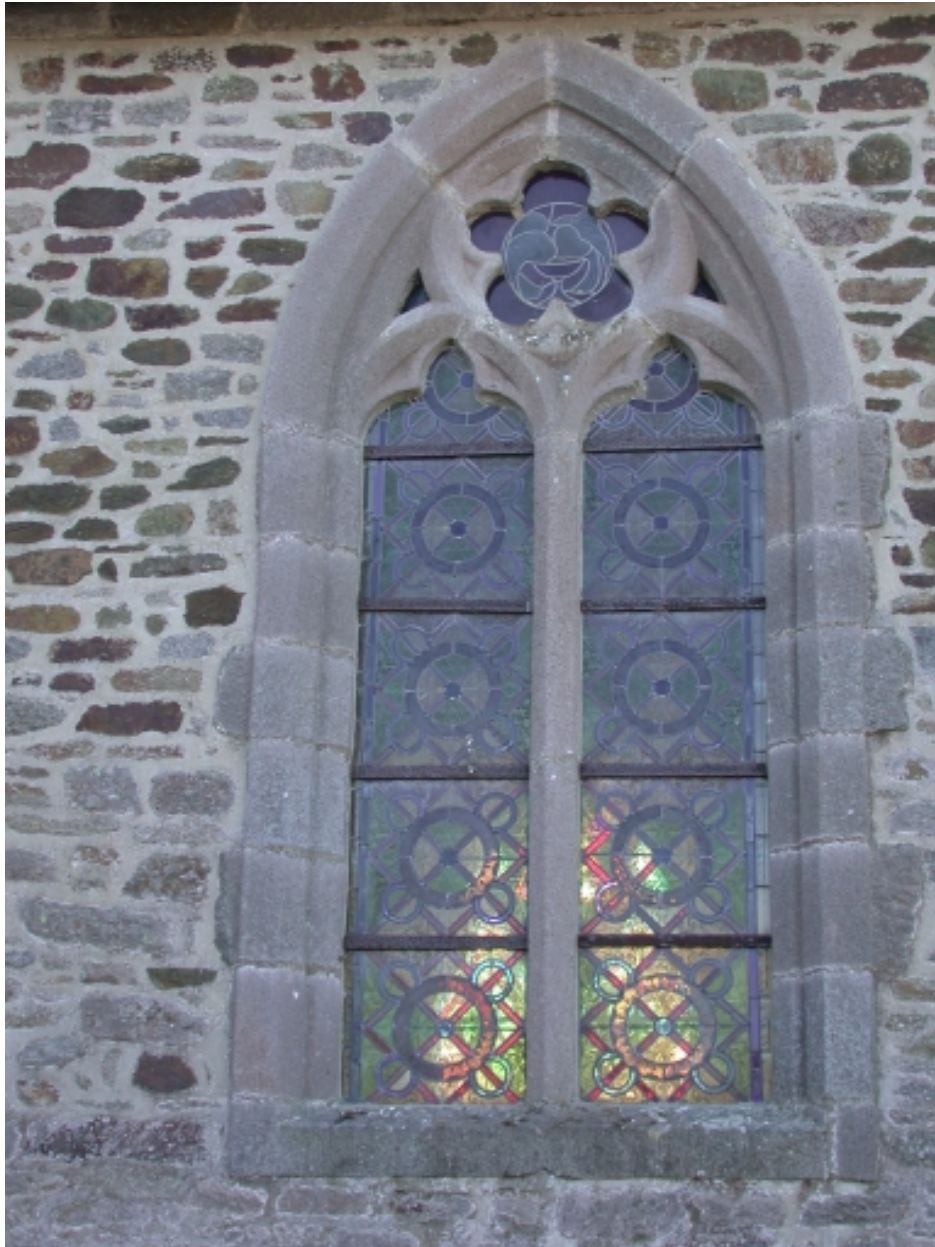
Nef, mur nord, ( baie 7)
