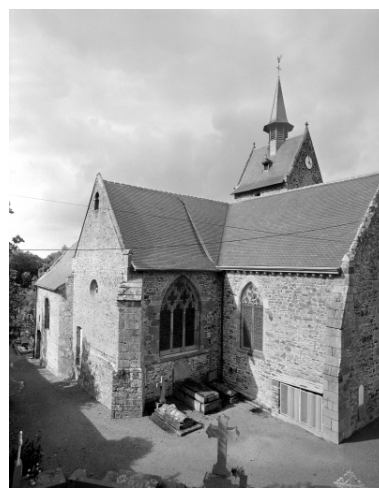
Elévation Sud-Est : vue générale Phot. Guy Artur, Phot. Norbert Lambart IVR53_19943501867X
