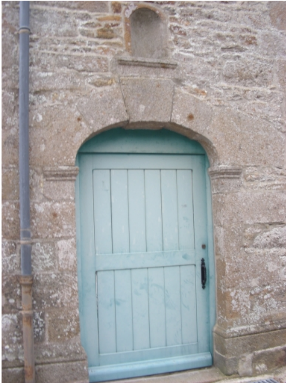
Porte de la façade nord
