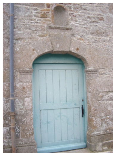
Porte de la façade nord Phot. Stéphanie Ménard IVR53_20073506100NUCA
