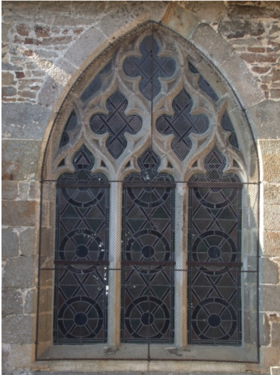
Chapelle sud, mur est, (baie 4)
