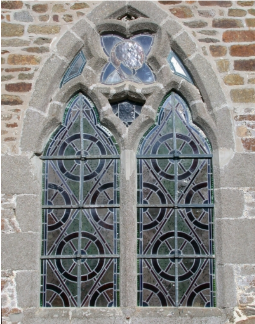
Nef, mur sud, (baie 12)
