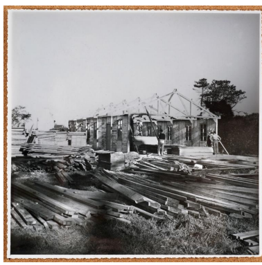
"Construction 2e baraque le long du mur du cimetière de Kerfautras. 1948 ?". (Entre guillemets, légende au dos de la photo). IVR53_20212900438NUCA
