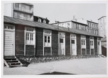
Baraques du collège technique, "Place Sanquer". (Entre guillemets, légende au dos de la photo). IVR53_20212900444NUCA
