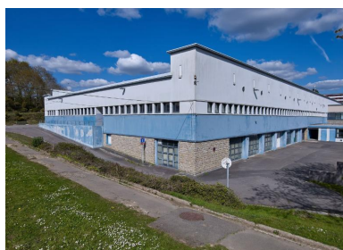
Les ateliers, vue de l'angle sud-ouest. J-B. Mathon, architecte. Phot. Bernard Bègne IVR53_20212900076NUCA
