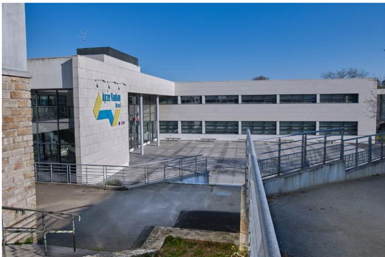
Entrée du lycée, façades ouest et externat, façade sud (vue prise du sud). Archipole Urbanisme et Architecture, 2005.
