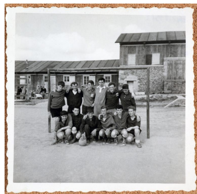
Collège technique en baraques. Photographie d'élèves jouant au football, devant une cage de handball. Photographie d'une équipe. "Avril 1963". (Entre guillemets, légende au dos de la photo). IVR53_20212900464NUCA
