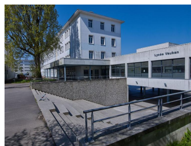
Externat N et galerie matérialisant une entrée du lycée Vauban, depuis un des axes de circulation secondaire de la cité scolaire, distribuant l'ensemble des établissements. Vue prise du sud-est. Phot. Bernard Bègne IVR53_20212900092NUCA
