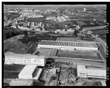
Vue aérienne prise le 10 octobre 1962. A gauche, le gymnase et l'externat. Au centre, les ateliers, à droite, l'école d'ingénieur.
