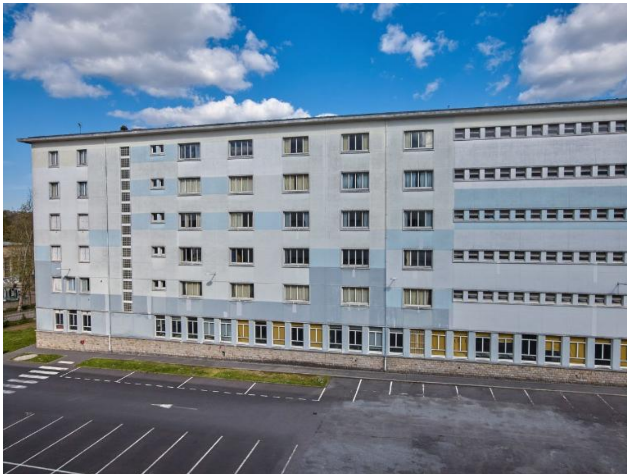
Externat (ancien internat) L, façade ouest, partie nord. J-B. Mathon, architecte.
