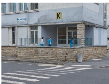
Bâtiment K, internat de garçons. Détail sur une entrée située à l'angle nord-est. J-B. Mathon, architecte. Phot. Bernard Bègne IVR53_20212900222NUCA
