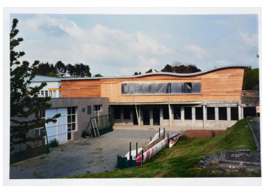
Vue de la façade ouest du CDI (Gildas Nédélec, architecte, 1997) en cours de construction.
