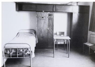
Chambre d'interne ou de surveillant et son mobilier d'origine. Vers 1960. IVR53_20212900477NUCA
