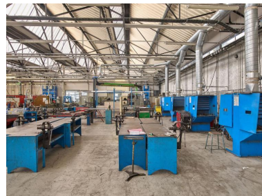
Ateliers H1, vue d'ensemble. Phot. Bernard Bègne IVR53_20212900067NUCA
