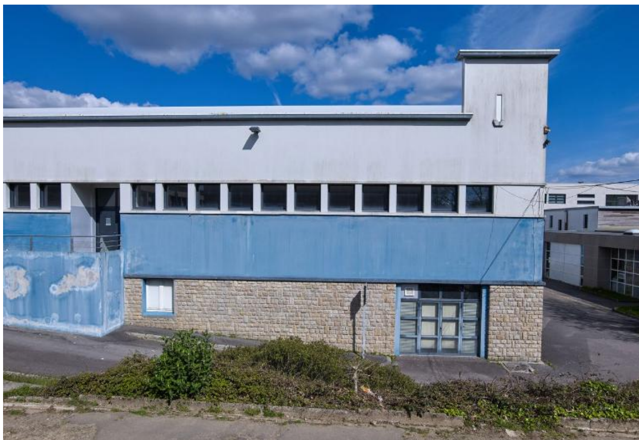
Les ateliers : détail de la façade ouest. J-B. Mathon, architecte.
