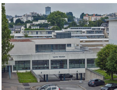
Bâtiment W : accueil, administration, hall (Archipôle, architectes, 2005), façade sud. Il est situé au
