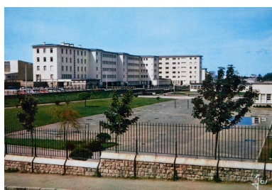
Carte postale Jos. Vue d'ensemble des bâtiments N et L, prise du nord-est.
