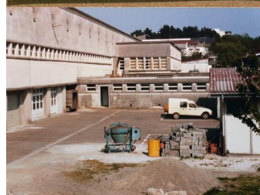
Vues d'ambiance lors de travaux au lycée Vauban. Celle du bas montre la façade sud des ateliers.
