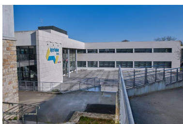
Entrée du lycée, façades ouest et externat, façade sud (vue prise du sud). Archipole Urbanisme et Architecture, 2005. Phot. Bernard Bègne IVR53_20212900088NUCA
