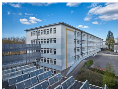
Bâtiment N, externat, vue d'ensemble prise du sud-ouest, depuis un étage du bâtiment L (J-B. Mathon, architecte). Au premier plan, les lanternons d'une extension du bâtiment L, éclairant des salles d'arts appliqués (1998). Noter l'adjonction de galeries de circulation qui relie les bâtiments L et N.
