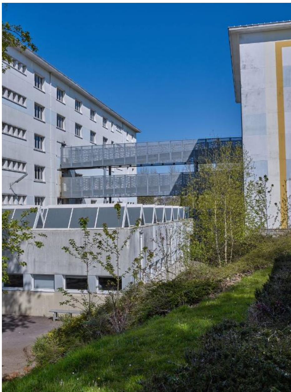
De gauche à droite : externat L, salles d'arts appliqués (1998), passerelles (1998) et angle de l'externat N (1962). Vue prise du sud-est.
