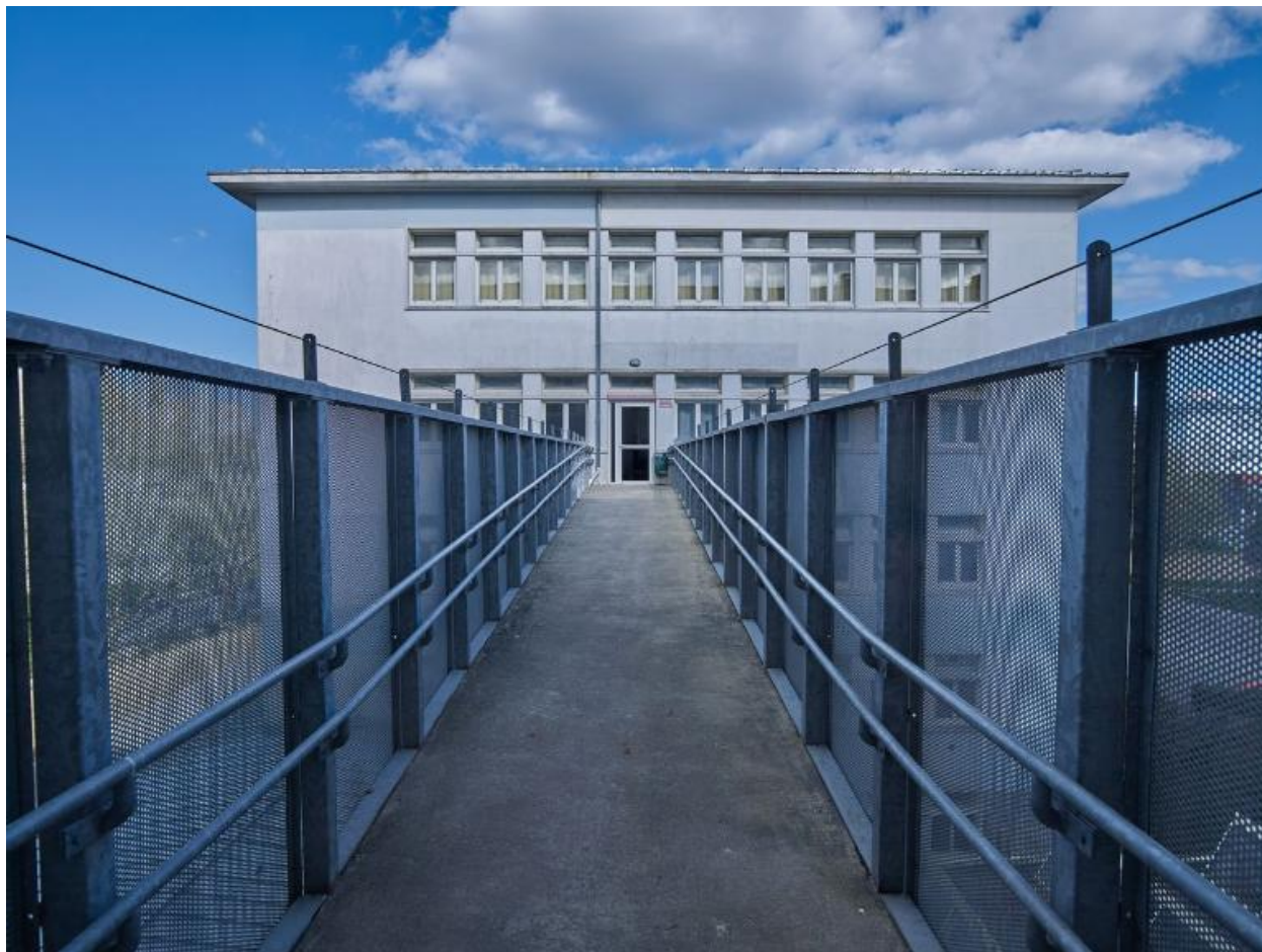
Passerelle d'accès (ajout de 1998) entre les externats L et N et pignon ouest du bâtiment N (J-B. Mathon, architecte).
