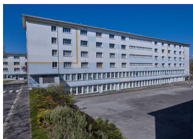
Bâtiment K, internat : vue d'ensemble de la façade est. J-B. Mathon, architecte. Phot. Bernard Bègne IVR53_20212900084NUCA
