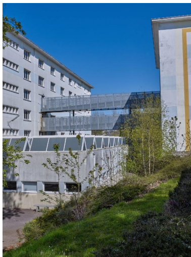
De gauche à droite : externat L, salles d'arts appliqués (1998), passerelles (1998) et angle de l'externat N (1962). Vue prise du sud-est. Phot. Bernard Bègne IVR53_20212900087NUCA
