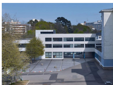
Bâtiment W : accueil, administration, façade ouest. La galerie de liaison avec l'externat N (à droite), permet
