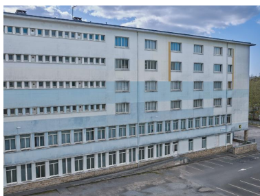
Bâtiment K, internat : détail de la façade est (J-B. Mathon, architecte). Vue prise des étages du bâtiment L. Phot. Bernard Bègne IVR53_20212900082NUCA
