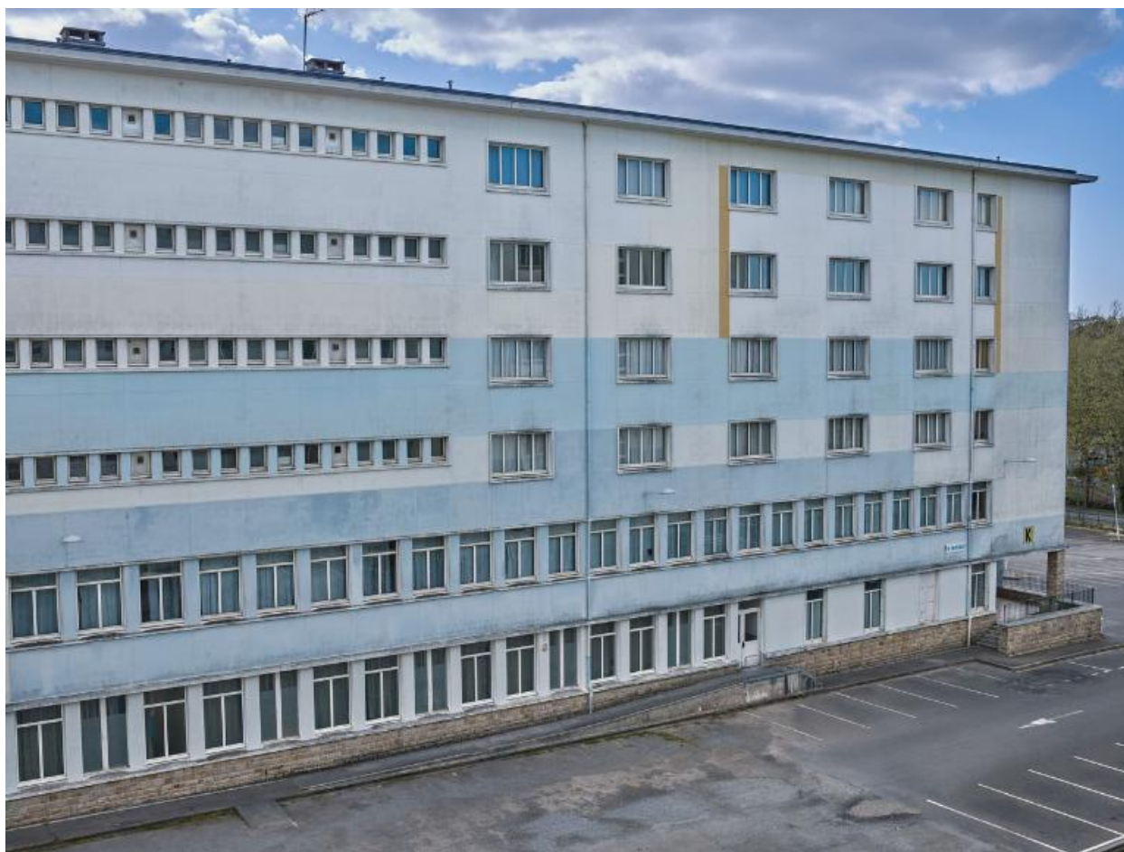
Bâtiment K, internat : détail de la façade est (J-B. Mathon, architecte). Vue prise des étages du bâtiment L.
