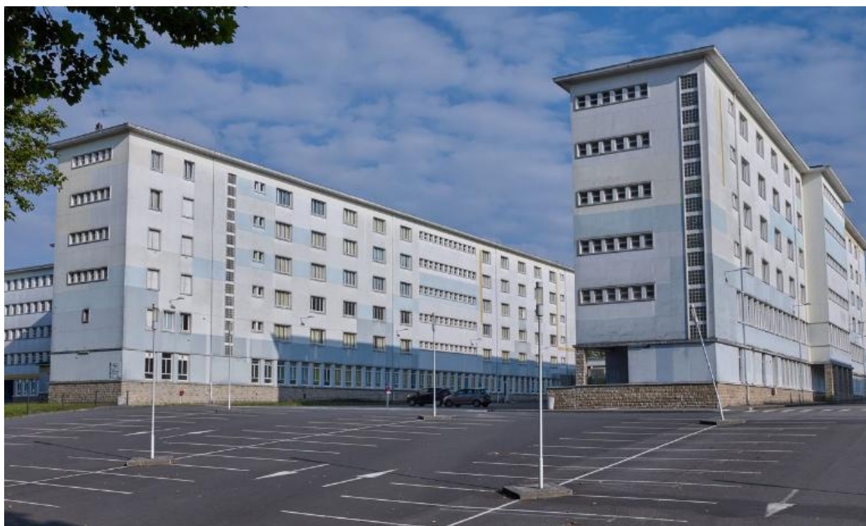
Bâtiment L et K, internats de garçons. A l'arrière plan à gauche : bâtiment N, externat du lycée technique. Vue prise du nord-ouest. J-B. Mathon, architecte.
