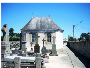
Morlaix, chapelle du cimetière Saint-Charles : élévation sud Phot. Gwénaél Fauchille IVR53_20082906613NUCA
