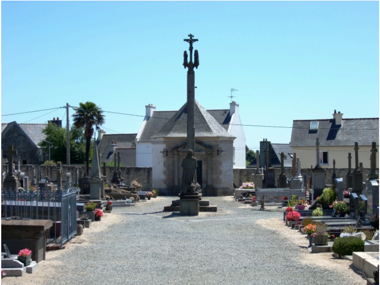
Morlaix, chapelle du cimetière Saint-Charles : vue de situation depuis l'ouest
