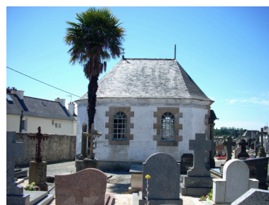
Morlaix, chapelle du cimetière Saint-Charles : élévation nord Phot. Gwénaél Fauchille IVR53_20082906612NUCA
