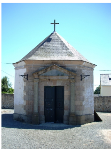
Morlaix, chapelle du cimetière Saint-Charles : élévation ouest Phot. Gwénaél Fauchille IVR53_20082906611NUCA
