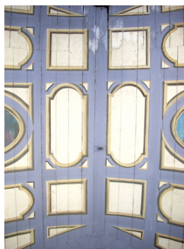
Morlaix, chapelle du cimetière Saint-Charles : lambris de couvrement dans la nef, détail Phot. Gwénaél Fauchille IVR53_20082906615NUCA
