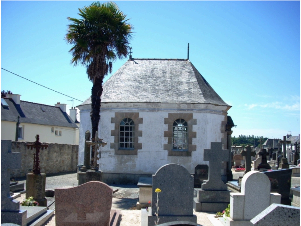
Morlaix, chapelle du cimetière Saint-Charles : élévation nord
