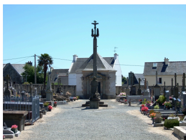
Morlaix, chapelle du cimetière Saint-Charles : vue de situation depuis l'ouest Phot. Gwénaél Fauchille IVR53_20082906610NUCA
