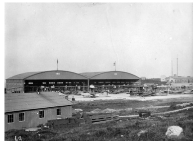
Vue générale des deux hangars, baraques et installations, 1918 (collection : Naval History and Heritage Command, UA 80.02.26). Des hydravions sont stationnés sur le terre-plein Phot. Auteur inconnu IVR53_20242911045NUC
