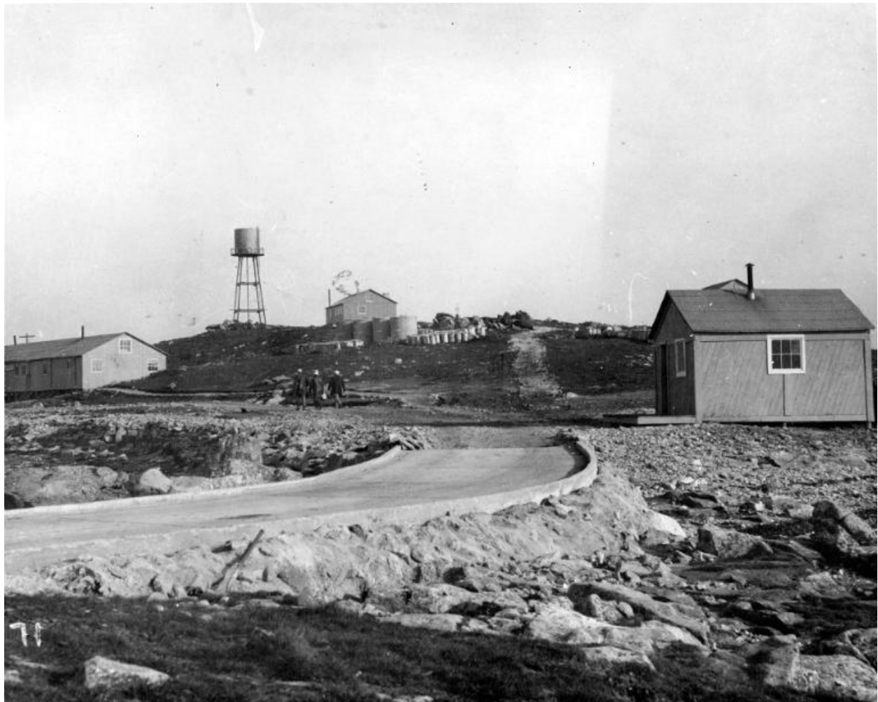
Vue de l'extrémité sud de l'île avec sa cale (collection : Naval History and Heritage Command, NH 113714). Dominant l'île, le château d'eau
