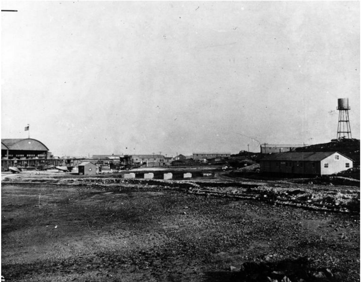
Vue générale des baraques et installations, 1918 (collection : Naval History and Heritage Command, NH 113723). A gauche, l'un des deux hangars ; à droite, le château d'eau
