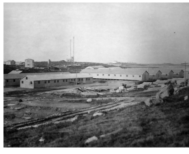
Vue générale des baraques et installations, 1918 (collection : Naval History and Heritage Command, UA 80.02.25) Phot. Auteur inconnu IVR53_20242911044NUC
