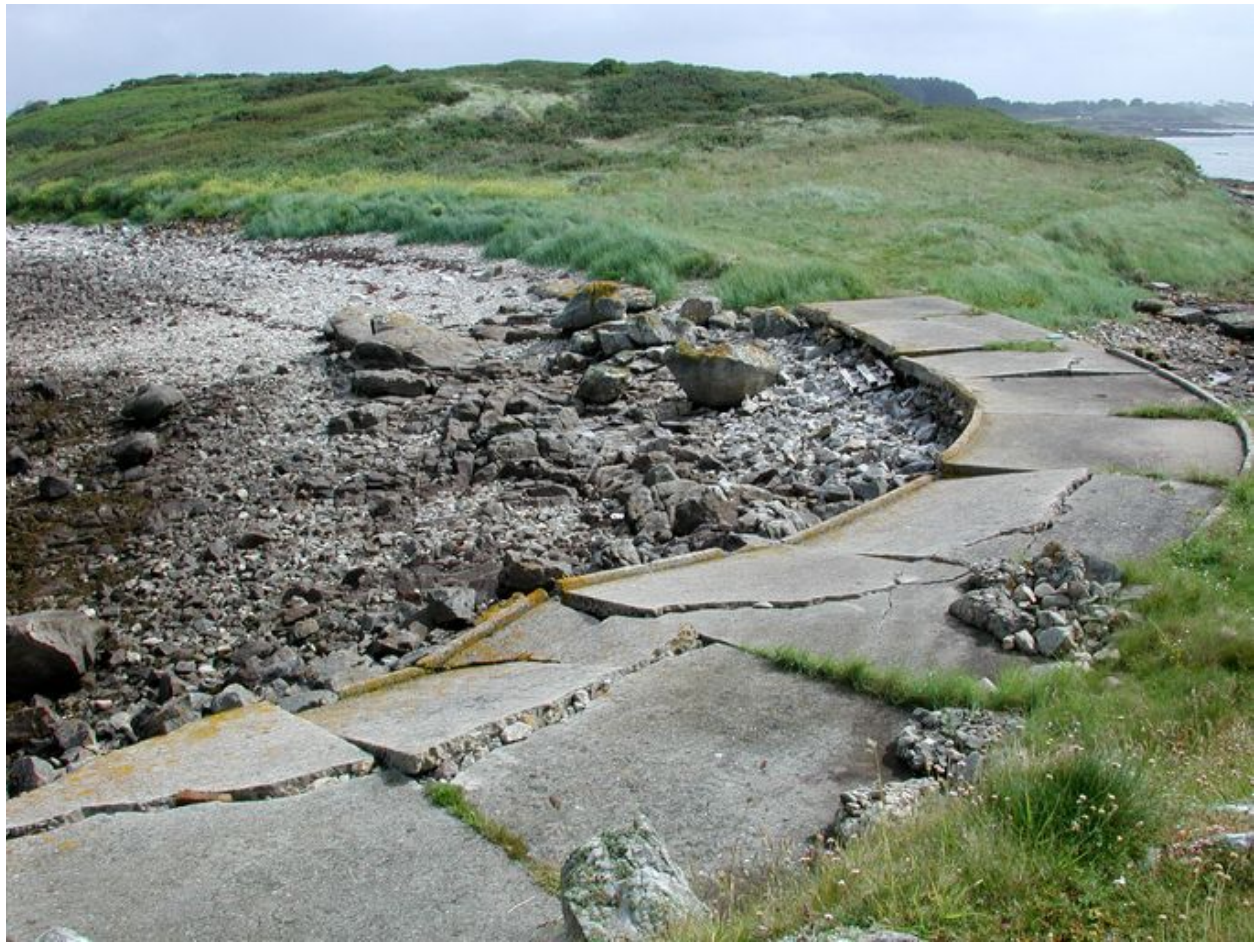
Vue de la cale sud du centre d'aviation maritime implanté durant la Première Guerre mondiale (état en 2002)
