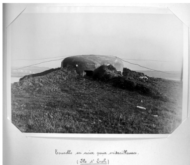
Vue de la cloche blindée pour mitrailleuse de l'ensemble fortifié de Énez Terc'h (photographie extraite du rapport Pinczon du Sel). Couronnant un bunker de type 634, elle a été ferraillée Phot. Guillaume Lécueillier IVR53_20032901660NUCA
