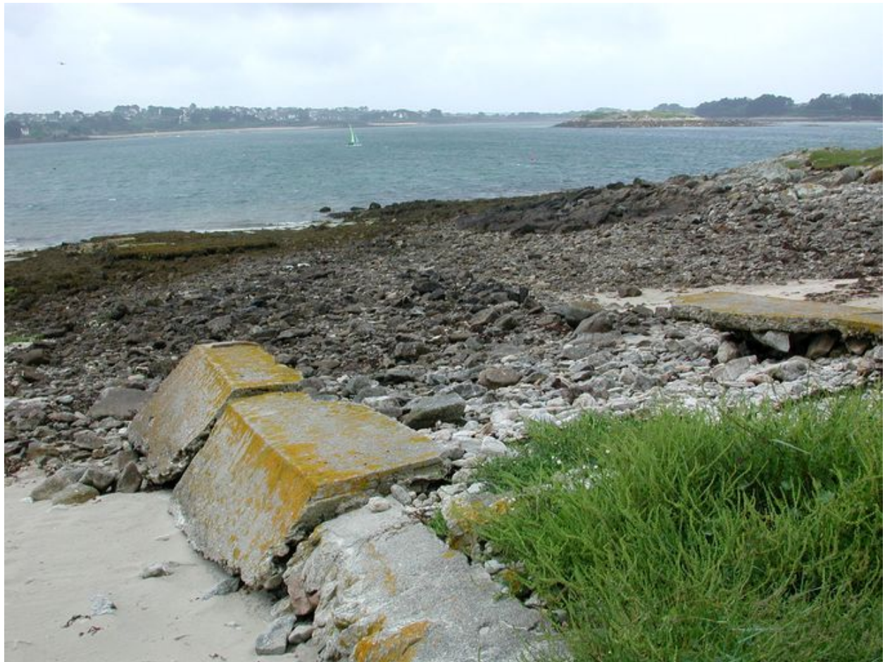
Vue de la cale nord du centre d'aviation maritime implanté durant la Première Guerre mondiale (état en 2002)
