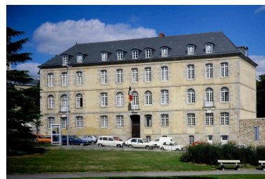
Vue générale prise du nord-ouest. Phot. Guy Artur IVR53_19863500771VA
