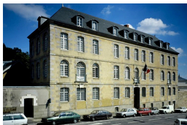
Vue générale prise du nord-ouest. Phot. Guy Artur IVR53_19863500769VA
