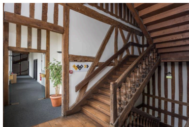
Intérieur, cage de l'escalier central en pan de bois Phot. Charlotte Barraud IVR53_20213500283NUCA
