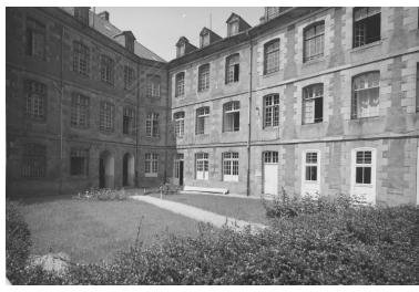
L'aile de droite a été détruite. Les arcs segmentaires de fenêtres sont des caractéristiques du 18ème siècle. Phot. François Dagorn IVR53_19663500008V
