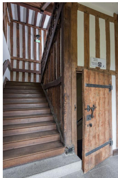
Intérieur, cage de l'escalier central en pan de bois Phot. Charlotte Barraud IVR53_20213500282NUCA
