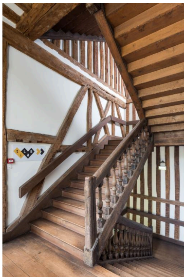
Intérieur, cage de l'escalier central en pan de bois Phot. Charlotte Barraud IVR53_20213500284NUCA
