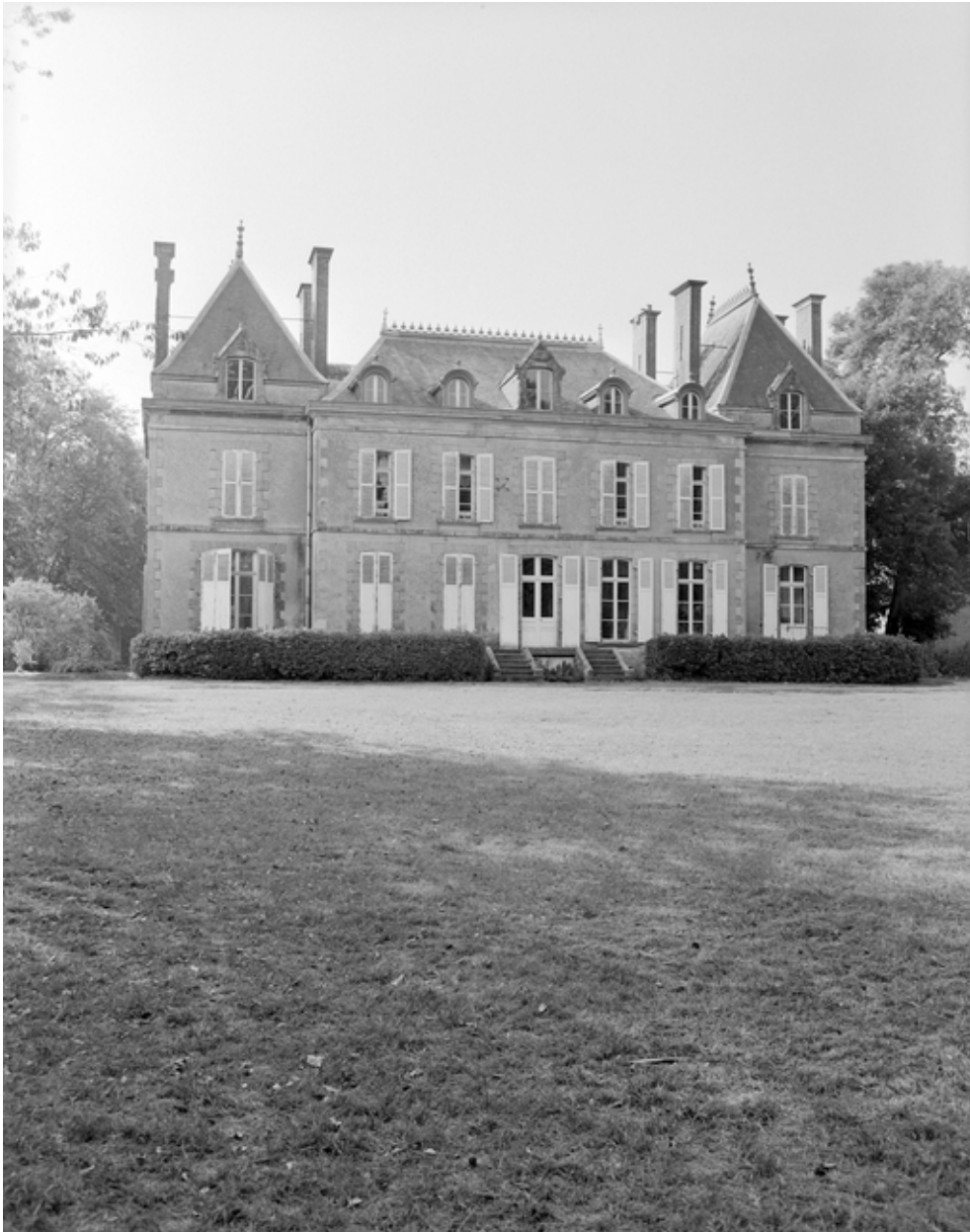
Château, élévation nord, vue générale.
