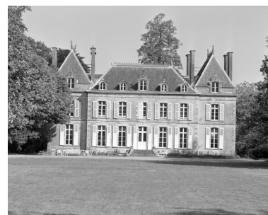
Château, élévation sud, vue générale. Phot. Guy Artur, Phot. Norbert Lambart IVR53_19963501624X
