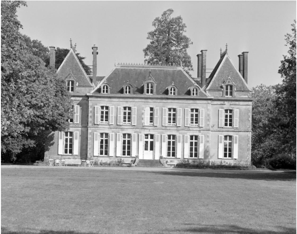
Château, élévation sud, vue générale.
