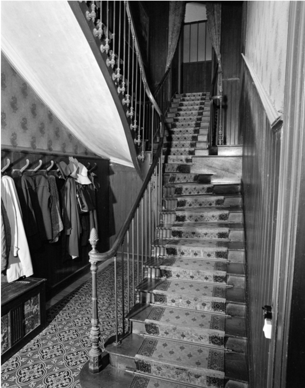
Rez-de-chaussée, escalier de distribution intérieure.
