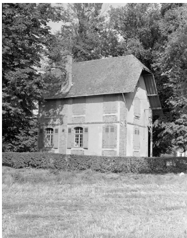
Conciergerie, vue générale sud. Phot. Guy Artur, Phot. Norbert Lambart IVR53_19963501626X
