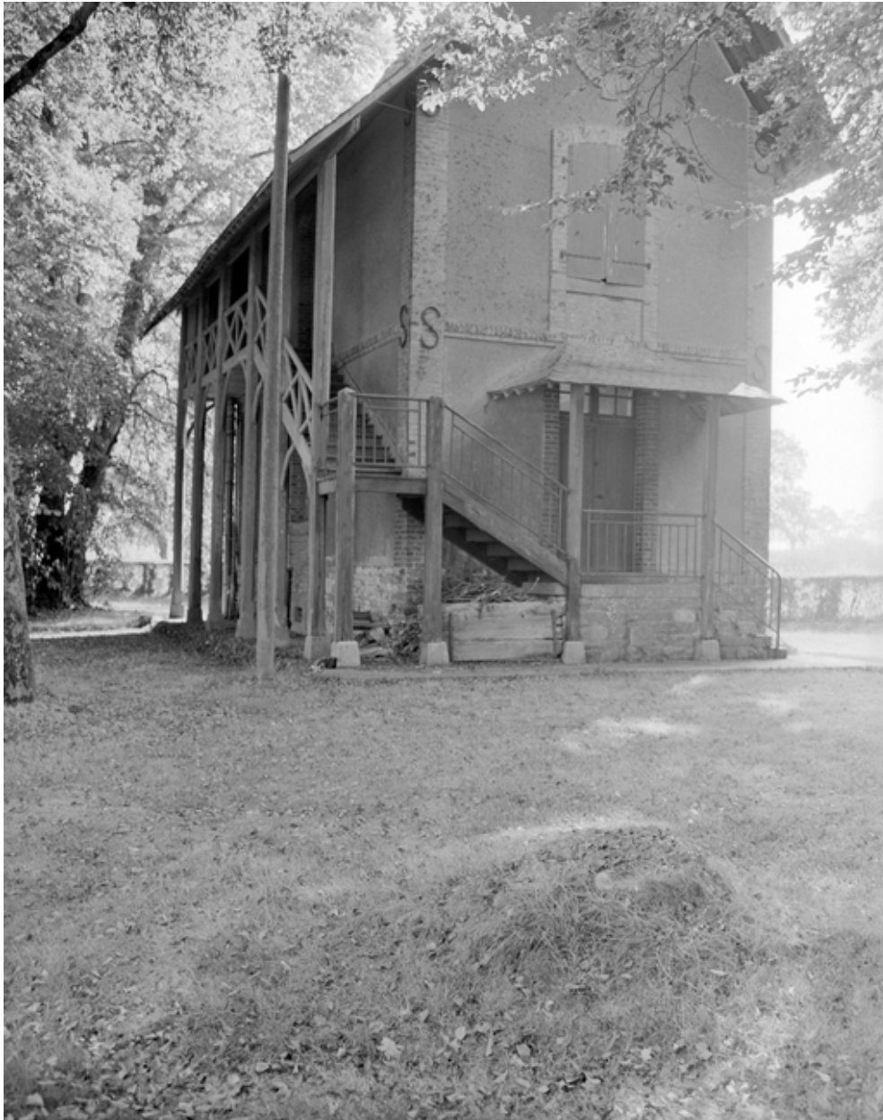
Conciergerie, vue générale nord.
