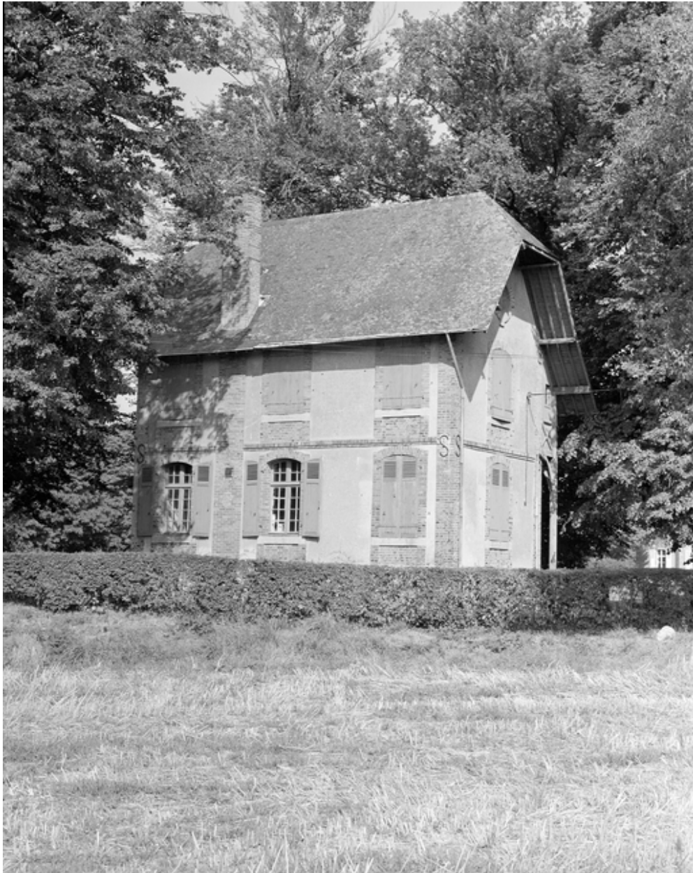
Conciergerie, vue générale sud.
