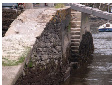
Rampe et escalier au bout du quai Polignac Phot. Florence Despretz IVR53_20072909094NUCA
