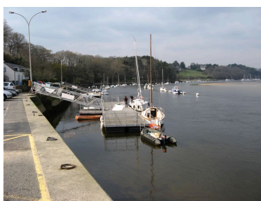
Quai en béton Phot. Guillaume Marie IVR53_20072909092NUCA
