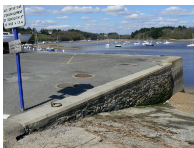
Quai en béton et haut de la petite cale Phot. Julien Amghar IVR53_20082908655NUCA
