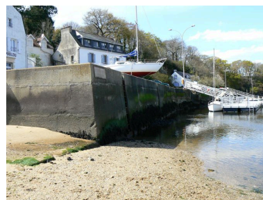
Quai en béton et extrémité inférieure de la petite cale Phot. Julien Amghar IVR53_20082908650NUCA
