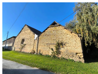
8 La Porte Phot. Maélys VALLET IVR53_20263510403NUCA
