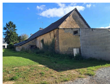
20 rue des Cruaux Phot. Emma Coudrai IVR53_20263510398NUCA
