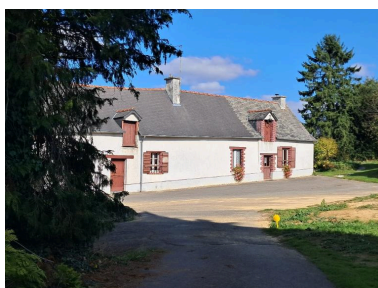
20 rue des Cruaux Phot. Emma Coudrai IVR53_20263510399NUCA
