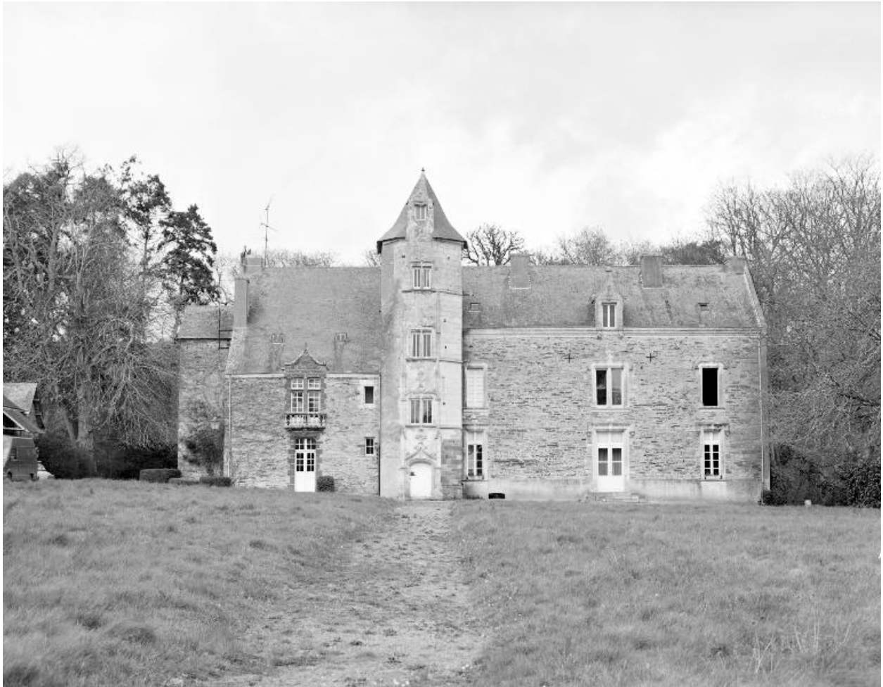
Élévation sud : vue générale
