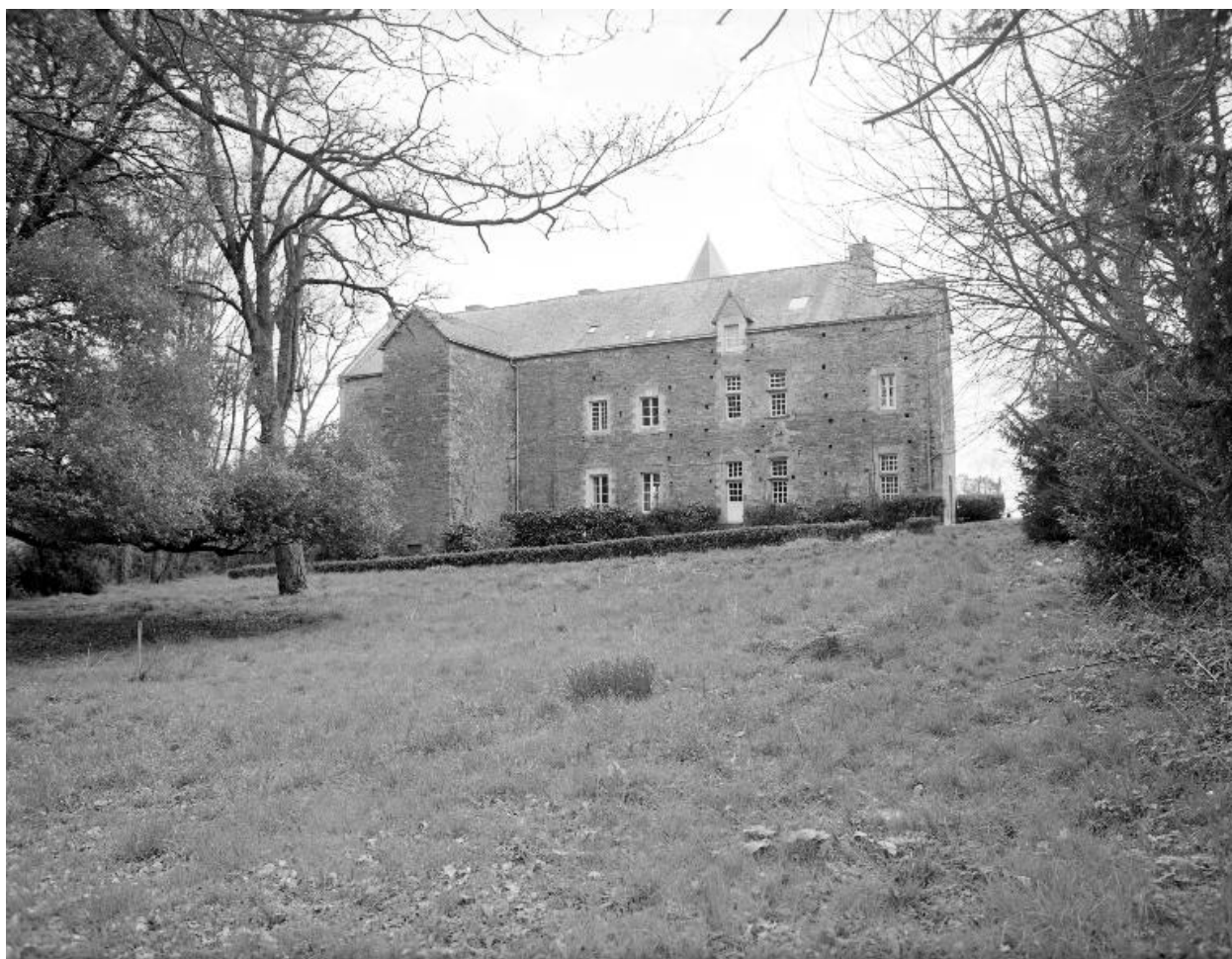
Élévation nord : vue générale
