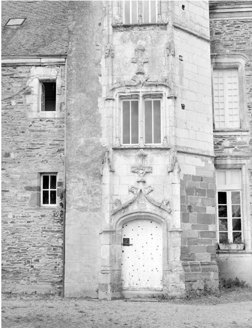
Élévation sud, tour d'escalier : vue générale des deux niveaux inférieurs
