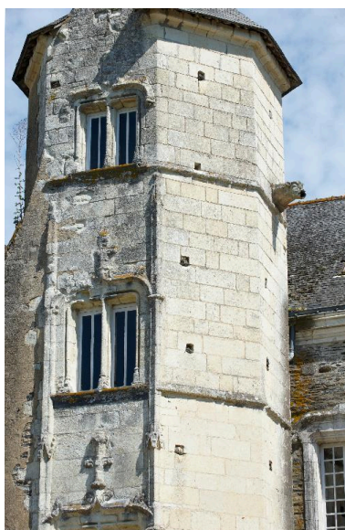
Élévation de la tour d'escalier Phot. Bernard Bègne IVR53_20155600269NUCA
