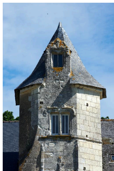
Partie supérieure de la tour d'escalier Phot. Bernard Bègne IVR53_20155600264NUCA
