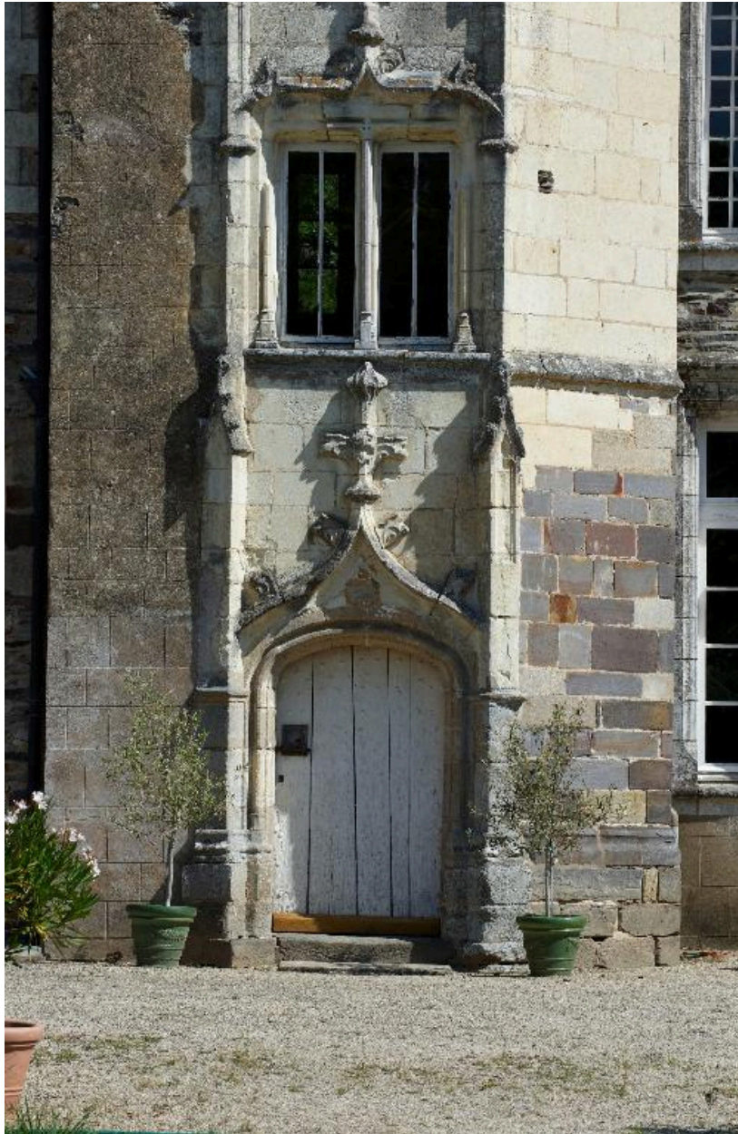
Partie inférieure de la tour d'escalier
