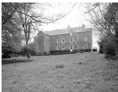
Élévation nord : vue générale Phot. Norbert Lambart IVR53_19835600470X
