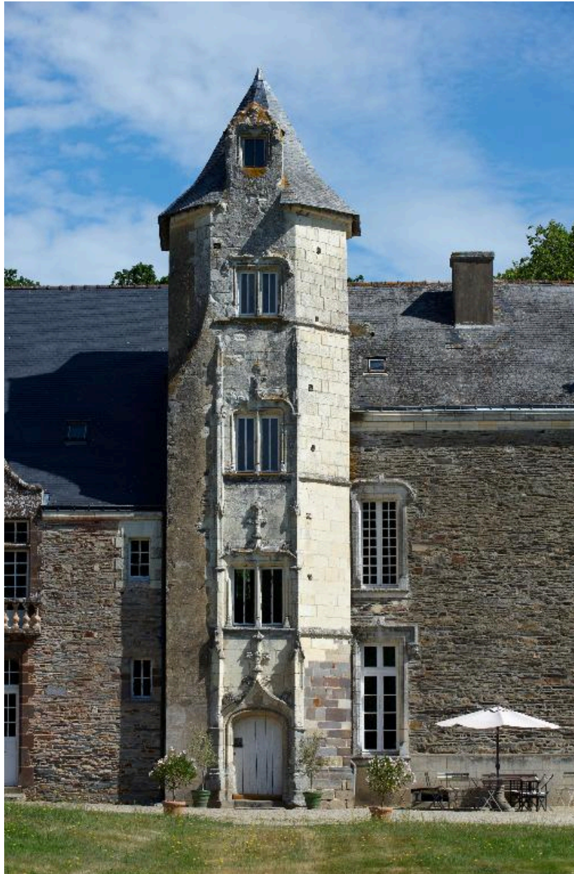
Vue rapprochée de la tour d'escalier
