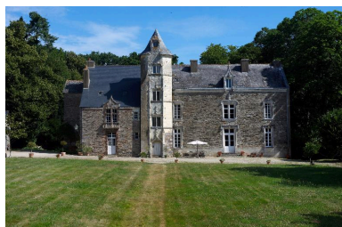
Vue générale : vue du sud Phot. Bernard Bègne IVR53_20155600263NUCA
