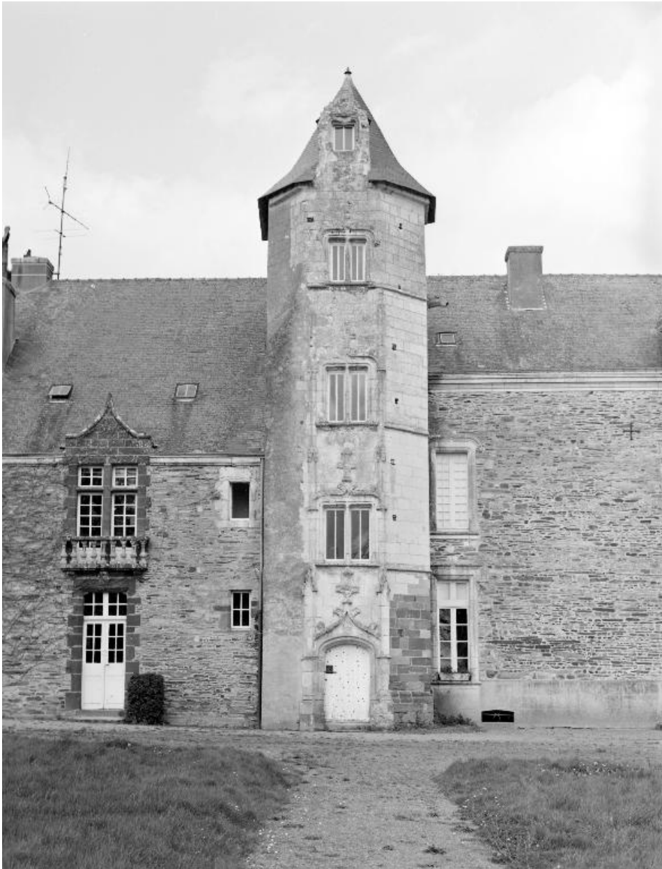
Élévation sud : vue générale de la tour d'escalier
