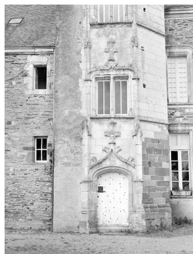
Élévation sud, tour d'escalier : vue générale des deux niveaux inférieurs Phot. Norbert Lambart IVR53_19835600469X
