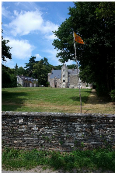
Vue générale : vue du sud Phot. Bernard Bègne IVR53_20155600293NUCA
