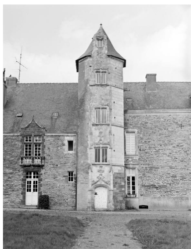
Élévation sud : vue générale de la tour d'escalier Phot. Norbert Lambart IVR53_19835600468X
