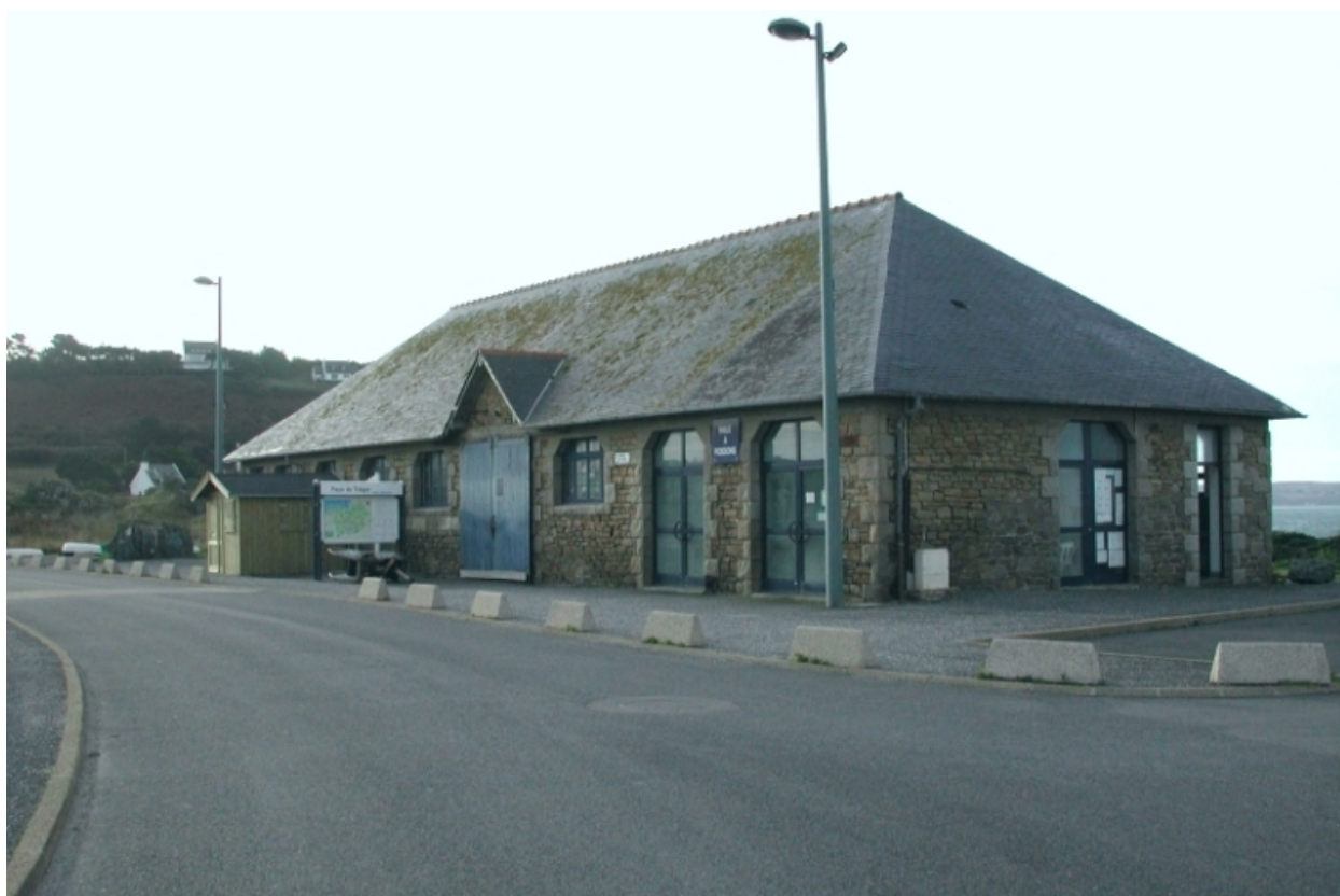
Vue générale des halles
