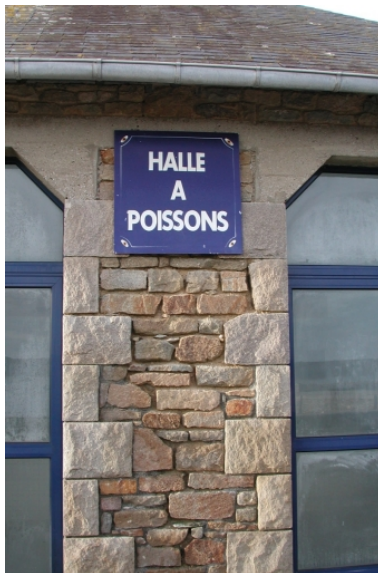
Détail des murs des halles Phot. Guy Prigent IVR53_20042204346NUCA
