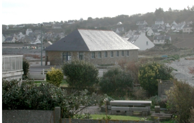
Le bâtiment des halles dans son environnement Phot. Guy Prigent IVR53_20042204347NUCA
