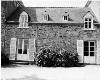
Elévation nord-est, détail de la partie centrale. Phot. Guy Artur, Phot. Norbert Lambart IVR53_19925600920X
