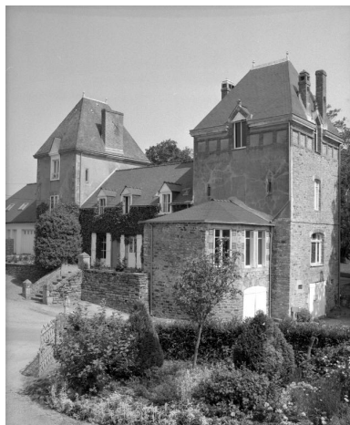
Vue générale sud. Phot. Guy Artur, Phot. Norbert Lambart IVR53_19925600928X
