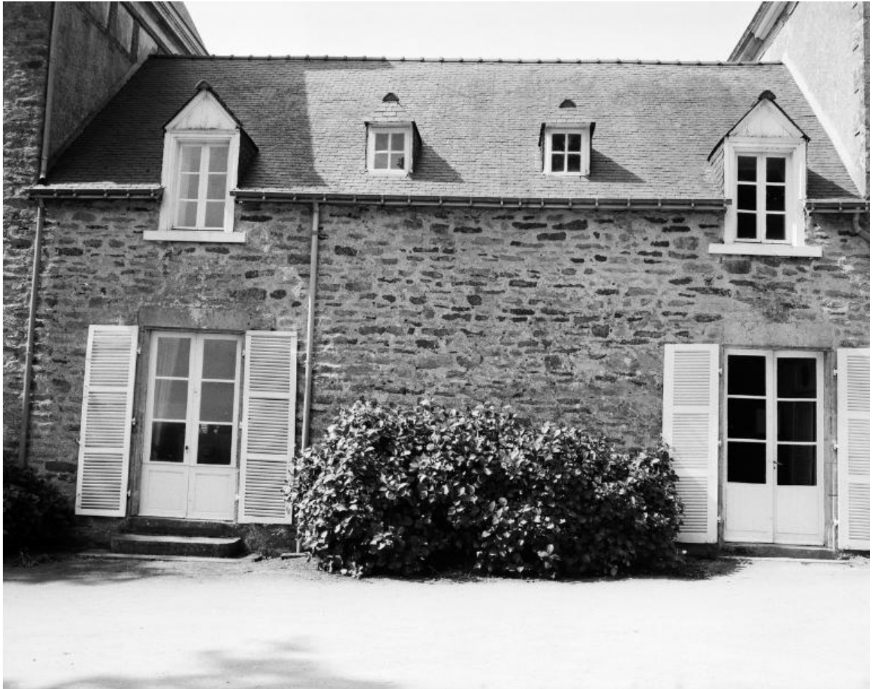
Elévation nord-est, détail de la partie centrale.
