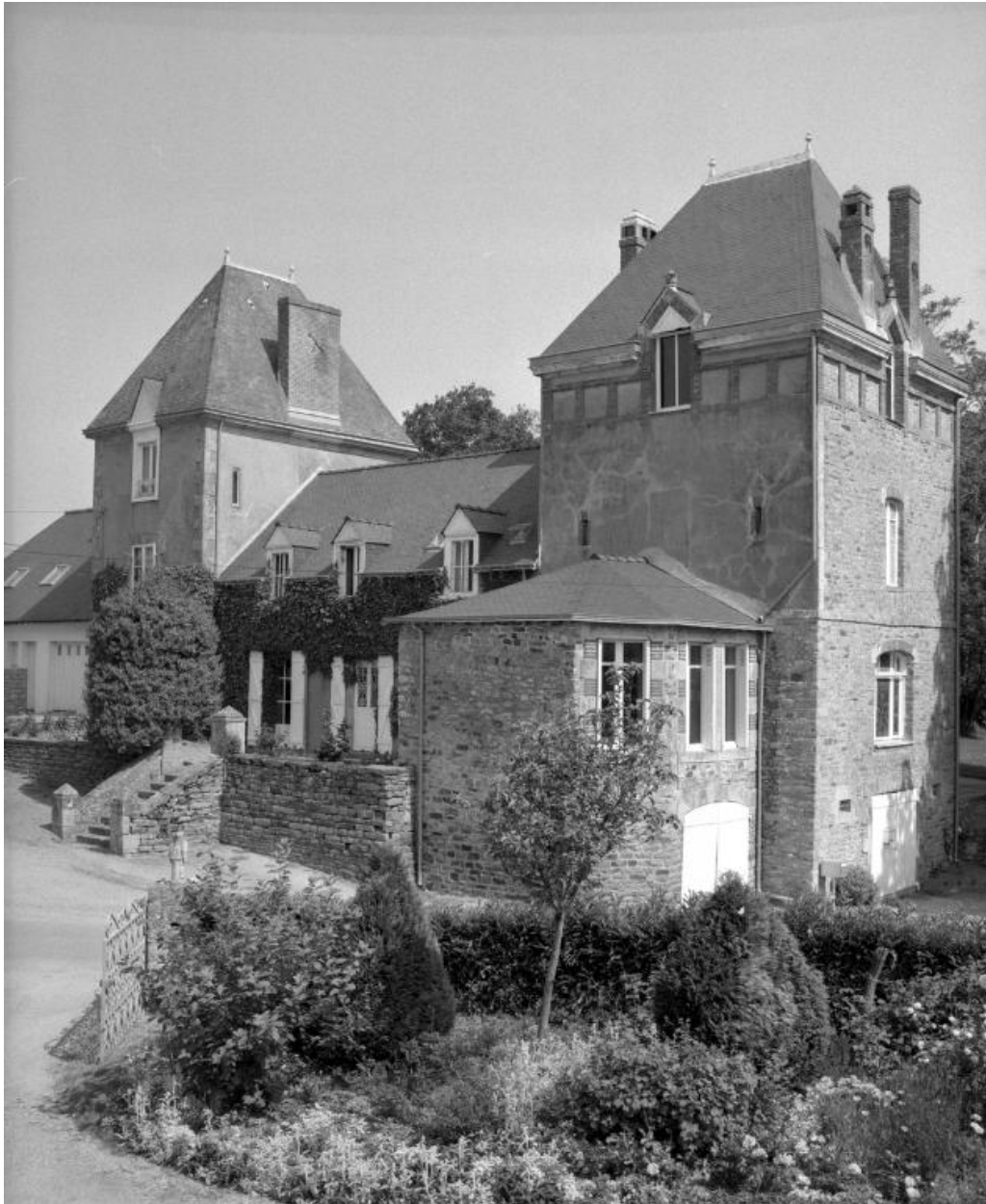
Vue générale sud.
