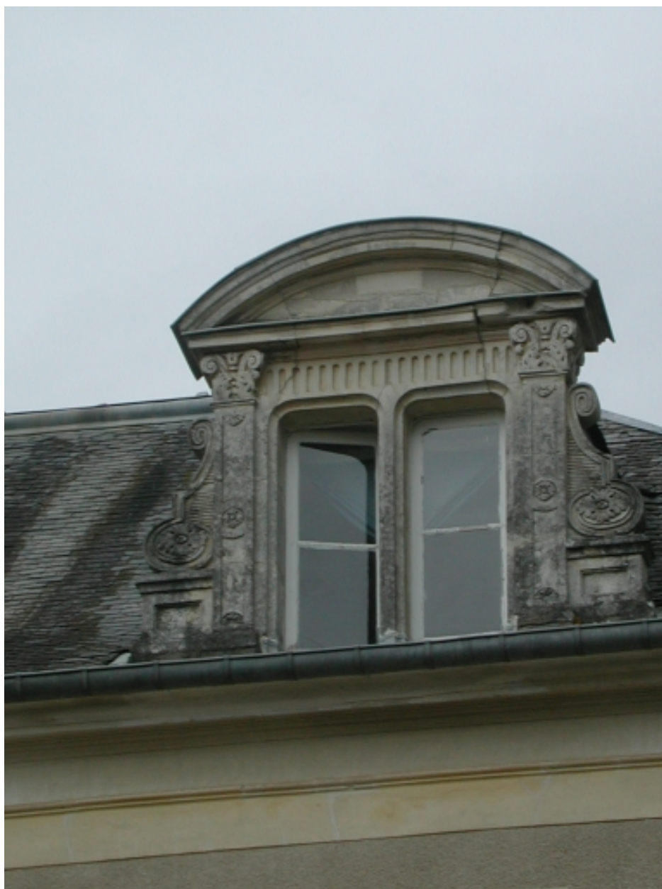
Détail d'une lucarne du corps de logis principal
