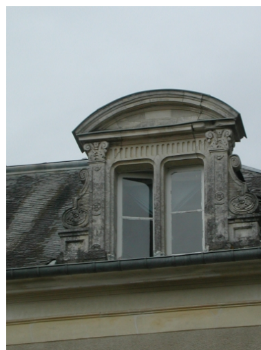
Détail d'une lucarne du corps de logis principal Phot. Sabrina Dalibard IVR53_20033514720NUCA
