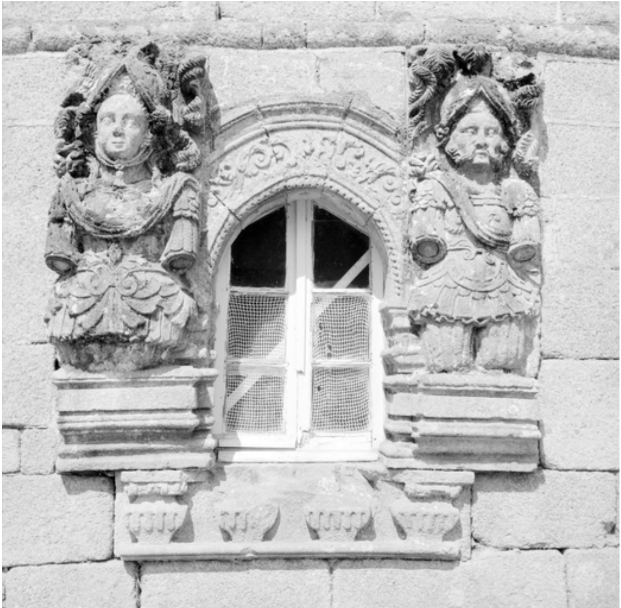
Maison A : fenêtre au nord de la façade est
