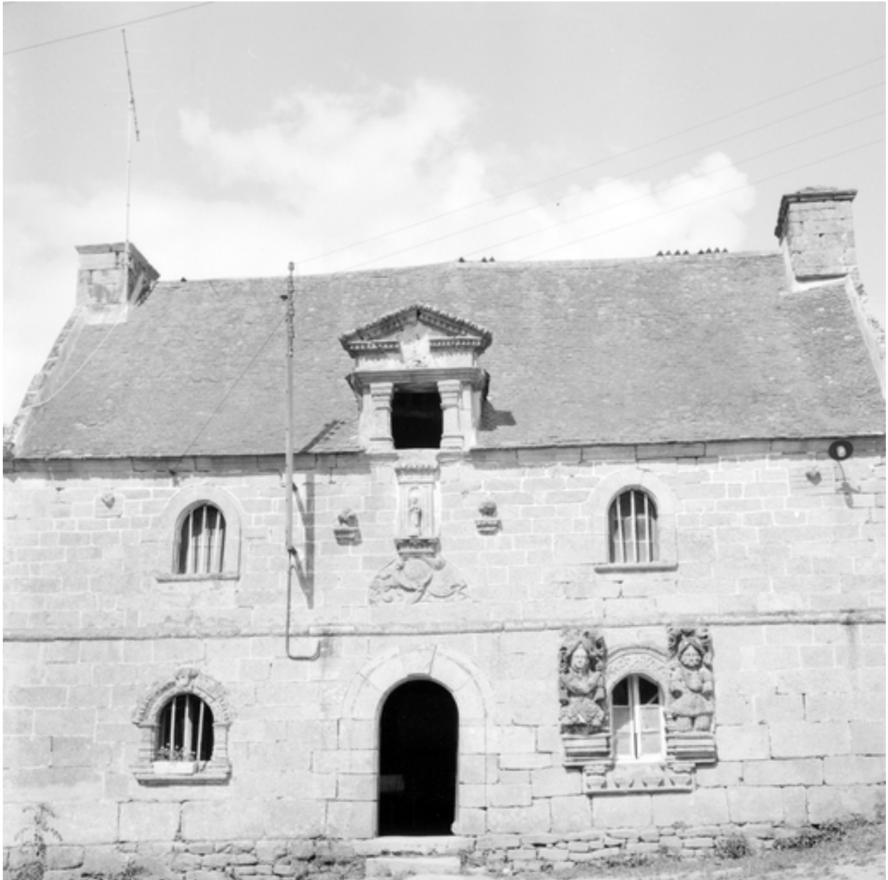
Maison A : vue d'ensemble de la façade est
