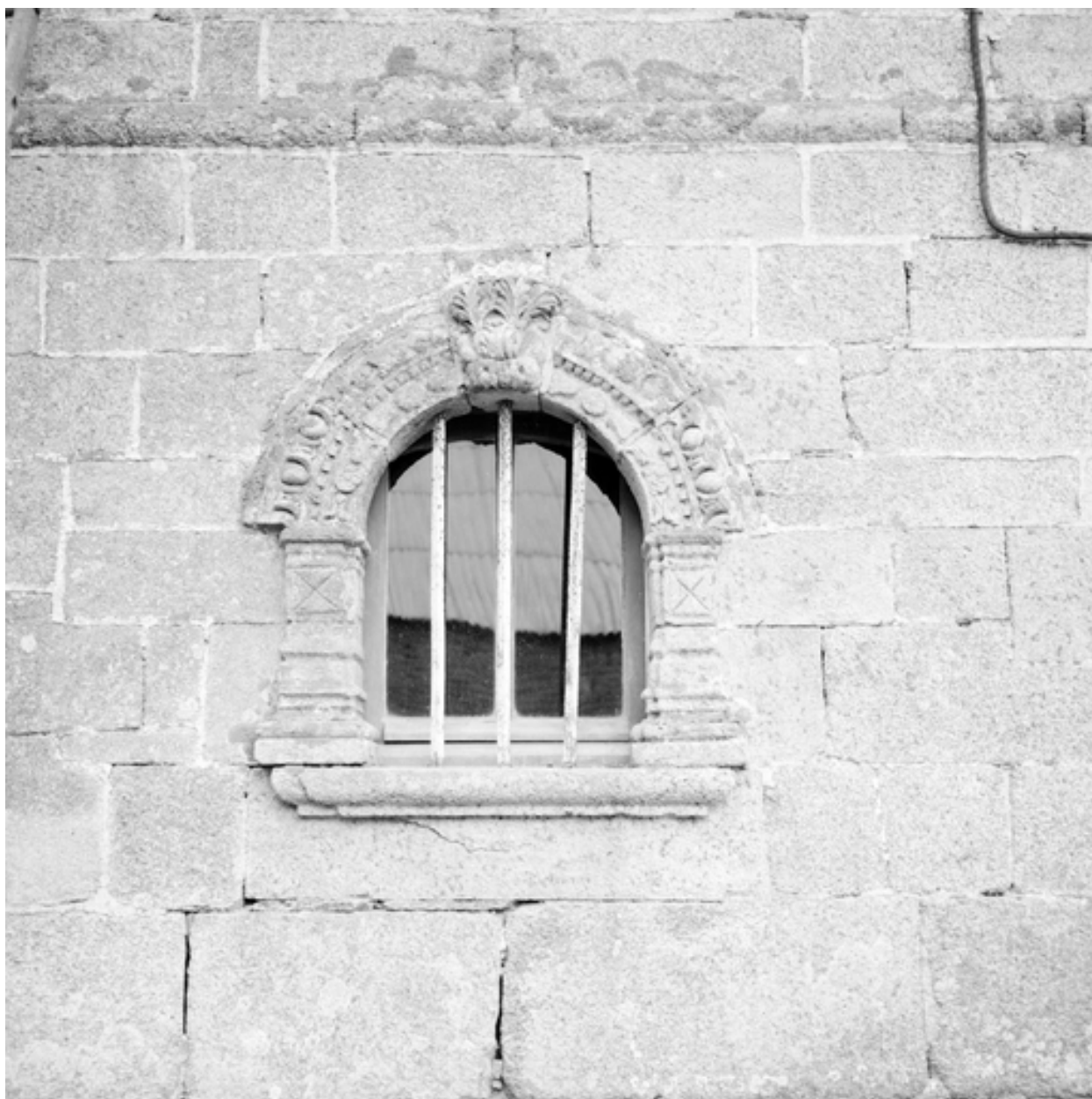
Maison A : fenêtre au sud sur la façade est
