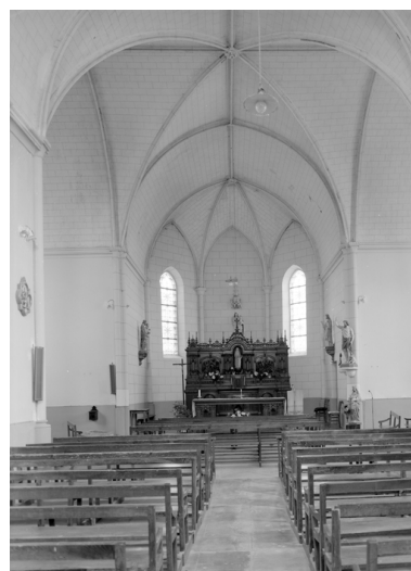
Chapelle : vue générale de la nef (état en 1984) Phot. Norbert Lambart IVR53_19845601665V
