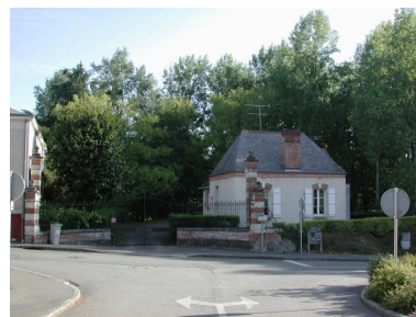
Entrée et conciergerie Phot. Véronique Orain IVR53_20013515286NUCA
