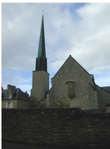
Vue du chevet et de la flèche de l'église Phot. Isabelle Barbedor IVR53_20003518375NUCA
