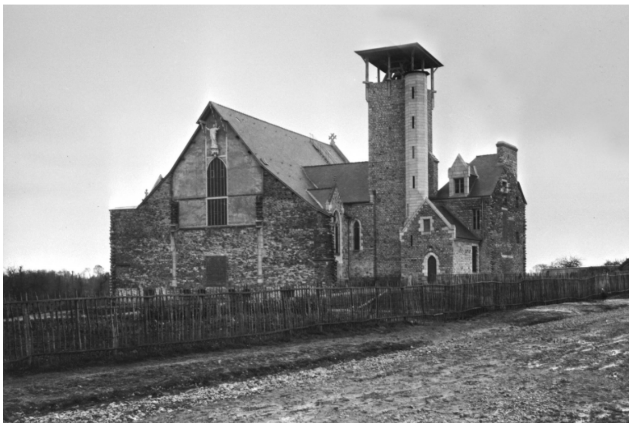
Vue de l'église en construction, photographie, 1er quart 20e siècle
