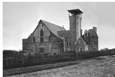
Vue de l'église en construction, photographie, 1er quart 20e siècle Repro. Guy Artur, Repro. Norbert Lambart IVR53_19993500215X
