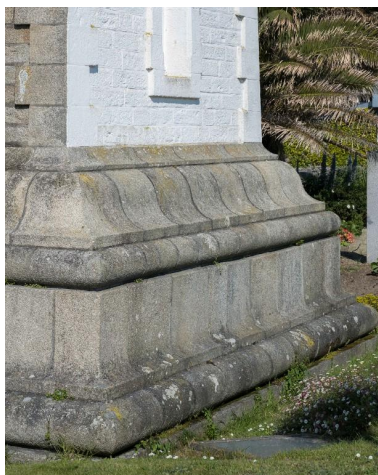
Soubassement carré du phare : mise en oeuvre du granite, corniche en doucine Phot. Charlotte Barraud IVR53_20252901040NUCA
