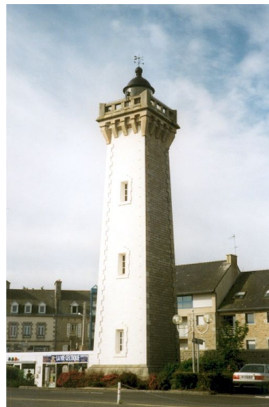
Vue générale (état en 2001) Phot. Francis Dreyer IVR53_20042902643NUCA
