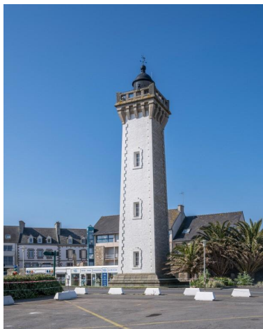
Phare de Roscoff depuis le terre-plein du quai d'Auxerre Phot. Charlotte Barraud IVR53_20252901043NUCA
