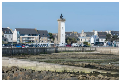
Phare de Roscoff dans son environnement portuaire et urbain Phot. Charlotte Barraud IVR53_20252901038NUCA
