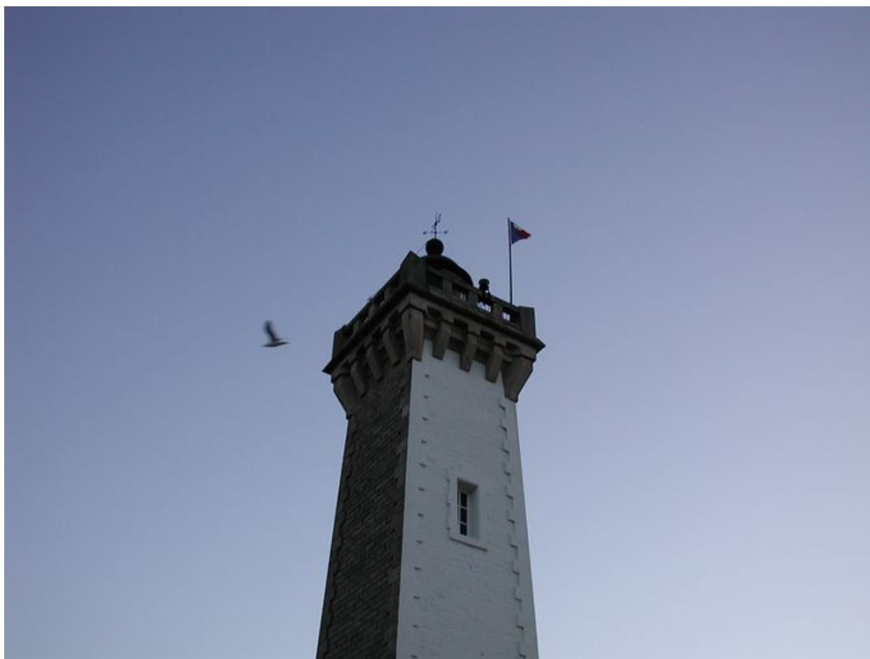
Vue de la partie sommitale (état en 2002)
