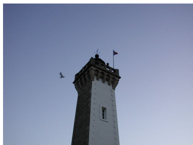
Vue de la partie sommitale (état en 2002) Phot. Guillaume Lécueillier IVR53_20022901932NUCA
