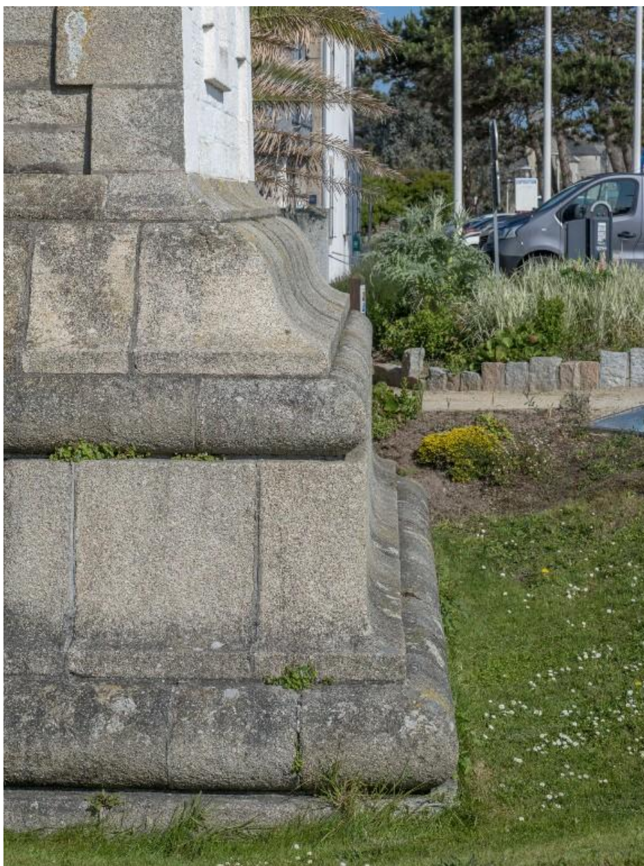
Soubassement carré du phare : mise en oeuvre du granite, corniche en doucine
