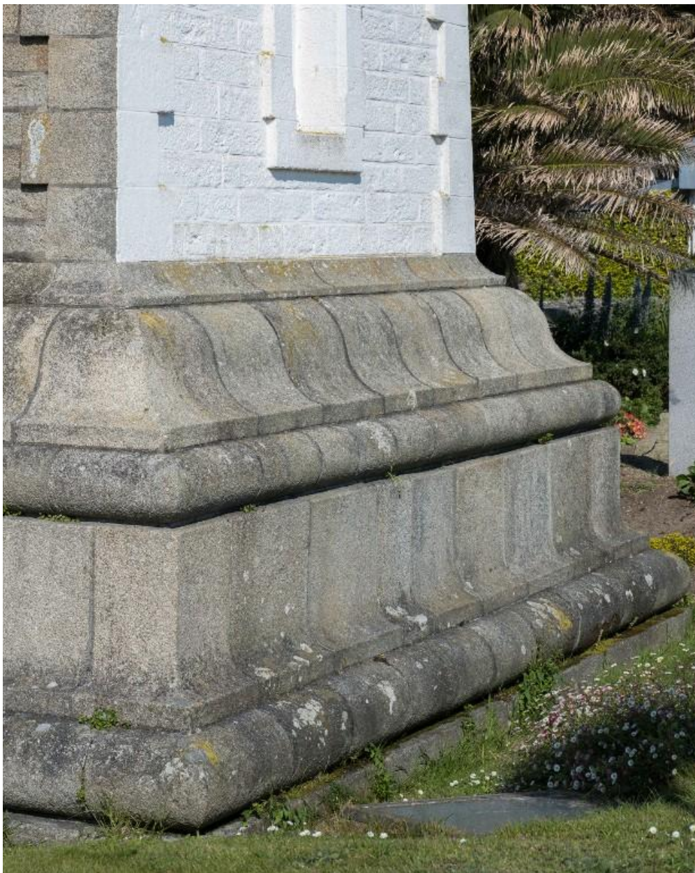
Soubassement carré du phare : mise en oeuvre du granite, corniche en doucine
