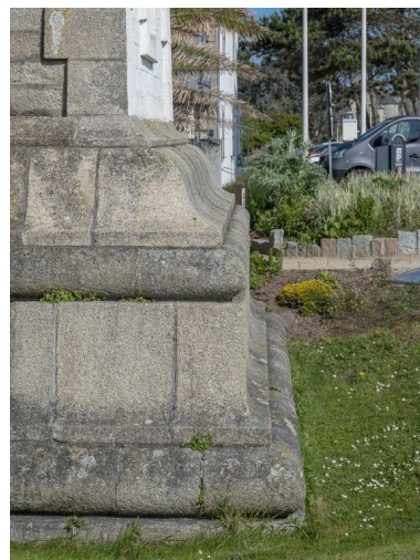
Soubassement carré du phare : mise en oeuvre du granite, corniche en doucine Phot. Charlotte Barraud IVR53_20252901041NUCA
