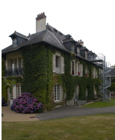
Vue générale arrière de la maison de maître Phot. Guy Artur, Phot. Norbert Lambart IVR53_20033501364NUCA
