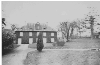
Vue générale de la façade antérieure (état en 1973) Phot. Auteur inconnu IVR53_20033510647NUC
