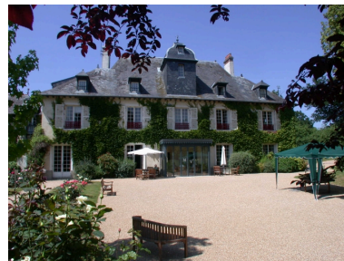
Vue générale de la maison de maître Phot. Véronique Orain IVR53_20033511103NUCA
