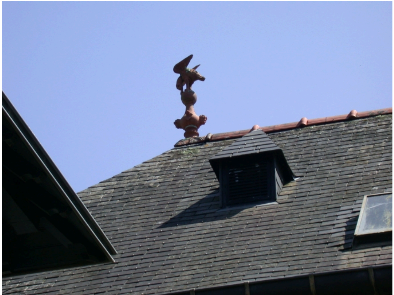
Villa située à proximité de la maison de maître : épi de faitage
