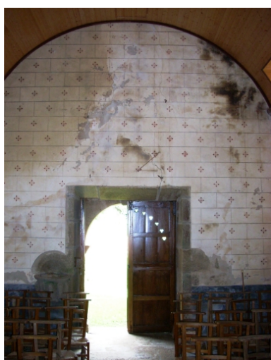
Lannilis, chapelle Saint-Sébastien : vue axiale ouest Phot. Gwénaél Fauchille IVR53_20082906137NUCA
