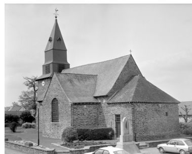
Vue générale sud est Phot. Guy Artur, Phot. Norbert Lambart IVR53_19943500823X
