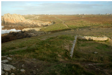
Vue générale : parapet en terre avec mur de genouillère en maçonnerie Phot. Guillaume Lécueillier IVR53_20062903132NUCA
