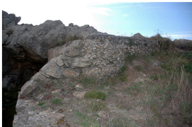
Vue de détail de la dalle de couverture des deux niches à munitions pour projectiles de 95 mm Phot. Guillaume Lécueillier IVR53_20062903135NUCA
