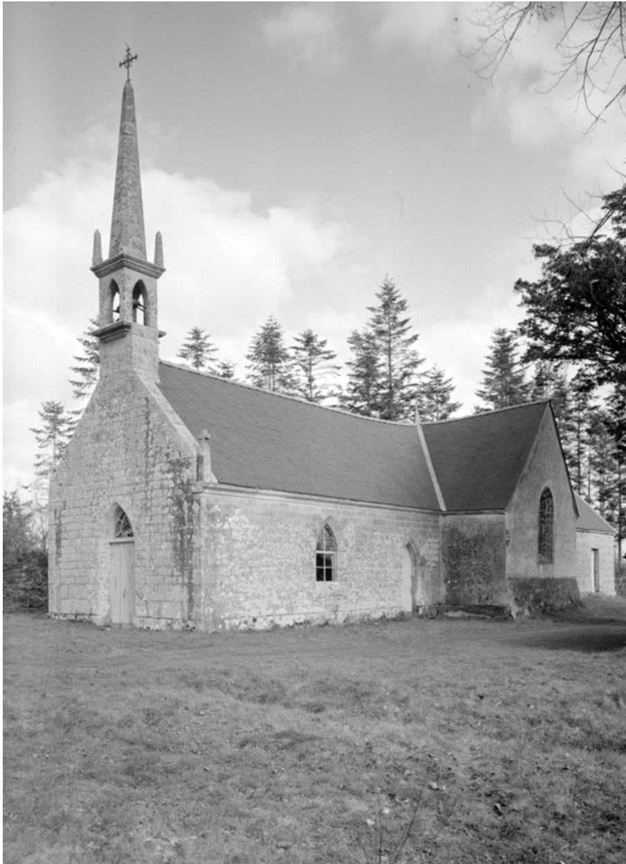
Vue de situation prise du sud-ouest.
