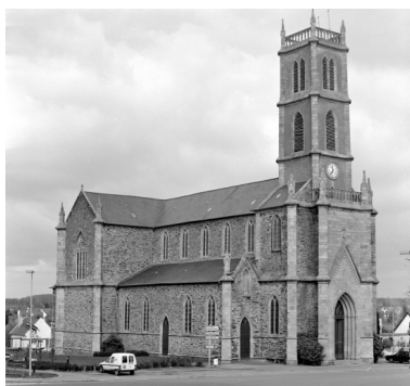
Elévation Nord-Ouest : vue générale Phot. Guy Artur, Phot. Norbert Lambart IVR53_19943500843X
