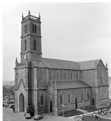
Elévation Sud-Ouest : vue générale Phot. Guy Artur, Phot. Norbert Lambart IVR53_19943500866X
