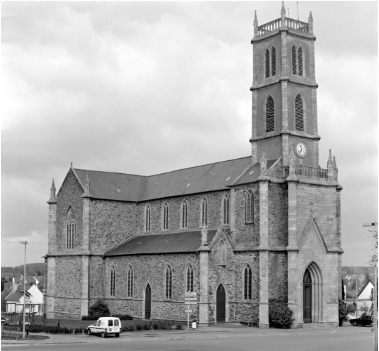
Elévation Nord-Ouest : vue générale
