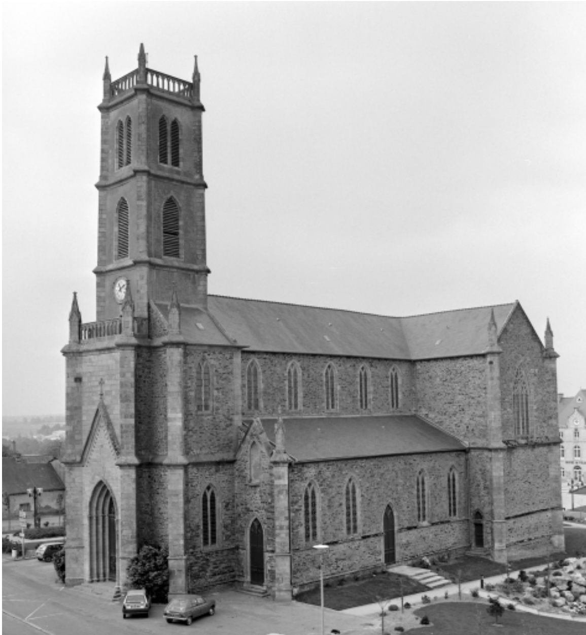
Elévation Sud-Ouest : vue générale
