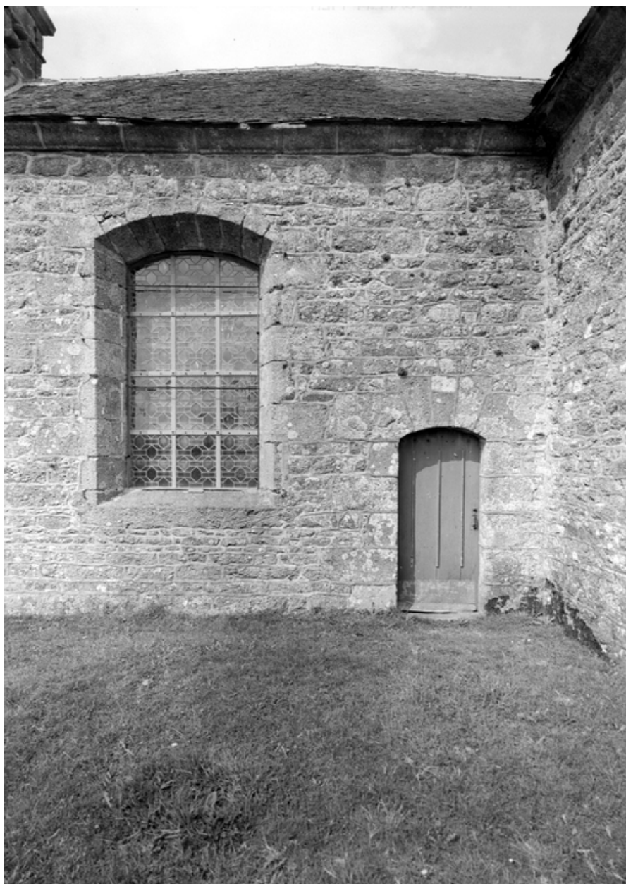
Porte et fenêtre de la façade sud de la nef
