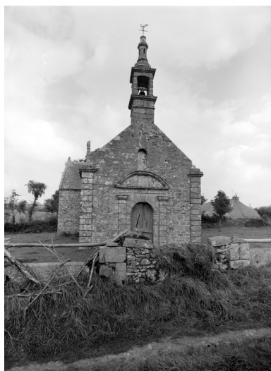
Vue de la façade ouest Phot. Guy Artur IVR53_19682201063X
