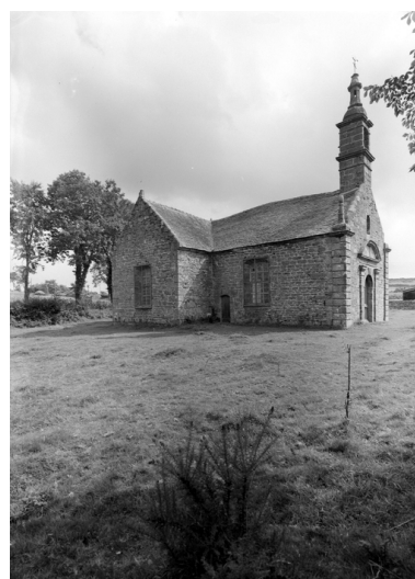
Vue générale nord-ouest Phot. Guy Artur IVR53_19682201068X
