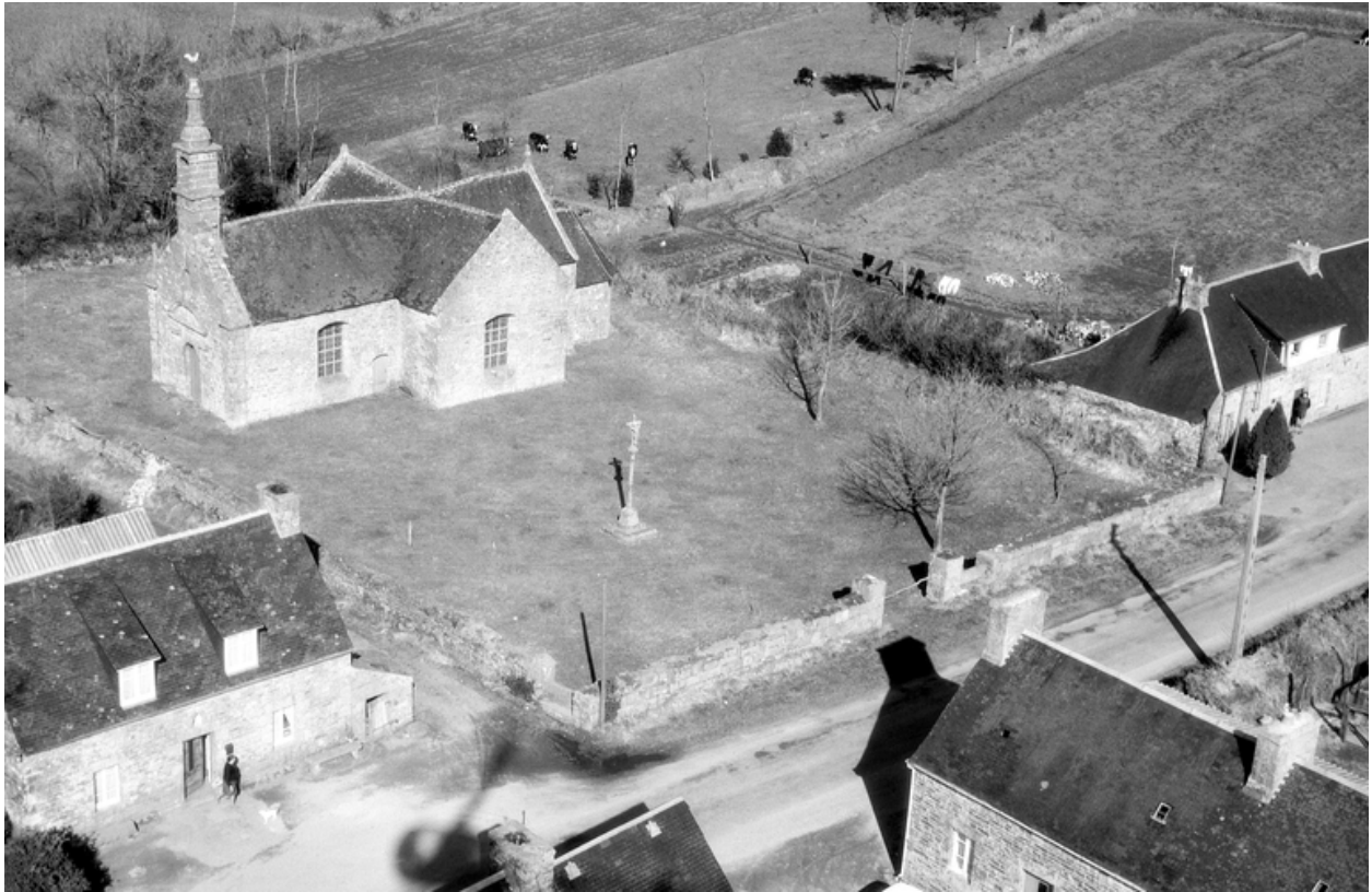
Vue aérienne prise du sud-ouest
