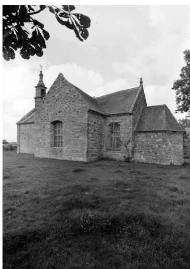
Vue générale sud-est Phot. Guy Artur IVR53_19682201067X
