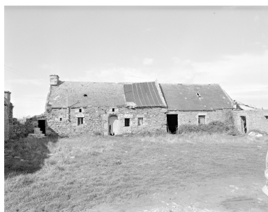
Vue générale antérieure sud. (1979) Phot. Guy Artur IVR53_19792900244X
