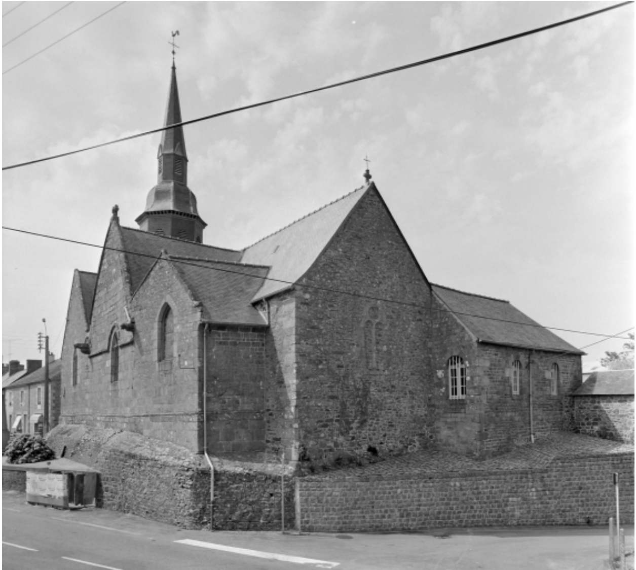
Elévation Sud-Est : vue générale
