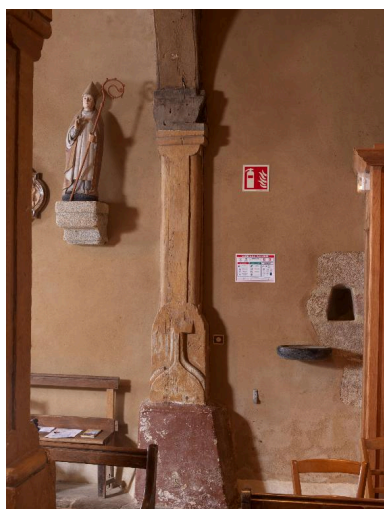
Intérieur, pilier d'arcade en bois Phot. Bernard Bègne IVR53_20133501940NUCA
