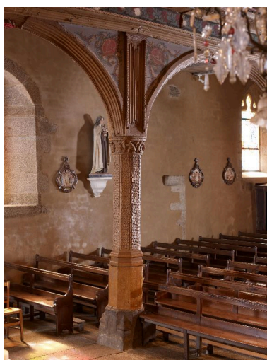
Vue générale d'un pilier entièrement en bois Phot. Bernard Bègne IVR53_20133501938NUCA
