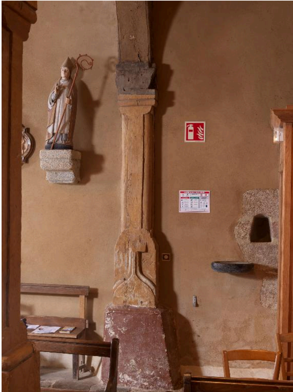
Intérieur, pilier d'arcade en bois
