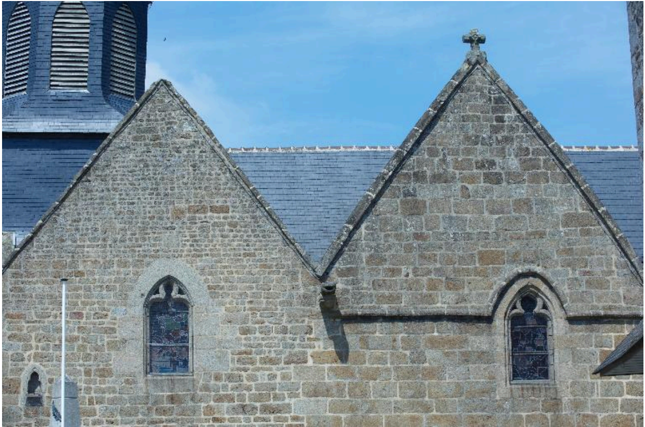
Détail de la façade sud de l'église
