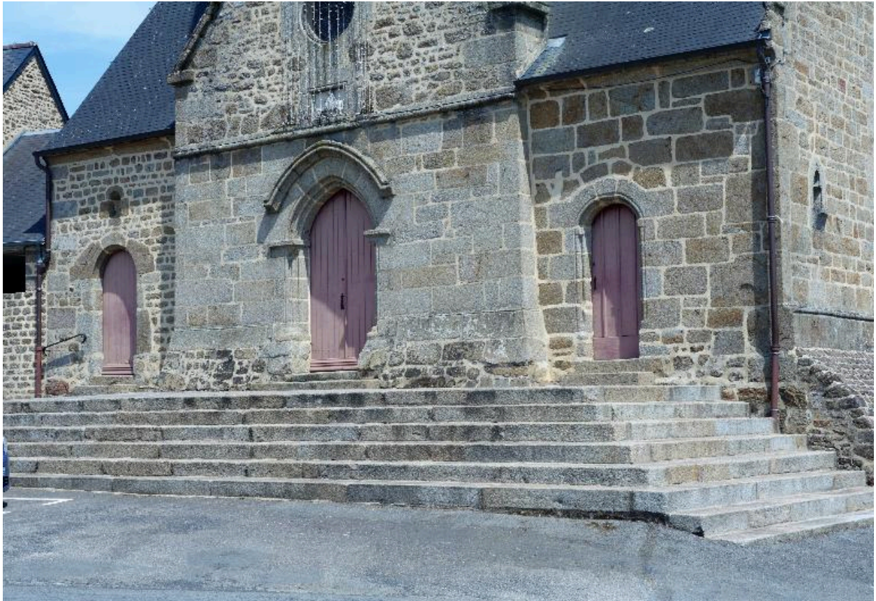
Façade ouest de l'église
