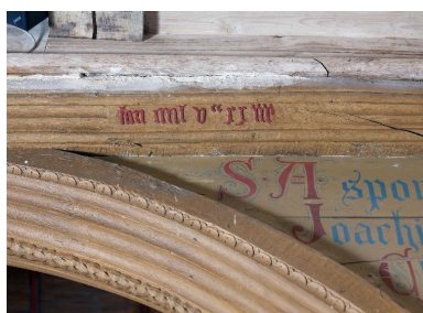
Inscription gothique sur la sablère du bas-côté sud Phot. Bernard Bègne IVR53_20133501937NUCA
