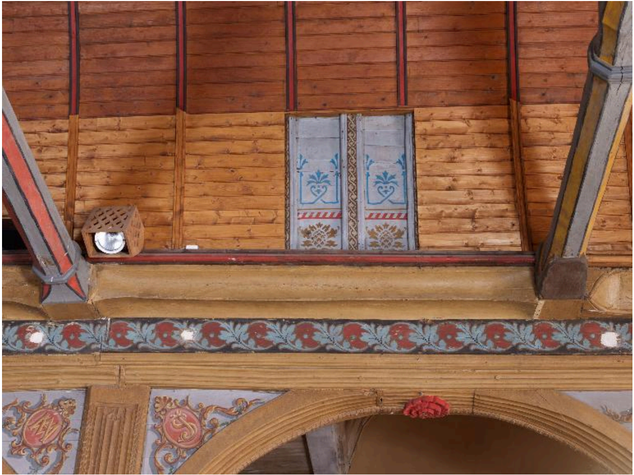
Vue de l'ancien et du nouveau lambris de revêtement de la voûte de la nef
