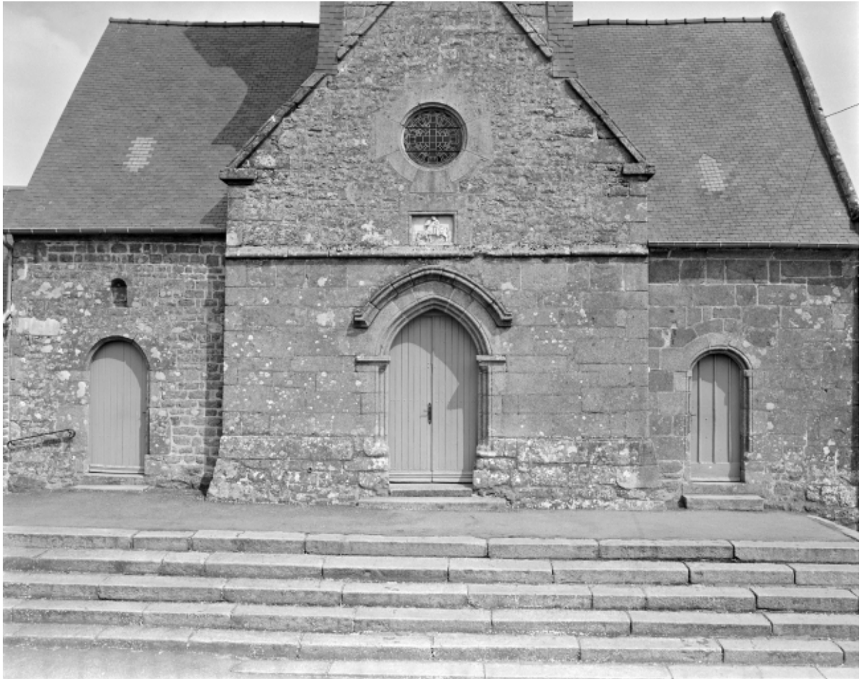
Elévation Ouest, porte : vue générale
