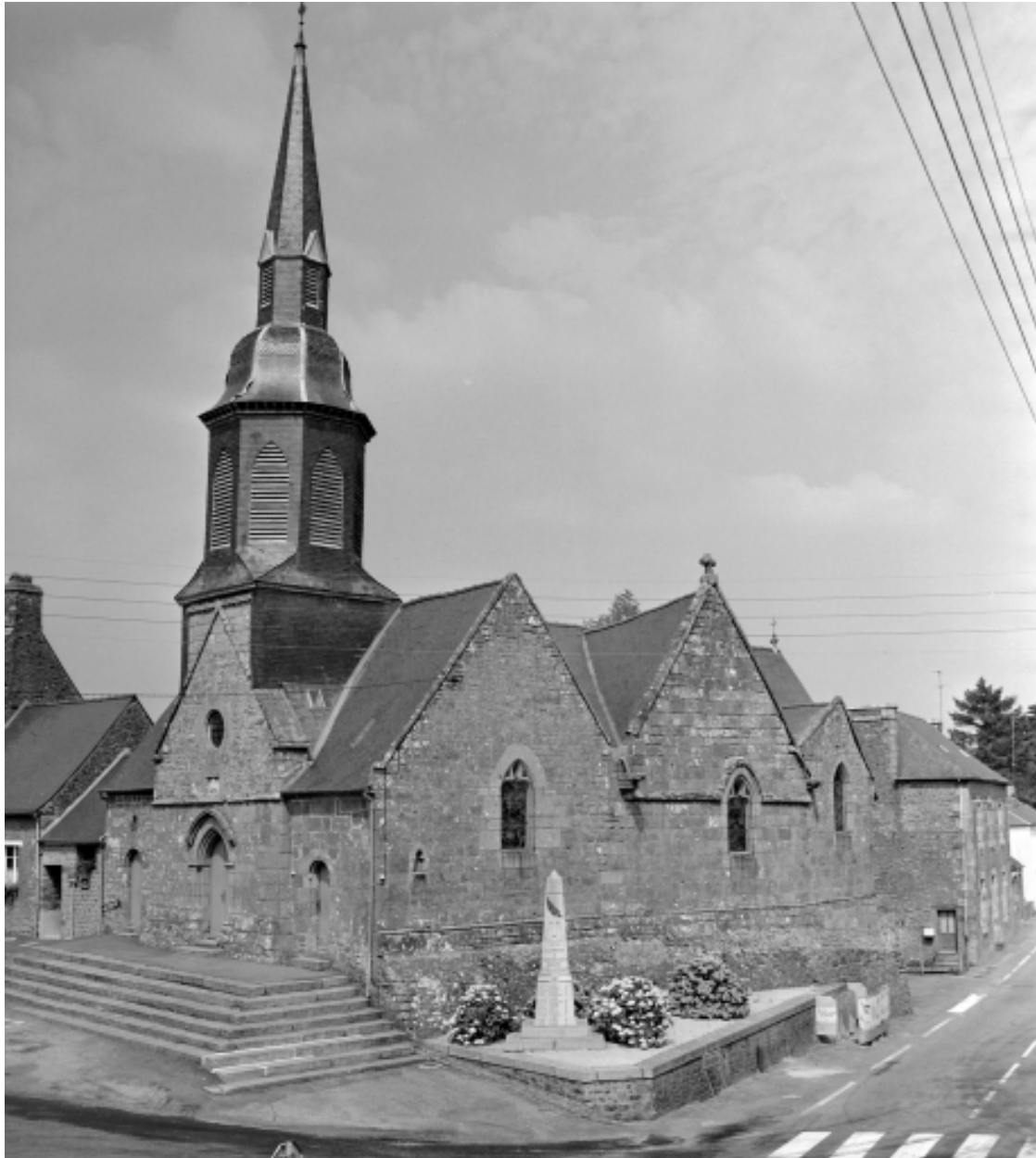
Elévation Sud-Ouest : vue générale
