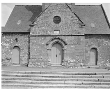
Élévation Ouest, porte : vue générale Phot. Guy Artur, Phot. Norbert Lambart IVR53_19943501470X
