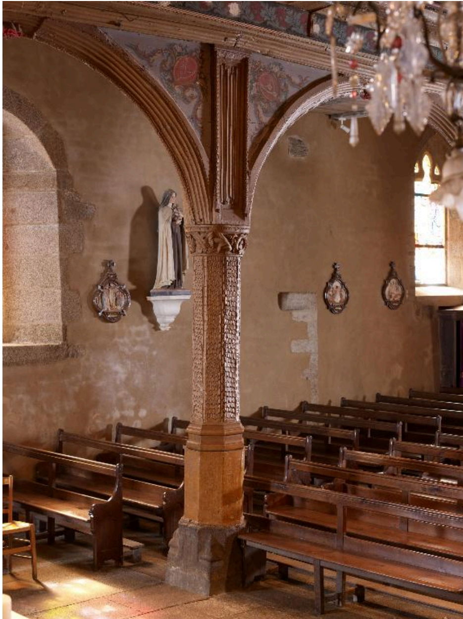
Vue générale d'un pilier entièrement en bois
