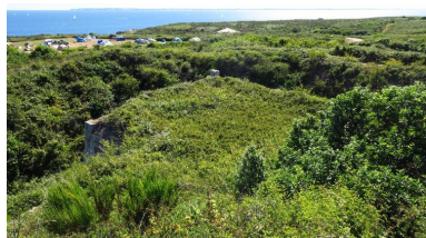
Île-d'Houat, fort central, bastion sud-est. Phot. Lionel Duigou IVR53_20165606087NUCA
