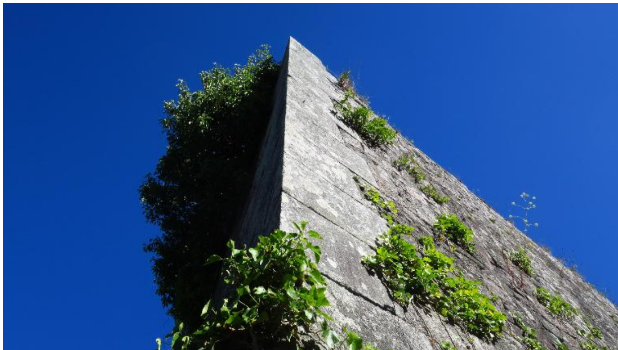
Île-d'Houat, fort central, détail de l'arrête du bastion nord-ouest.
