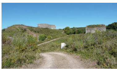
Île-d'Houat, fort central, emplacement de la caserne et magasin à poudre. Phot. Patrick Jadé IVR53_20165606085NUCA
