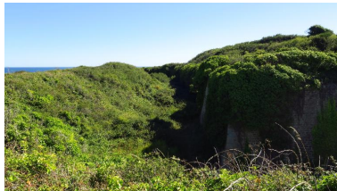
Île-d'Houat, fort central, bastion nord-est. Phot. Lionel Duigou IVR53_20165606088NUCA
