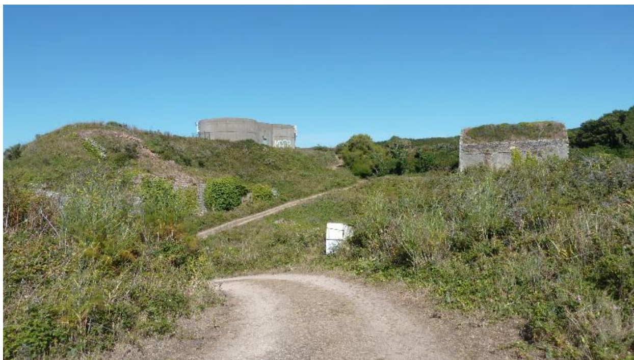
Île-d'Houat, fort central, emplacement de la caserne et magasin à poudre.
