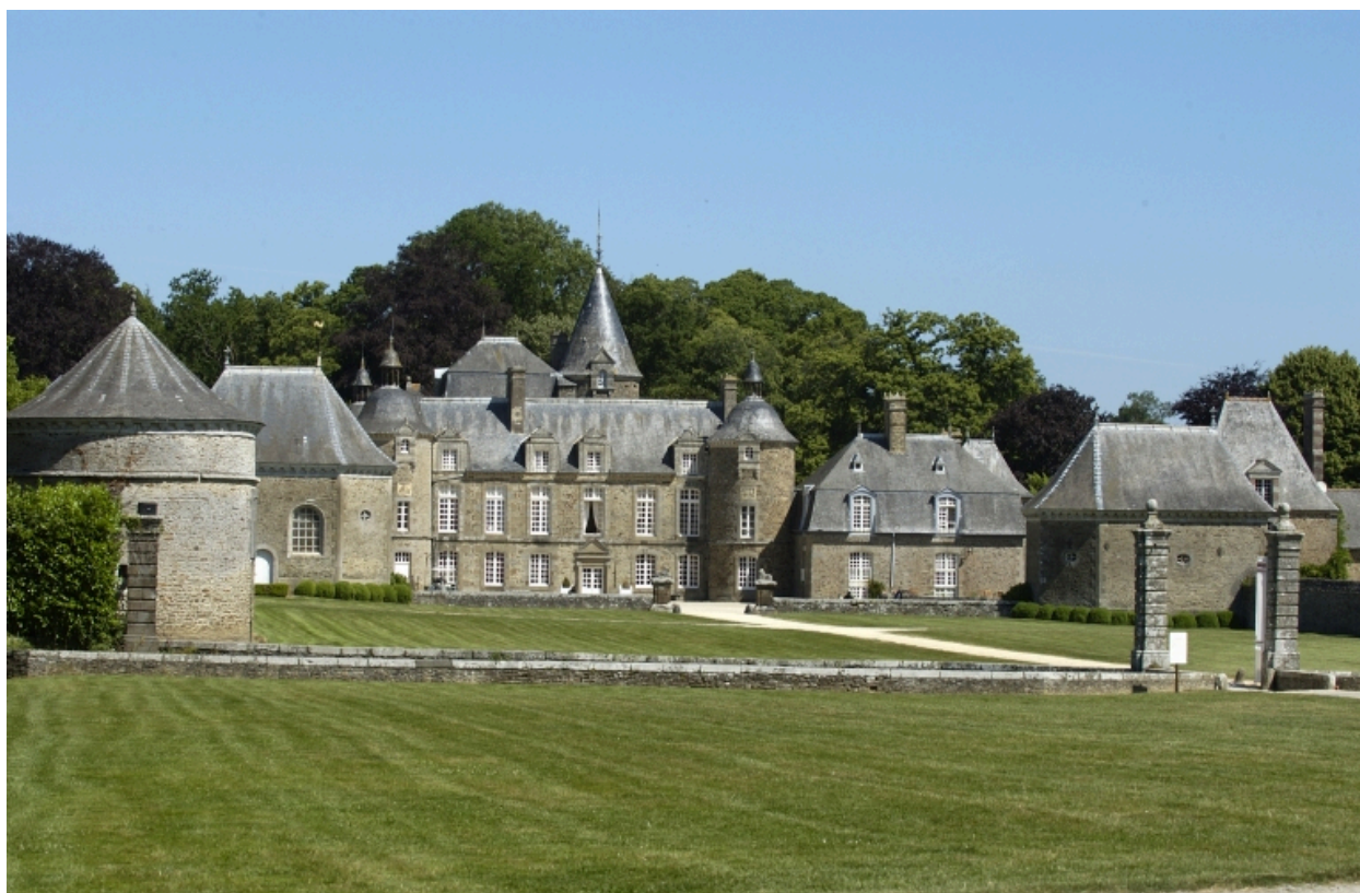
Vue générale sud
