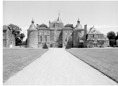
Vue générale ouest Phot. Claude Quillivic IVR53_19943501232X
