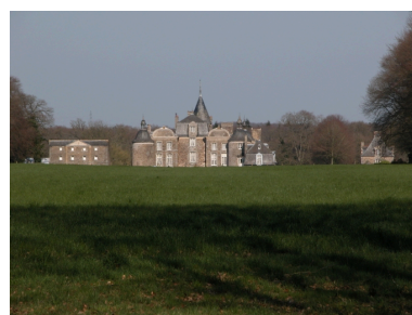
Vue générale ouest Phot. Claude Quillivic IVR53_20063510665NUCA
