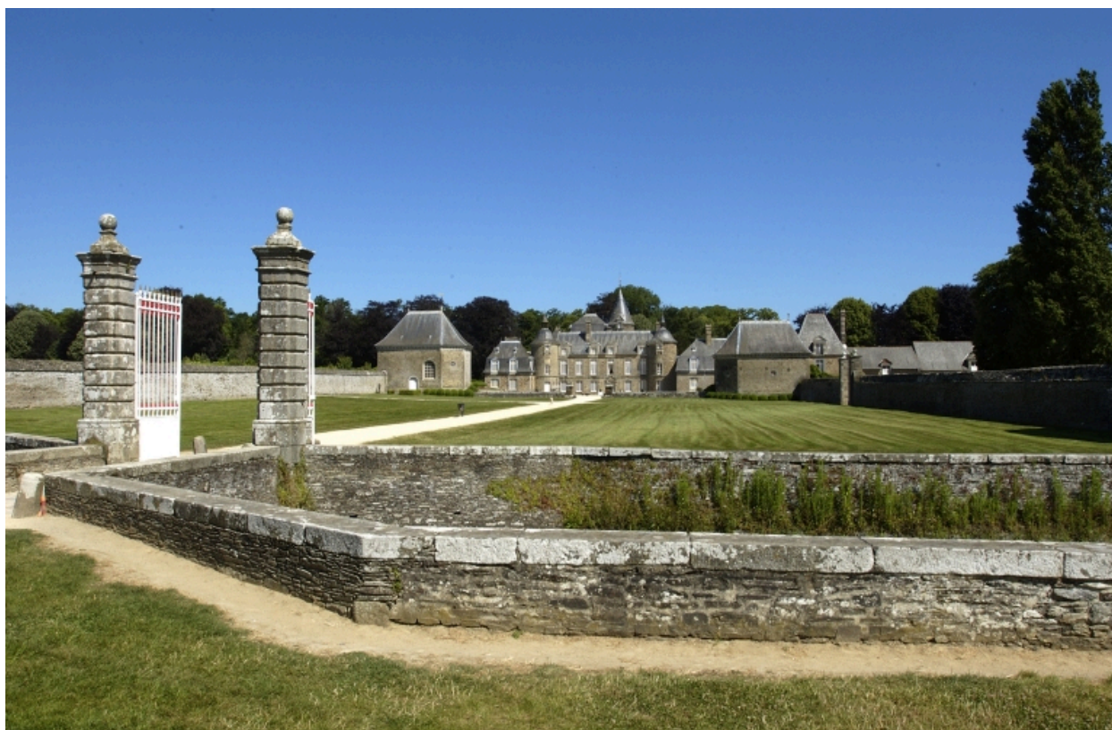
Vue générale sud
