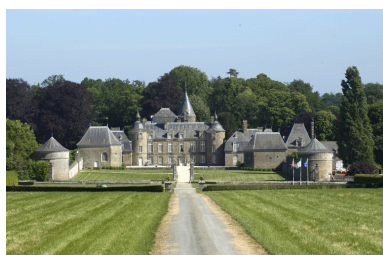
Vue générale sud Phot. Norbert Lambart IVR53_20063501412NUCA
