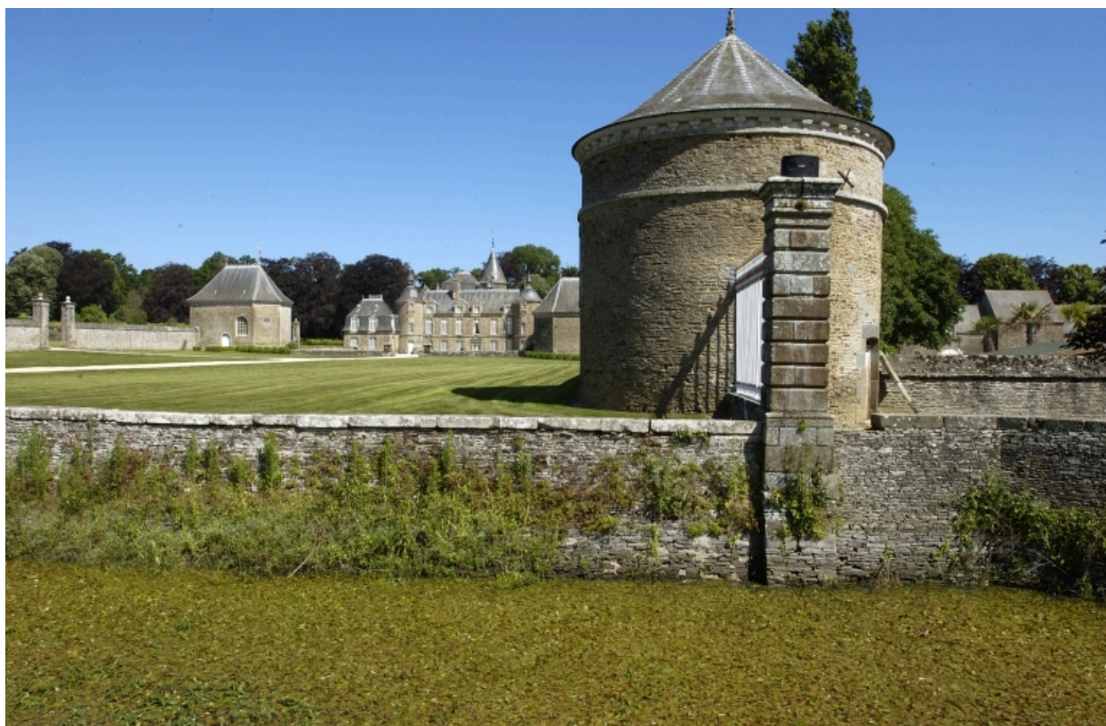
Vue générale sud
