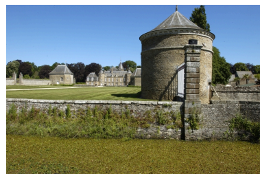
Vue générale sud Phot. Norbert Lambart IVR53_20063501445NUCA
