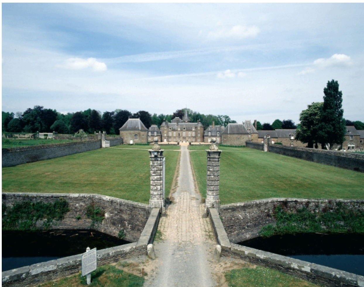
Vue générale sud
