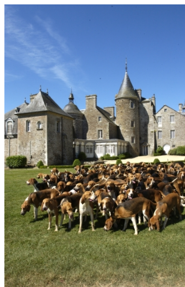
La meute face est du château Phot. Norbert Lambart IVR53_20063501433NUCA
