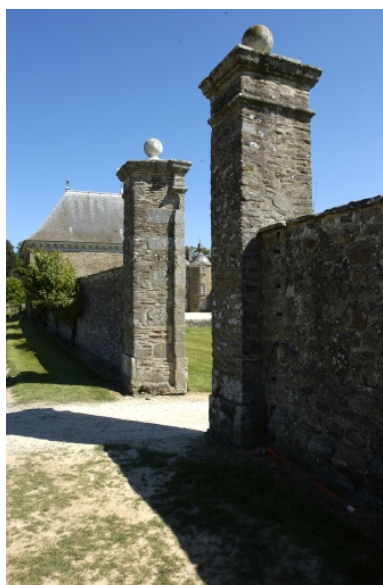
Portail du jardin Phot. Norbert Lambart IVR53_20063501440NUCA
