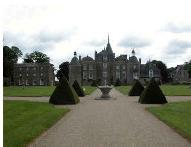
Vue générale ouest Phot. Claude Quillivic IVR53_20063511183NUCA
