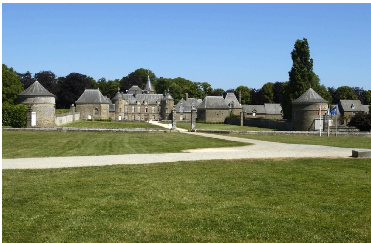
Vue générale sud
