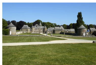
Vue générale sud Phot. Norbert Lambart IVR53_20063501447NUCA
