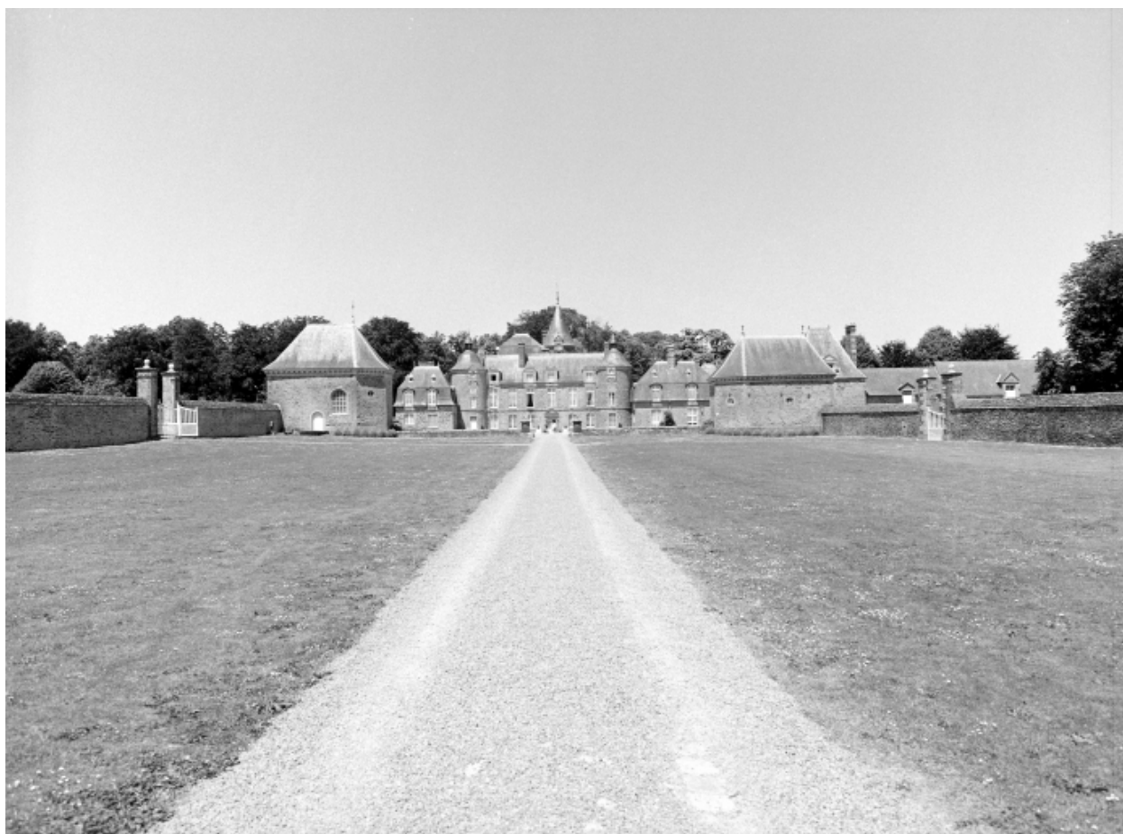
Vue générale sud
