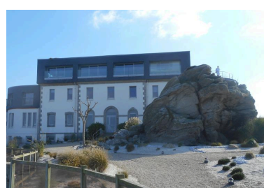
Vue du centre de thalassothérapie de Roscoff : élévation nord (état en 2016). Au premier plan à droite, le chaos de granite appelé Roc'h Kroum (photographie réalisée dans le cadre de l'enquête thématique régionale sur les patrimoines maritimes et estuariens du Pays de Morlaix) Phot. Dany Guillou-Beuzit IVR53_20232905344NUCA
