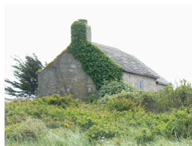
Vue du corps de garde de Penhoat Phot. Lénaïg L'Aot IVR53_20072908569NUCA
