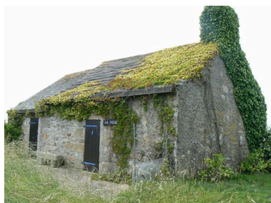
Vue générale du corps de garde de Penhoat Phot. Lénaïg L'Aot IVR53_20072908567NUCA
