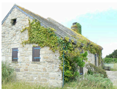
Vue du corps de garde de Penhoat Phot. Lénaïg L'Aot IVR53_20072908568NUCA
