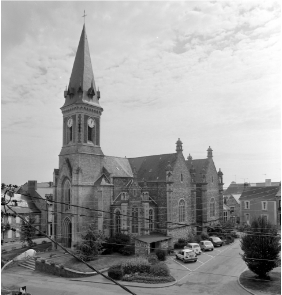
Elévation Sud-Ouest : vue générale.
