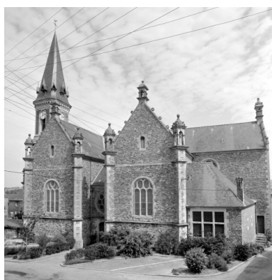
Élévation Sud : vue générale. Phot. Guy Artur, Phot. Norbert Lambart IVR53_19943501403X
