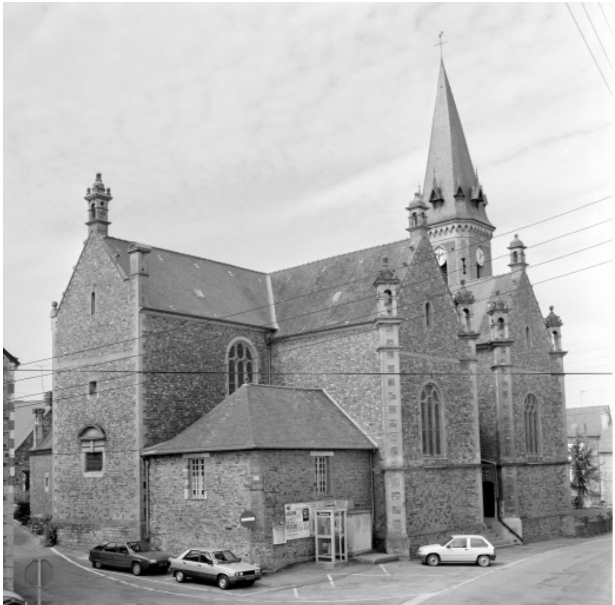
Elévation Nord-Est : vue générale
