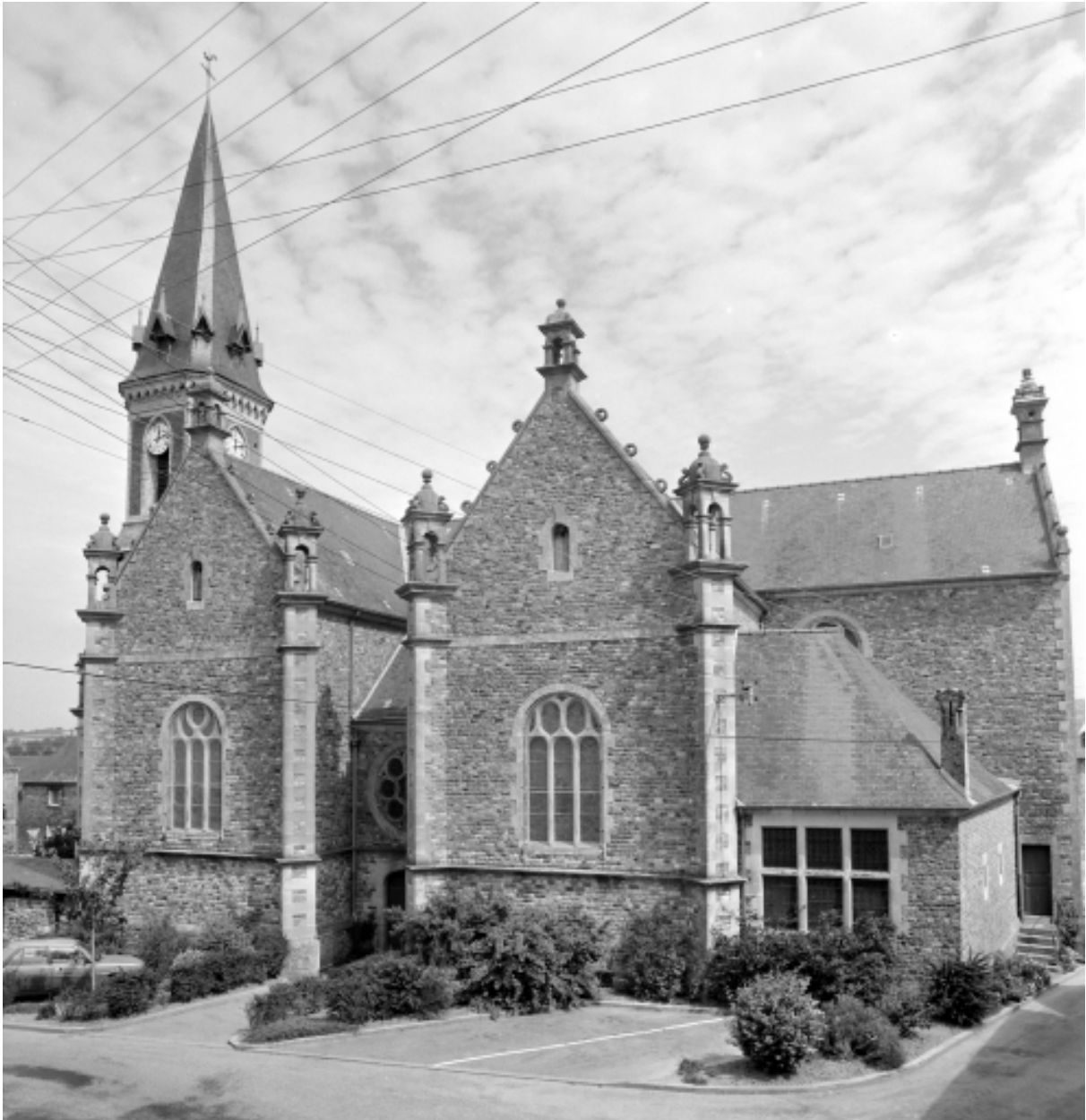
Elévation Sud : vue générale.
