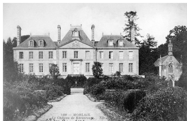
Vue générale Phot. Elise Lauranceau IVR53_20042905485NUCB
