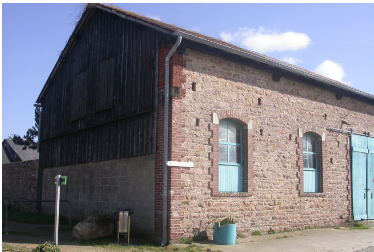
Partie ouest du bâtiment
