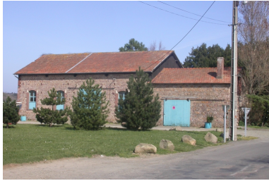
Vue générale Phot. Jérôme Cucarull IVR53_20052203528NUCA
