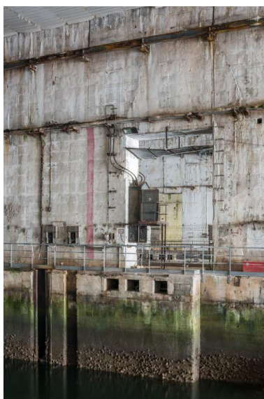
Vue de l'alvéole C (n° 21 et 22) : quai est Phot. Charlotte Barraud IVR53_20215600646NUCA
