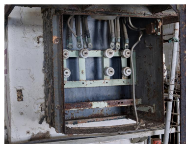
Vue du mur de refend situé entre les alvéoles C et D : tableau situé sous l'armoire électrique Phot. Bernard Bègne IVR53_20235600079NUCA
