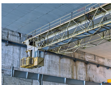
Vue de détail du pont roulant d'origine d'une capacité de 5 t avec son chemin de roulement. En dessous, chemin de roulement du pont roulant récent Phot. Bernard Bègne IVR53_20235600578NUCA
