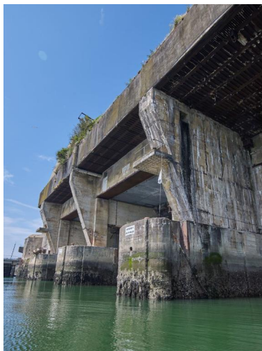
Vue de l'entrée des alvéoles A, B (alvéoles simples) et C (alvéole pour deux sous-marins) : à droite, le contrefort du mur de refend Phot. Bernard Bègne IVR53_20215600505NUCA
