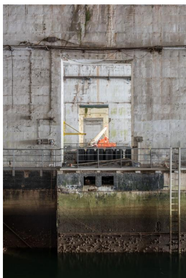
Vue de l'alvéole C (n° 21 et 22) : quai est Phot. Charlotte Barraud IVR53_20215600645NUCA
