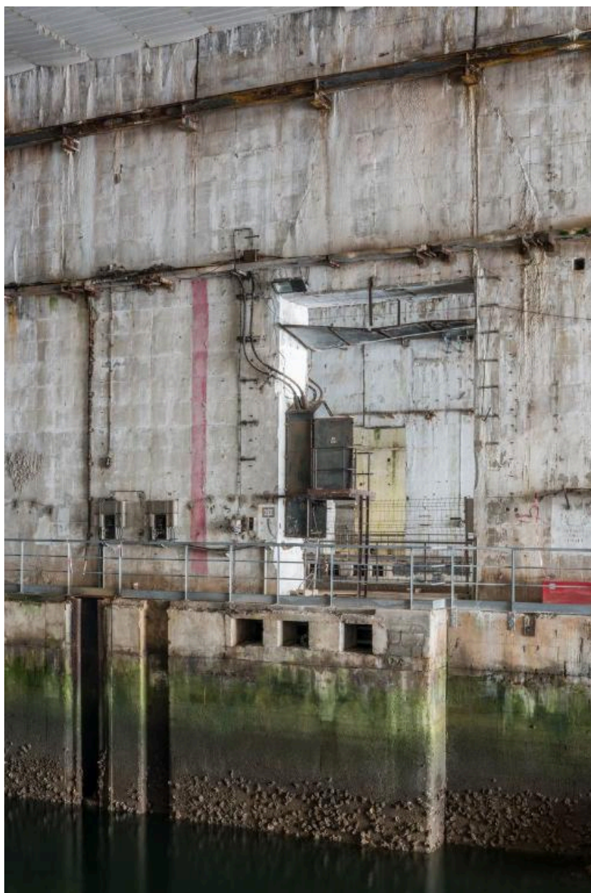
Vue de l'alvéole C (n° 21 et 22) : quai est
