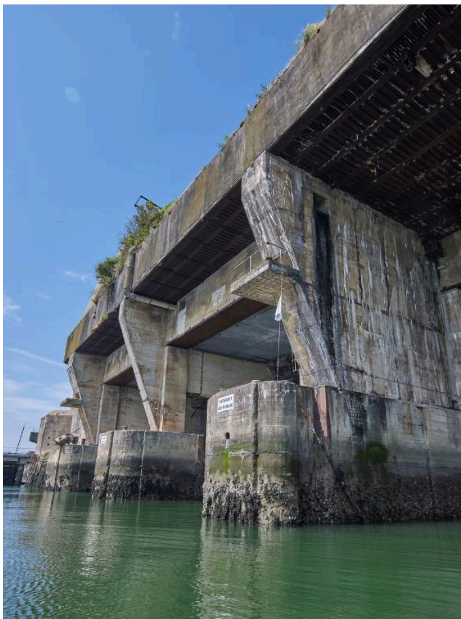
Vue de l'entrée des alvéoles A, B (alvéoles simples) et C (alvéole pour deux sous-marins) : à droite, le contrefort du mur de refend
