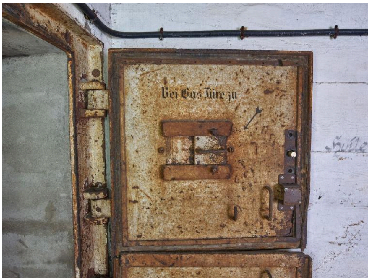
Vue de la porte blindée à deux vantaux de l'entrée. On peut lire l'instruction suivante en allemand : Bei Gas Türe zu, Fermez la porte pour le gaz, avec une flèche vers le volet mobile
