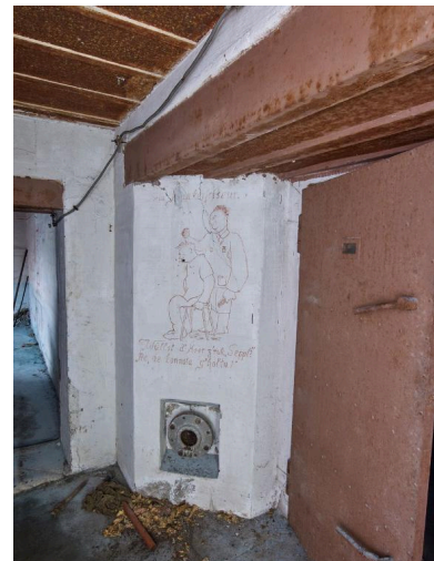
Vue de situation de l'une des deux peintures murales situées dans le couloir. En bas, clapet de suppression. A droite, la porte étanche de la salle de garde Phot. Bernard Bègne IVR53_20215600484NUCA
