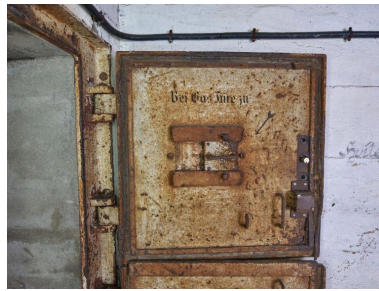
Vue de la porte blindée à deux vantaux de l'entrée. On peut lire l'instruction suivante en allemand : Bei Gas Türe zu, Fermez la porte pour le gaz, avec une flèche vers le volet mobile Phot. Bernard Bègne IVR53_20215600471NUCA
