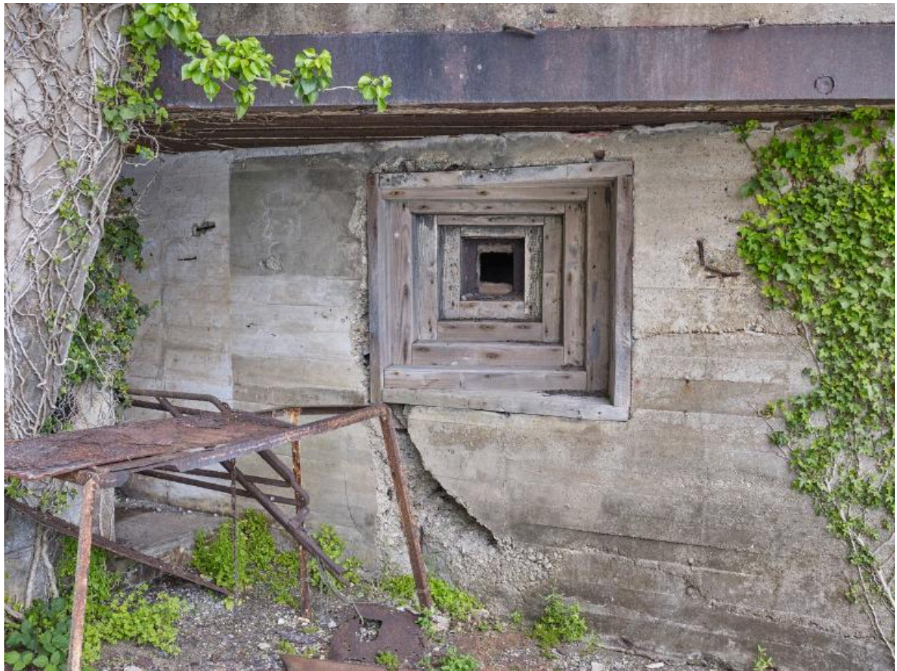
Vue de l'embrasure de la caponnière. Elle est revêtue en bois avec un profil anti-ricochet en gradin (Trepenscharte)
