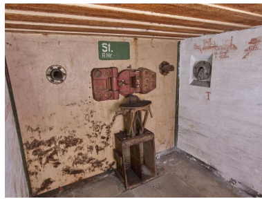
Vue de la chambre de combat pour mitrailleuse. Au centre, le support d'affût et l'affût. Au-dessus, marquage caractéristique St. pour la position. A gauche, le panorama de tir Phot. Bernard Bègne IVR53_20215600478NUCA
