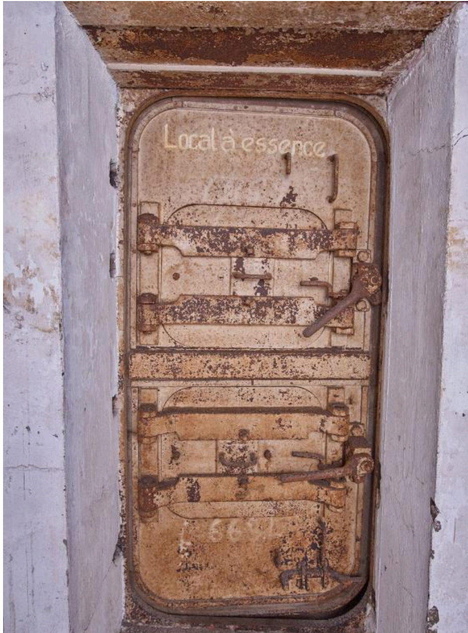
Vue de la porte blindée étanche à deux vantaux de la caponnière de défense (position fermée). On peut lire l'instruction : Local à essence. Les vantaux sont également numérotés
