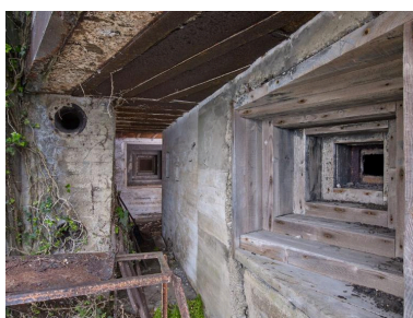
Vue de l'embrasure de la caponnière. Elle est revêtue en bois avec un profil anti-ricochet en gradin (Trepenscharte). Au centre, la seconde embrasure correspond à la défense de l'entrée. Sur les murs, des graffitis de soldats de toute époque Phot. Bernard Bègne IVR53_20215600462NUCA
