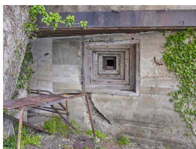
Vue de l'embrasure de la caponnière. Elle est revêtue en bois avec un profil anti- ricochet en gradin (Trepenscharte) Phot. Bernard Bègne IVR53_20215600461NUCA
