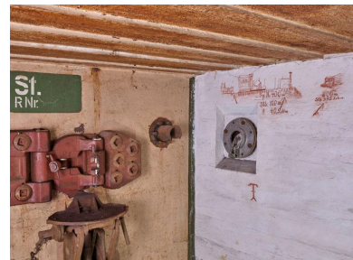
Vue du panorama de tir avec repère de distance pour la mitrailleuse. A droite, support d'affût, affût de mitrailleuse et créneau blindé de tir. A gauche, sous le dessin, bouche de surpression à clapet Phot. Bernard Bègne IVR53_20215600477NUCA
