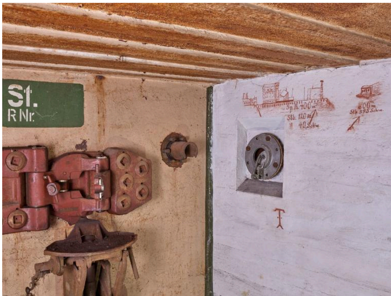
Vue du panorama de tir avec repère de distance pour la mitrailleuse. A droite, support d'affût, affût de mitrailleuse et créneau blindé de tir. A gauche, sous le dessin, bouche de surpression à clapet
