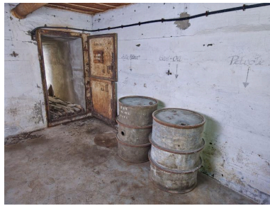
Vue de l'entrée de la salle de ventilation côté alvéole G : porte blindée à deux vantaux et deux barils marqués BSM GAS OIL / DATE. Sur les murs, des peintures françaises pour le stockage : Huile Moteur, Gas-Oil, Pétrole et des flèches vers le bas Phot. Bernard Bègne IVR53_20215600470NUCA
