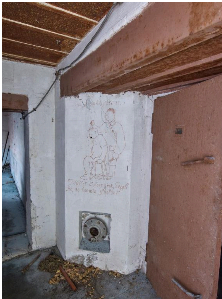
Vue de situation de l'une des deux peintures murales situées dans le couloir. En bas, clapet de surpression. A droite, la porte étanche de la salle de garde
