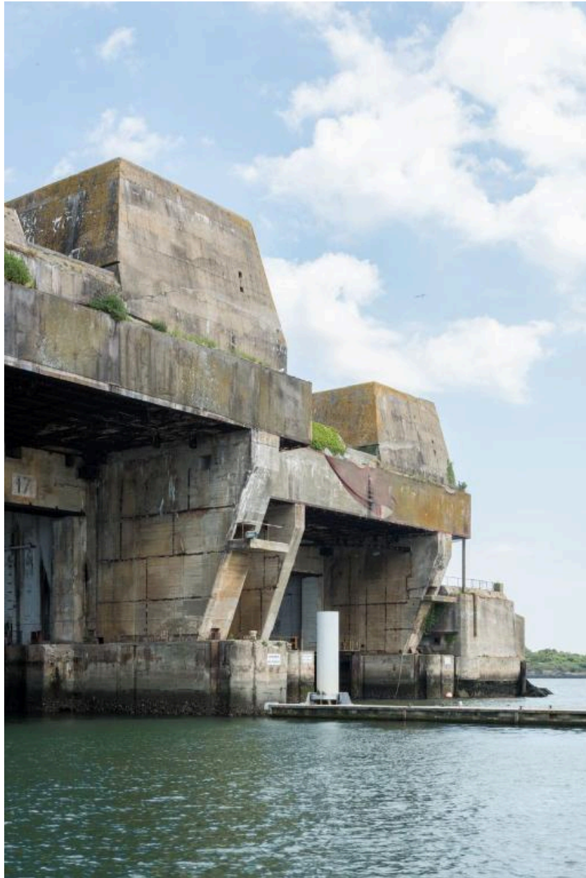
Vue de situation de la casemate flanquant l'angle sud du bunker KIII
