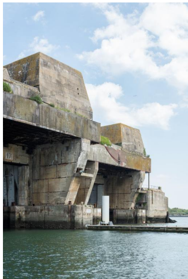
Vue de situation de la casemate flanquant l'angle sud du bunker KIII Phot. Charlotte Barraud IVR53_20215600597NUCA
