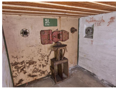
Vue de la chambre de combat pour mitrailleuse. Au centre, le support d'affût et l'affût. Au-dessus, marquage caractéristique St. pour la position. A gauche, le panorama de tir Phot. Bernard Bègne IVR53_20215600478NUCA
