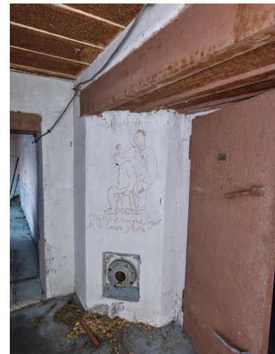
Vue de situation de l'une des deux peintures murales situées dans le couloir. En bas, clapet de surpression. A droite, la porte étanche de la salle de garde Phot. Bernard Bègne IVR53_20215600484NUCA
