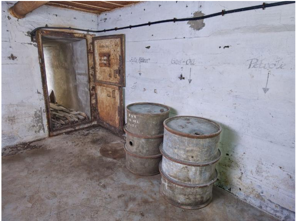
Vue de l'entrée de la salle de ventilation côté alvéole G : porte blindée à deux vantaux et deux barils marqués BSM GAS OIL / DATE. Sur les murs, des peintures françaises pour le stockage : Huile Moteur, Gas-Oil, Pétrole et des flèches vers le bas
