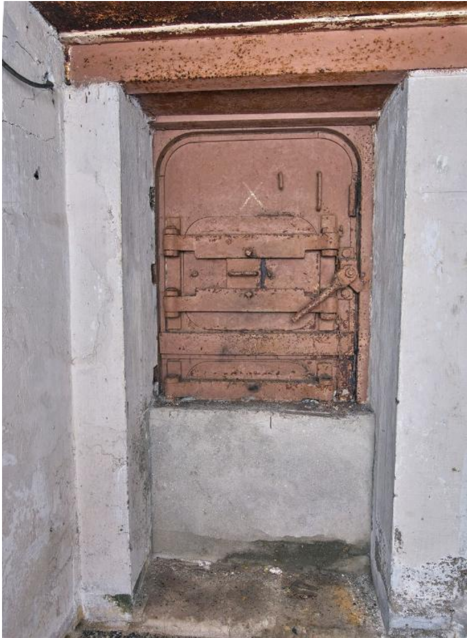
Vue de la porte blindée étanche à deux vantaux du couloir. Elle est murée en partie basse
