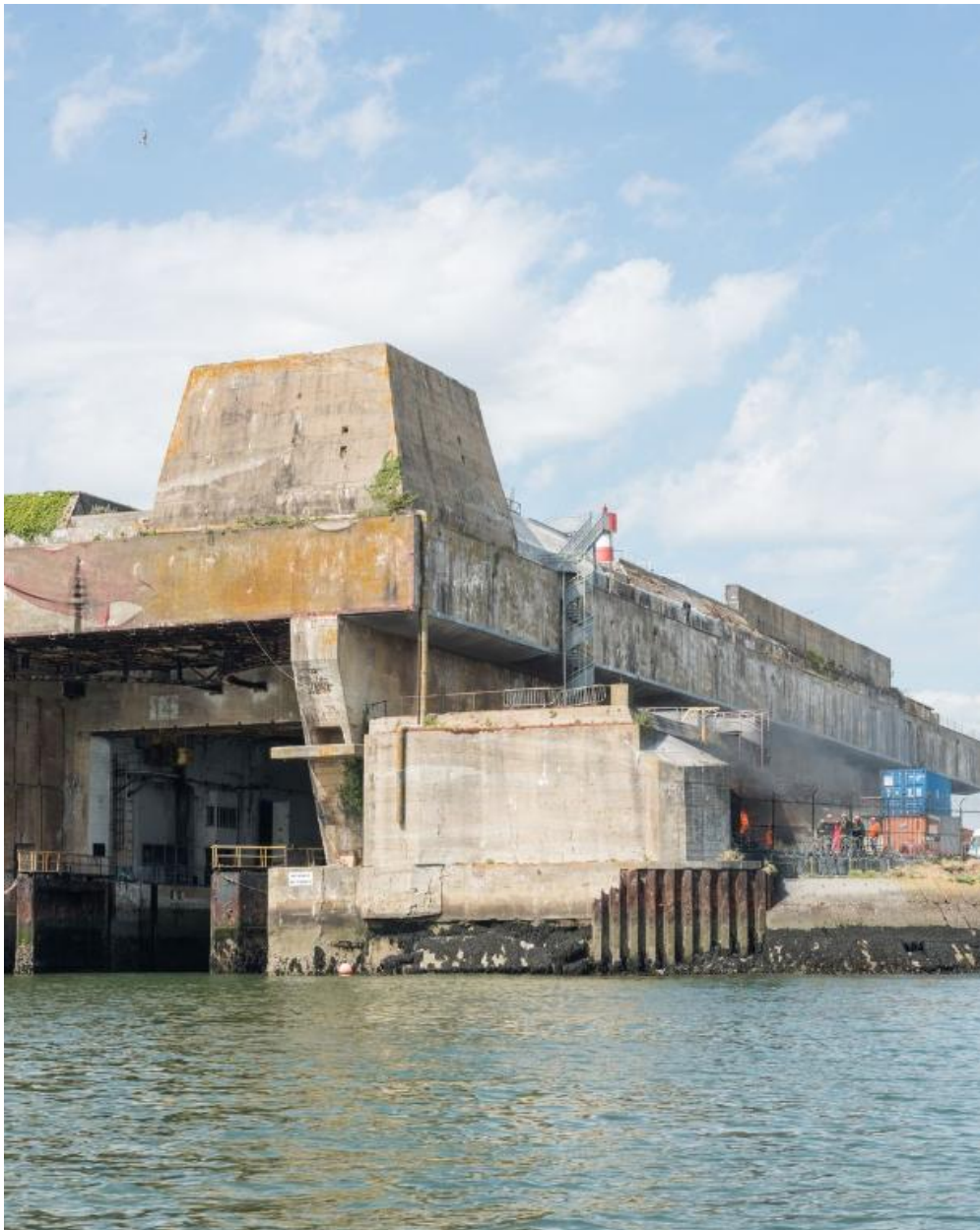
Vue de situation de la casemate flanquant l'angle sud du bunker KIII : mur aveugle vers la rade de Lorient faisant mur de flanquement de l'embrasure pour canon
