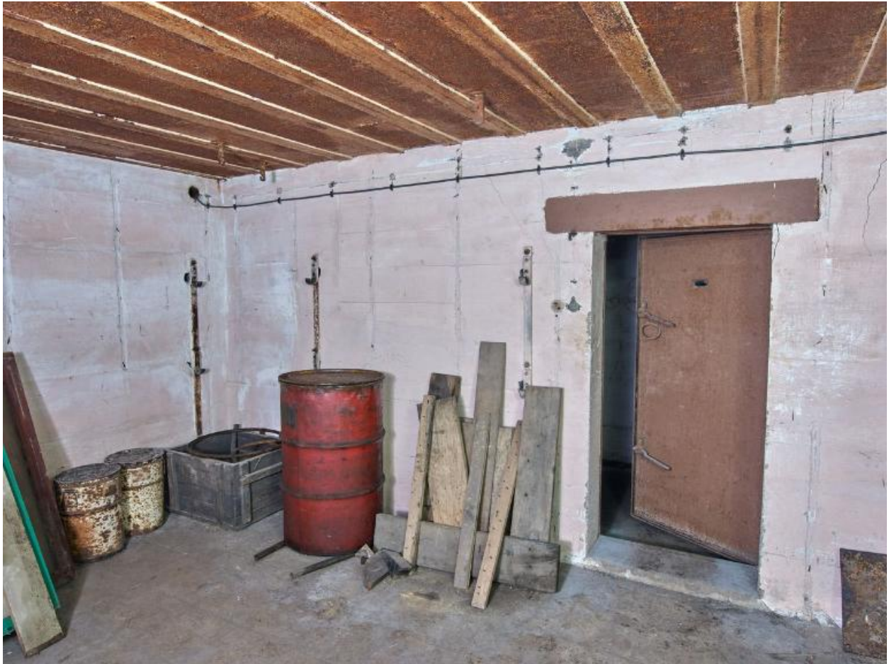
Vue de la pièce de vie de l'équipage du bunker : porte étanche. Au plafond et sur les murs, crochets pour la suspension des couchettes tubulaires
