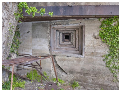
Vue de l'embrasure de la caponnière. Elle est revêtue en bois avec un profil anti-ricochet en gradin (Trepenscharte) Phot. Bernard Bègne IVR53_20215600461NUCA
