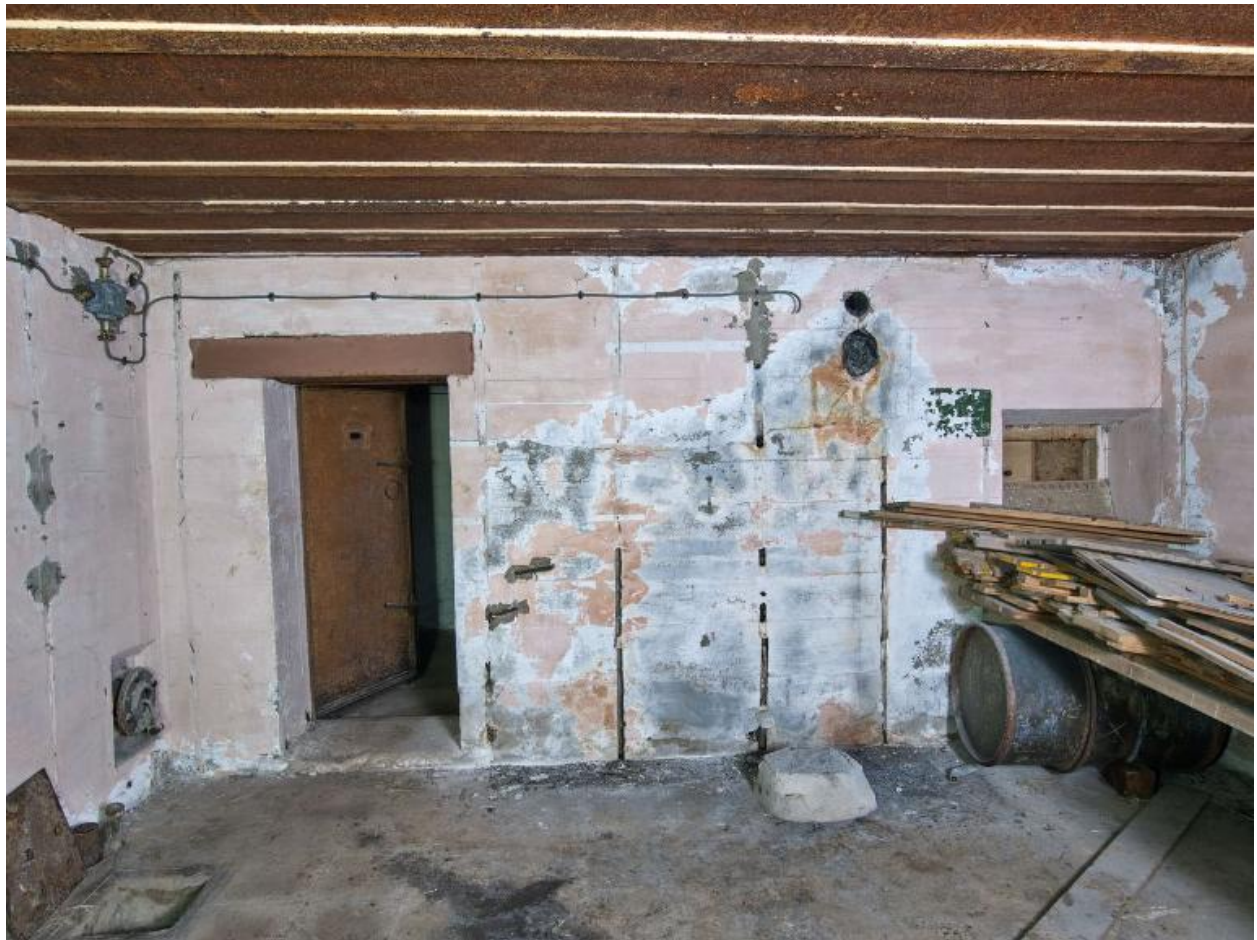
Vue de la pièce de vie de l'équipage du bunker : porte étanche à gauche ; au sol, créneau de surpression à contrepoids et, à droite, créneau blindé de défense d'entrée/sortie
