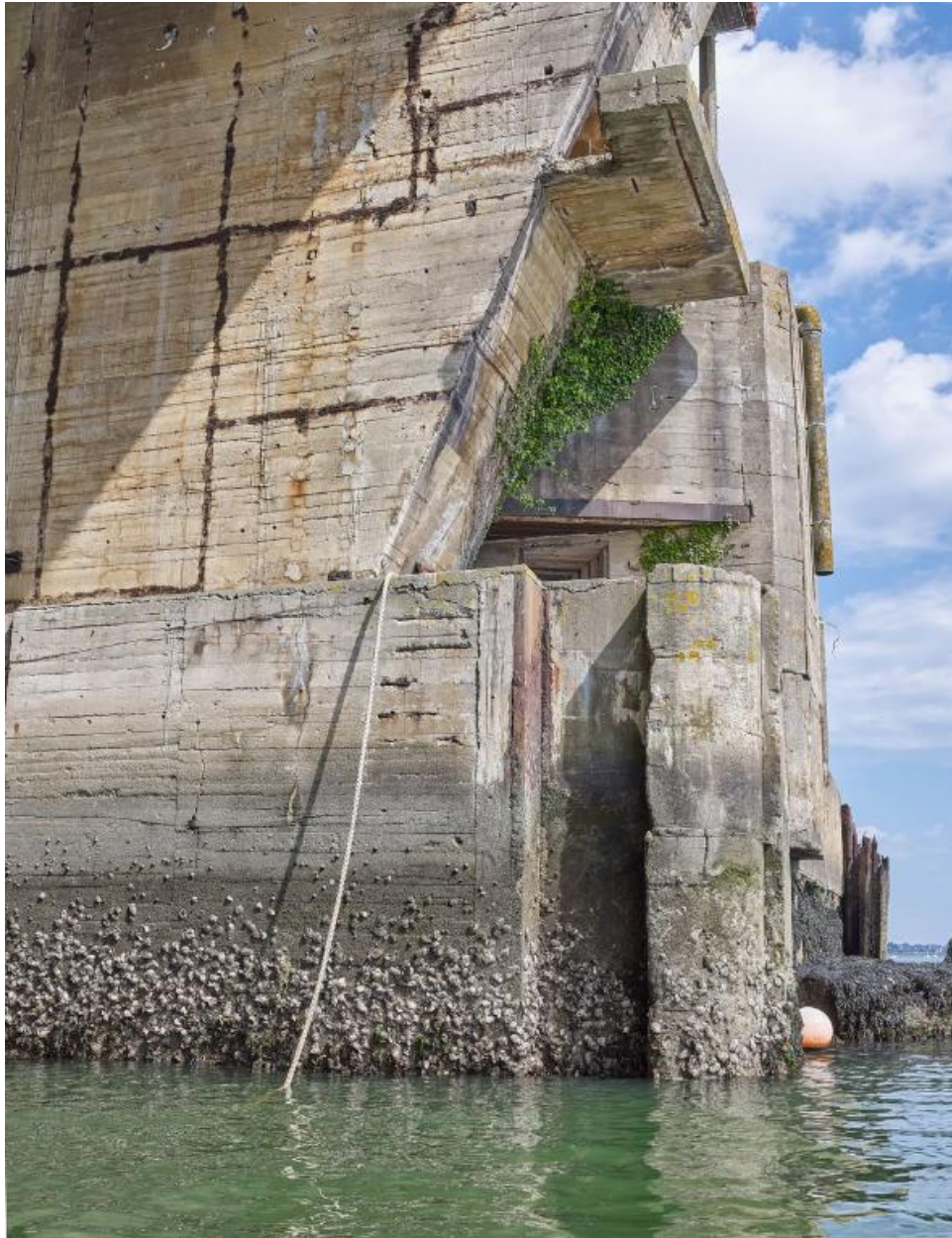
Vue de la casemate et de l'embrasure de sa caponnière depuis l'entrée de l'alvéole G
