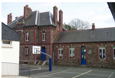
Ploubazlanec, le bourg. Ancienne école communale des filles, façade sur cour (1er quart du 20ème siècle) Phot. Patrick Pichouron IVR53_20072209580NUCA
