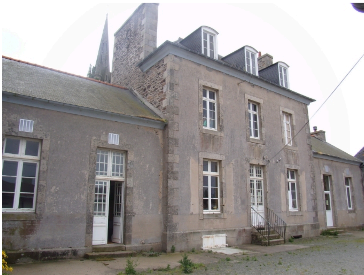
Ploubazlanec, le bourg. Ancienne école communale des garçons, façade sur cour (3ème et 4ème quart du 19ème siècle)
