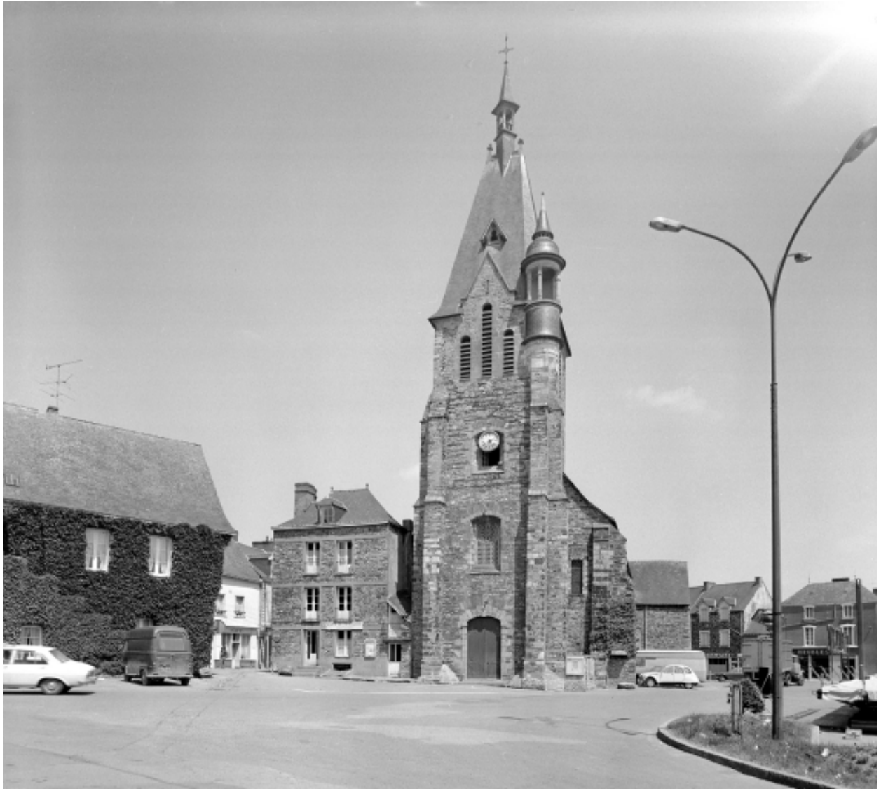
Elévation ouest : vue générale.
