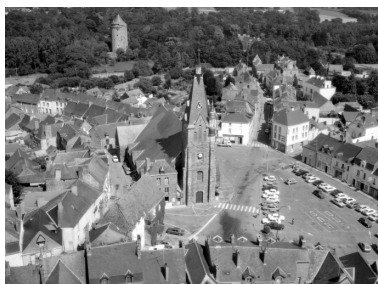
Vue aérienne ouest. Phot. G.A.L.A.T. IVR53_19843501368V
