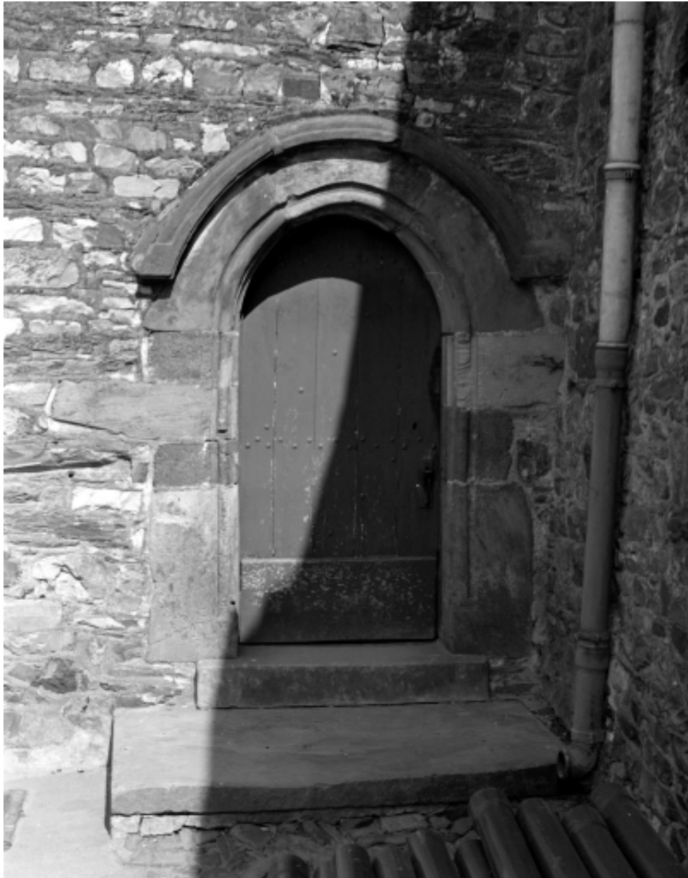
Transept nord, porte, vue générale.
