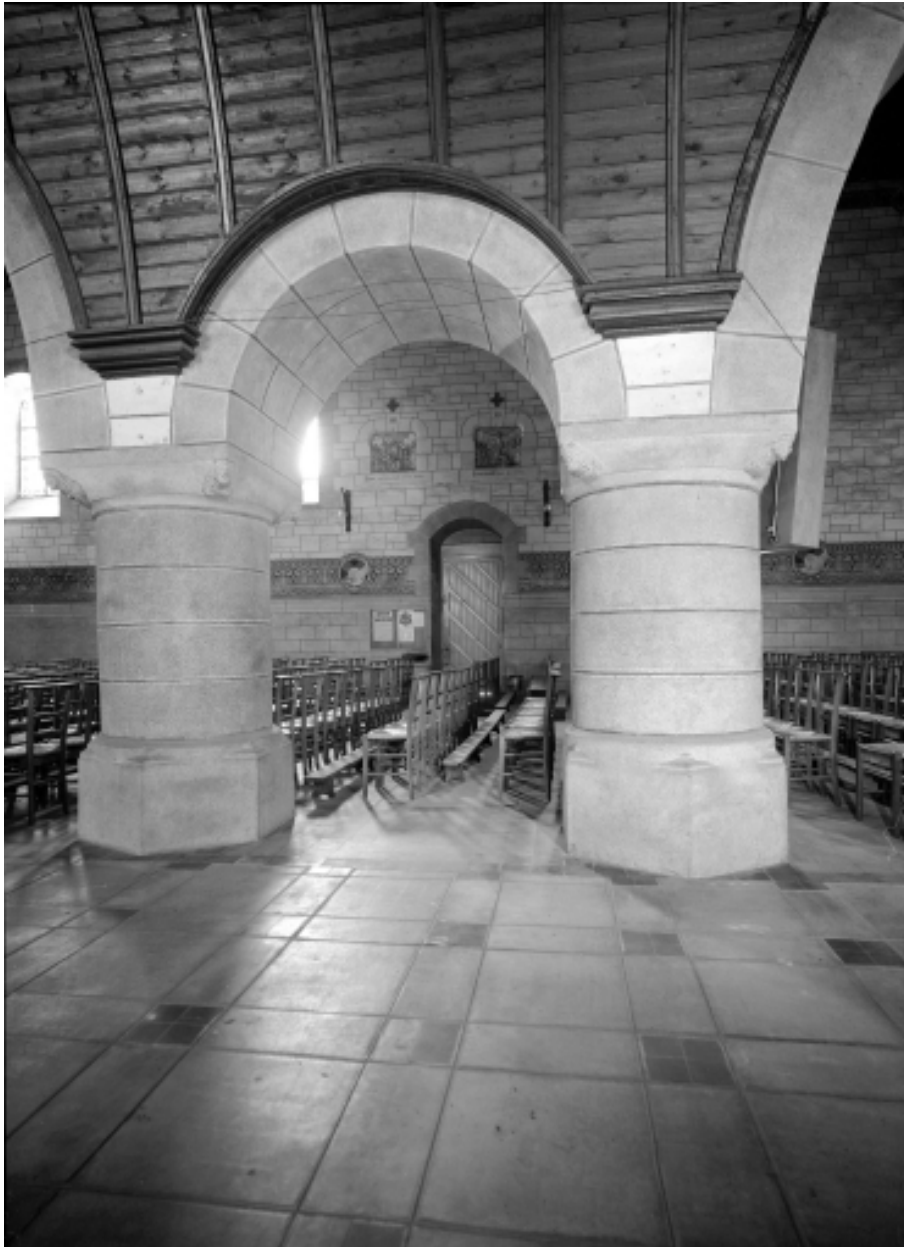
Intérieur, nef, piles 2 nord et 3 nord : vue générale.
