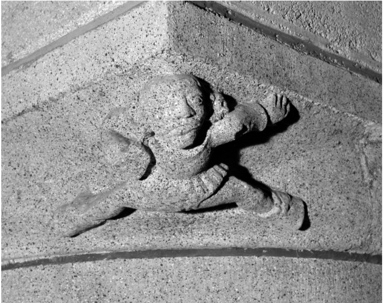
Intérieur, nef, pile 1 nord : détail du chapiteau.
