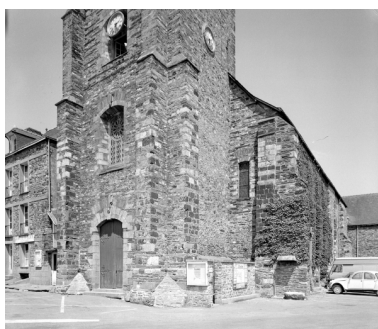
Elévation ouest, clocher, partie basse : vue générale Phot. François Dagorn IVR53_19823500681V
