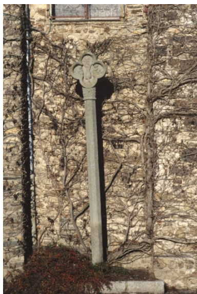
Face antérieure : vue générale, le long de l'église paroissiale. Phot. Claude Quillivic IVR53_19943502604ZA
