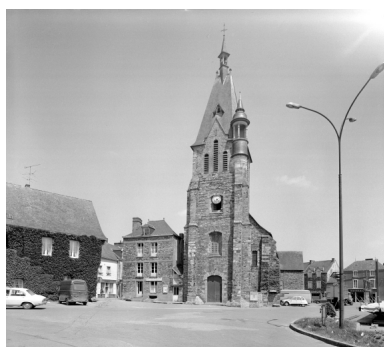
Elévation ouest : vue générale. Phot. François Dagorn IVR53_19823500689V
