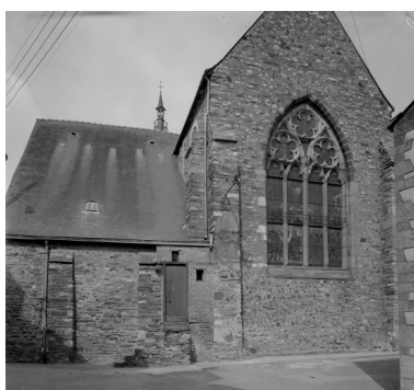
Elévation est, chevet : vue générale Phot. François Dagorn IVR53_19823500714V
