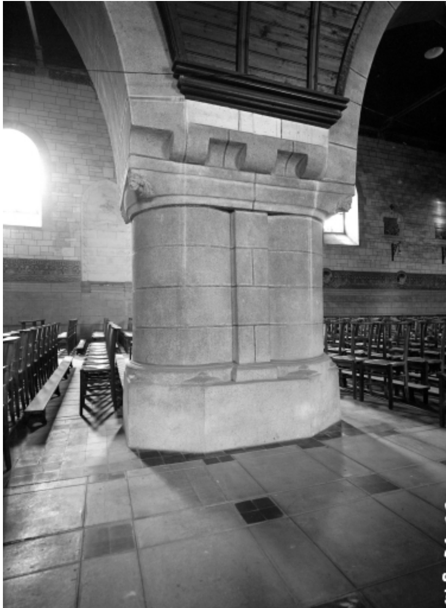
Intérieur, nef, pile 4 nord : vue générale.
