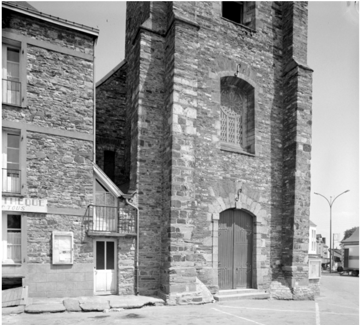
Clocher-porche, niveaux inférieurs.
