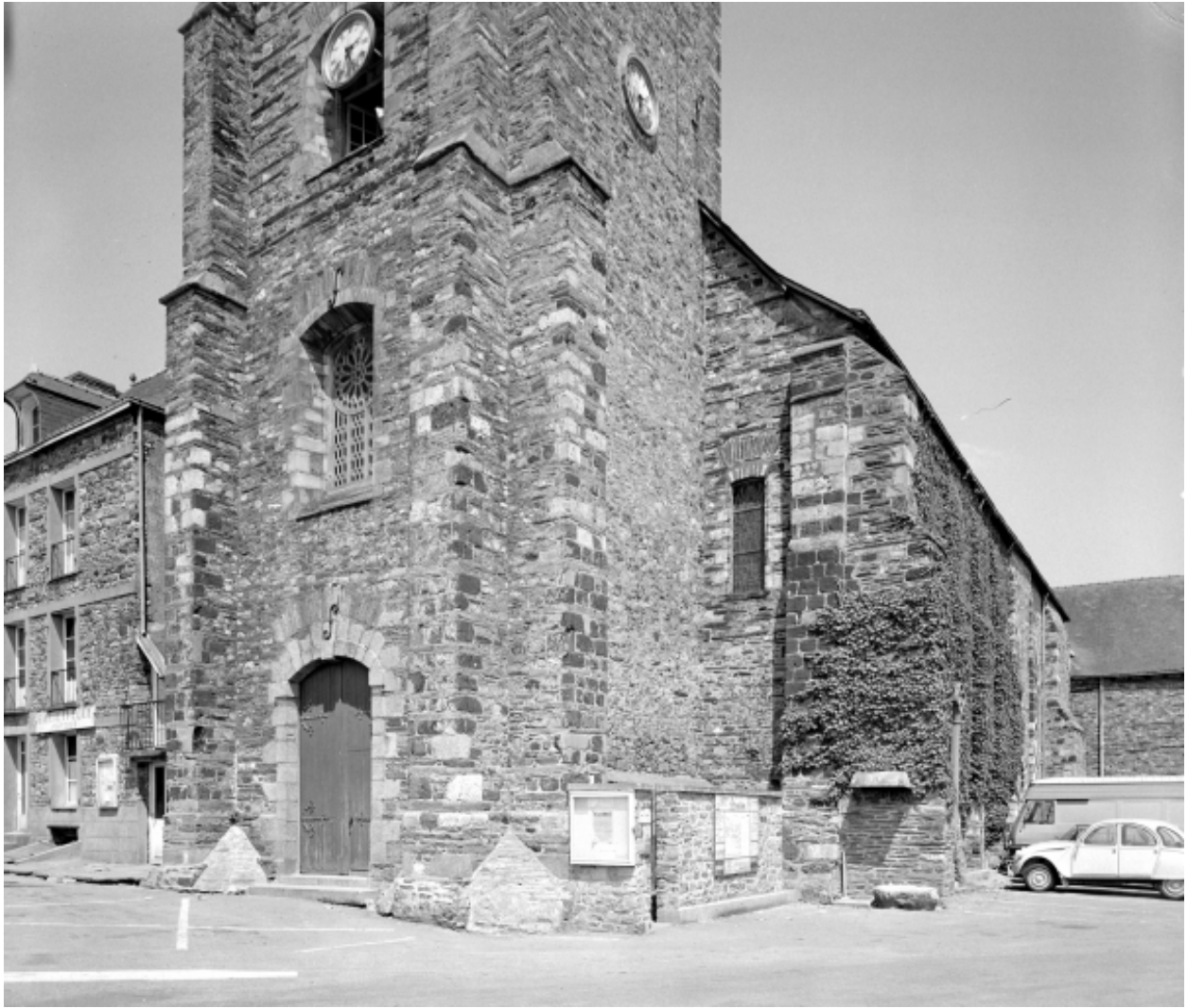
Elévation ouest, clocher, partie basse : vue générale
