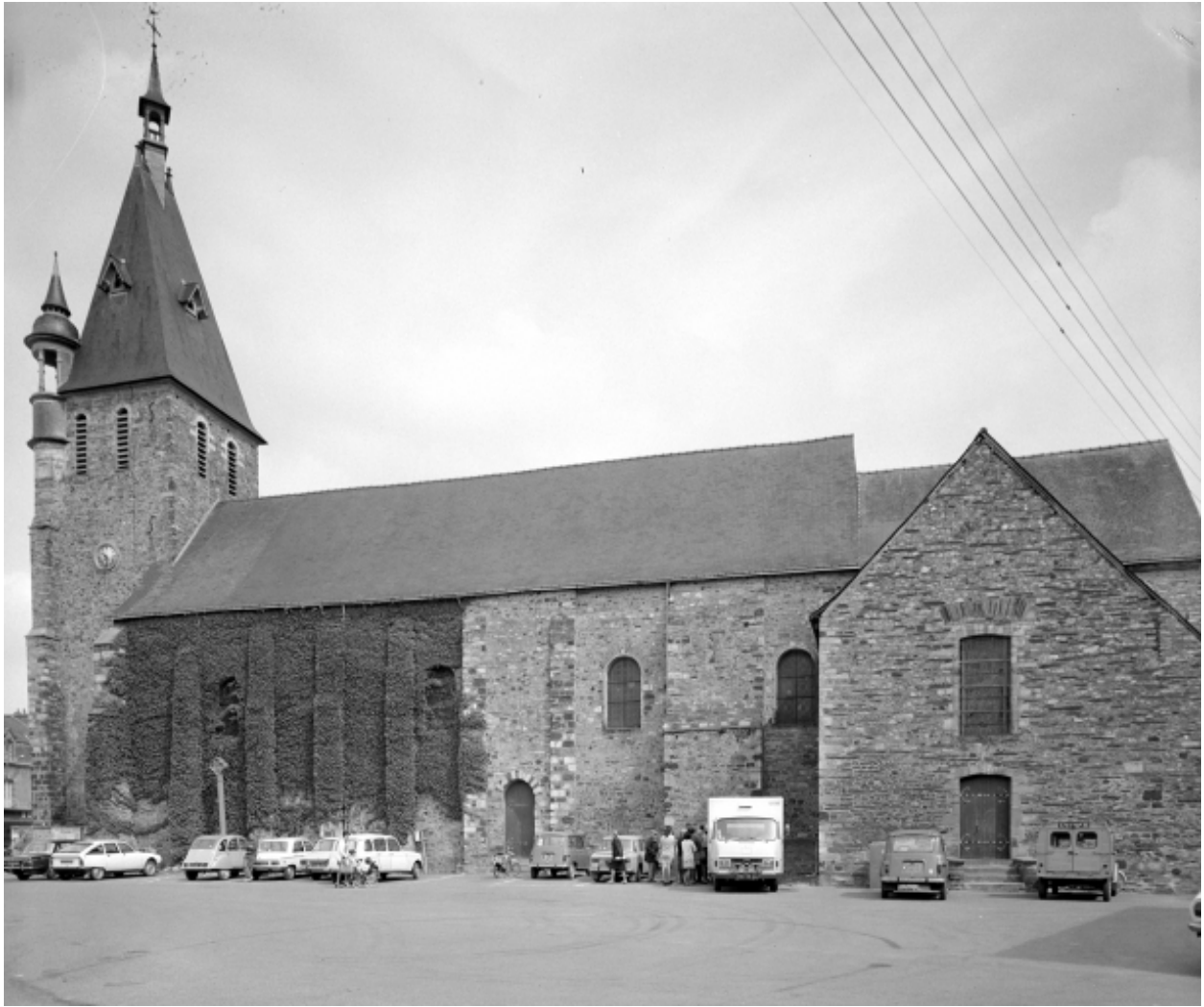
Elévation sud : vue générale
