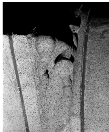
Intérieur, nef, pile 1 nord : détail du chapiteau.
