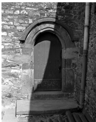
Transept nord, porte, vue générale. Phot. François Dagorn IVR53_19823500698X
