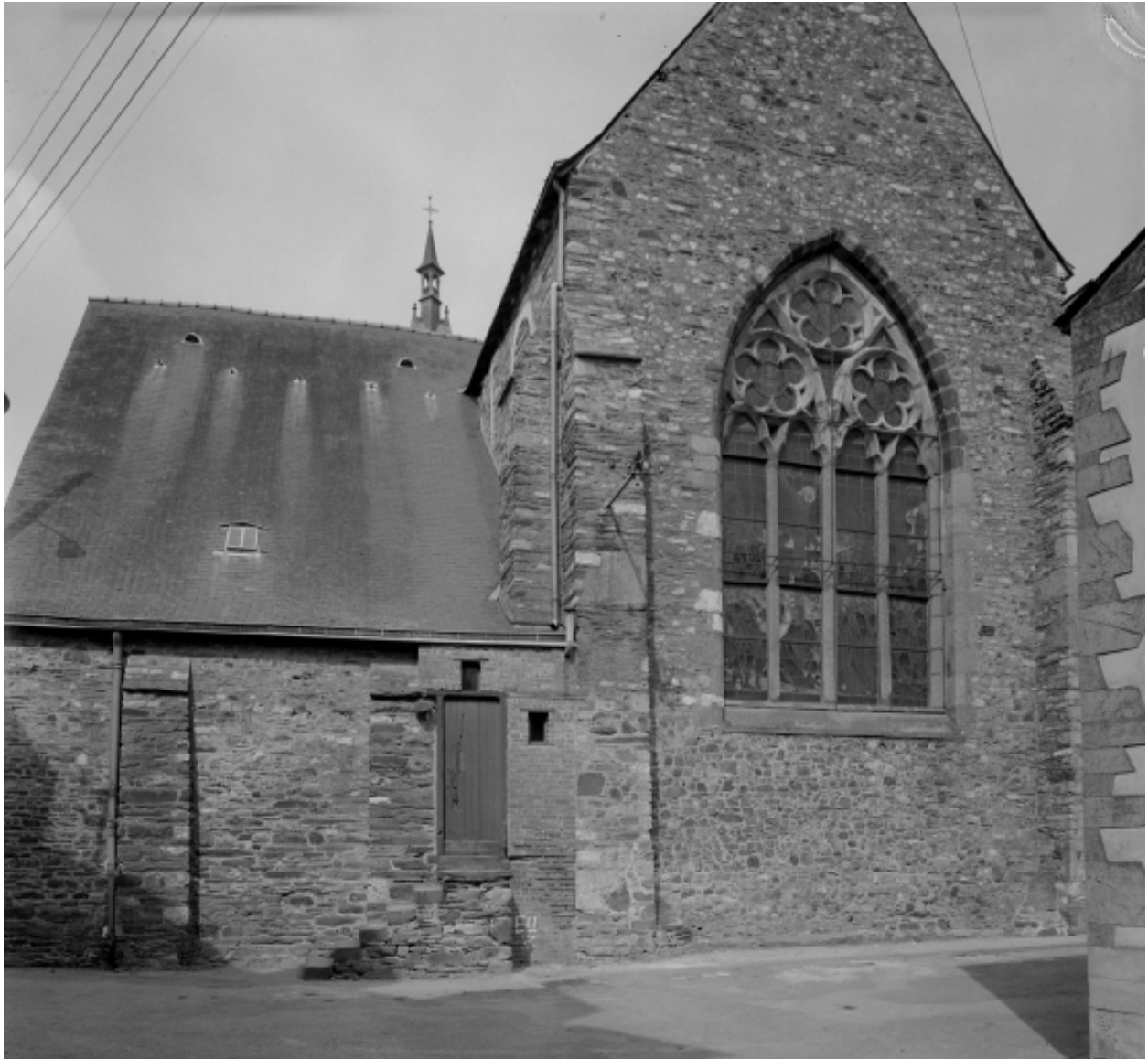
Elévation est, chevet : vue générale
