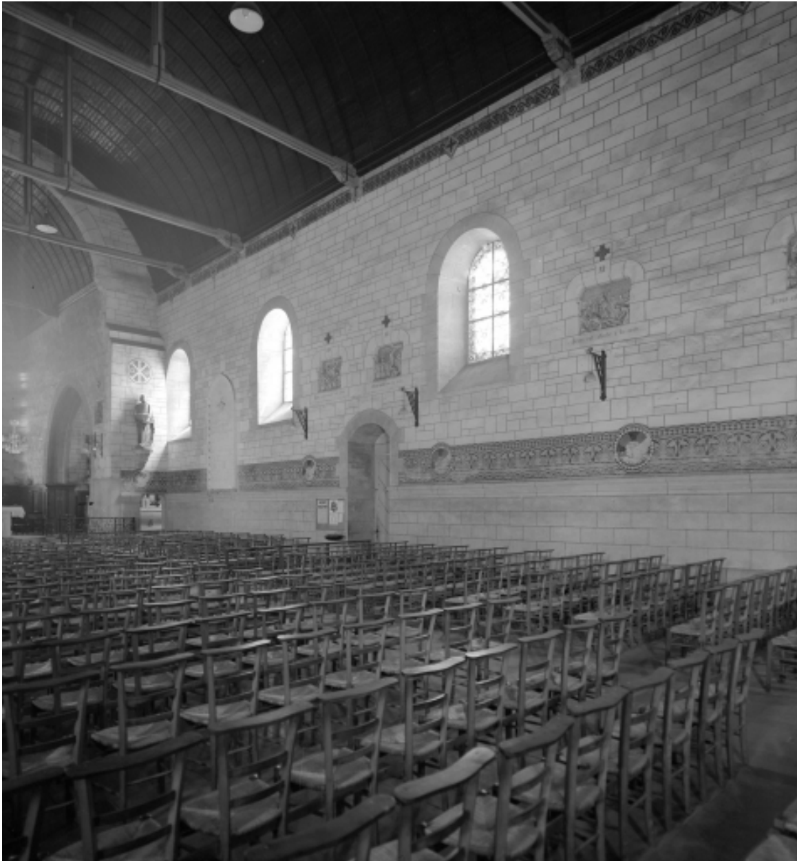
Intérieur, nef, mur sud : vue générale.
