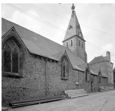
Elévation nord : vue générale Phot. François Dagorn IVR53_19823500690V
