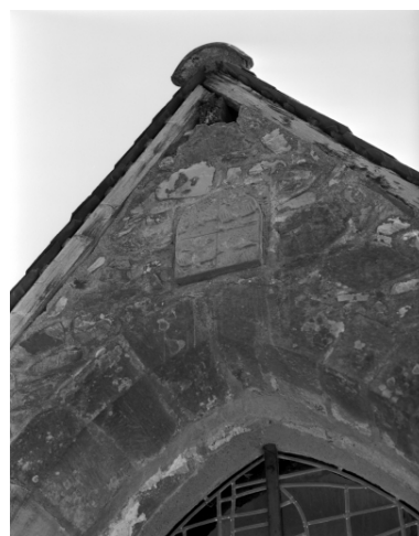
Elévation nord, blason : vue générale Phot. François Dagorn IVR53_19823500697X
