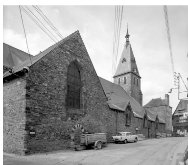
Elévation nord : vue générale Phot. François Dagorn IVR53_19823500700V
