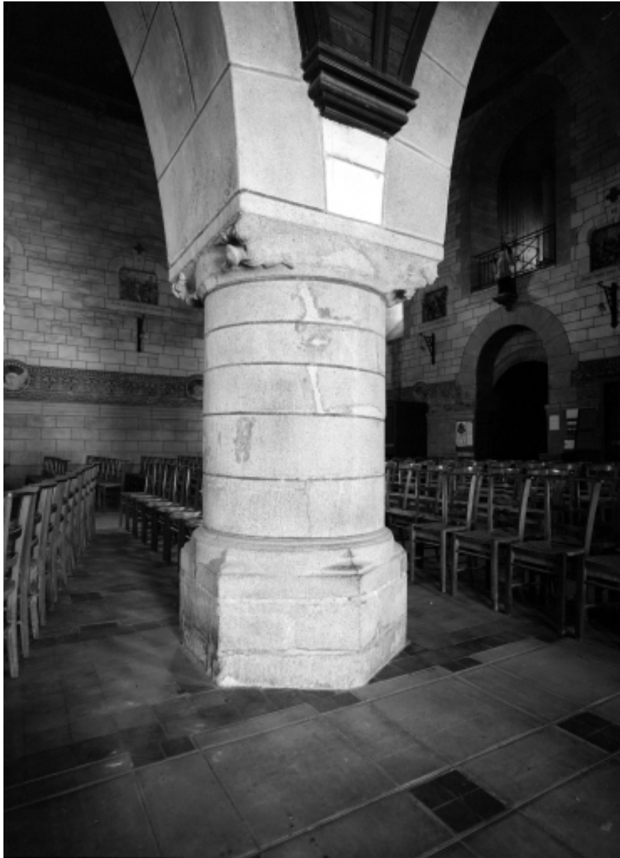
Intérieur, nef, pile 1 nord : vue générale.
