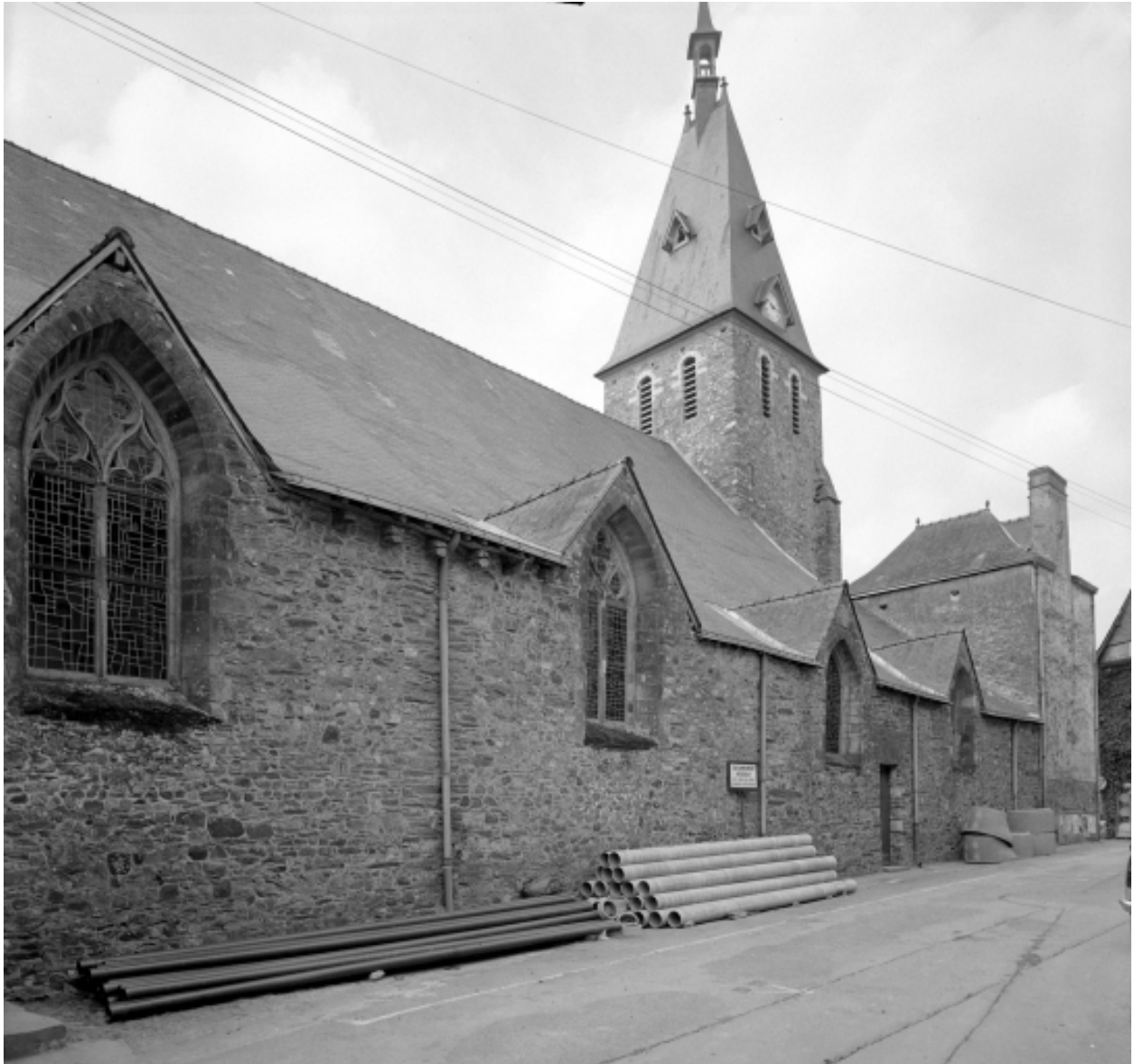
Elévation nord : vue générale
