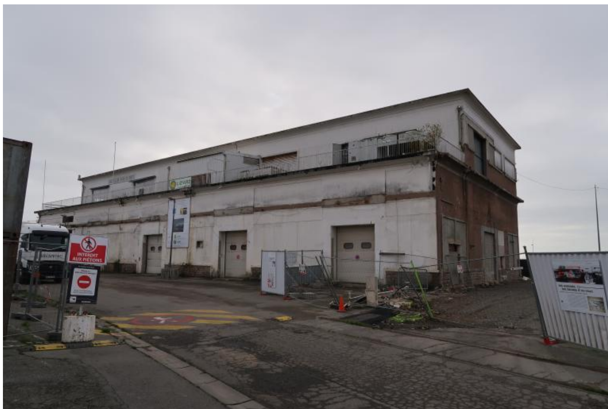
Magasin A (en cours de réhabilitation)
