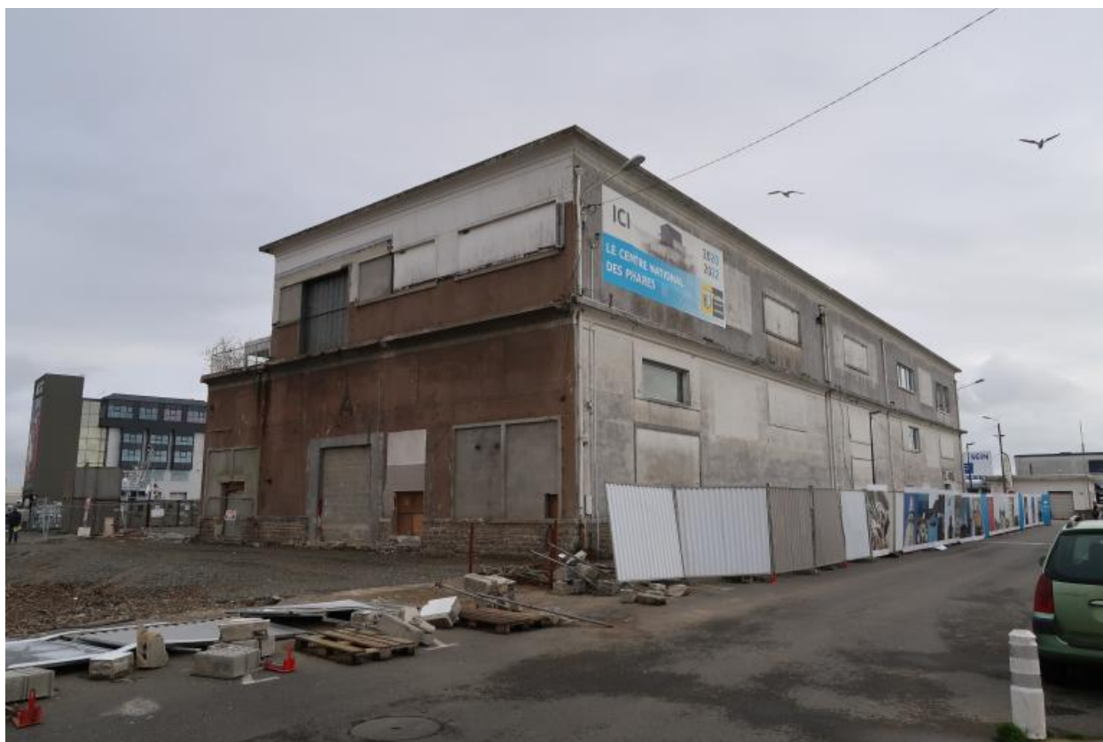
Magasin A, état en 2020 (en cours de réhabilitation)
