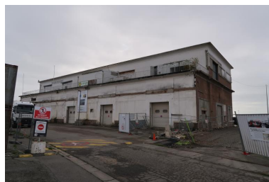
Magasin A (en cours de réhabilitation) Phot. Erwana L'Haridon IVR53_20202905228NUCA
