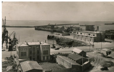
Magasin A en cours de construction en 1955-1956 (carte postale, Ed. Cap ; coll. bibliothèque municipale de Brest) Autr. Compagnie Alsacienne des Arts Photomécaniques (CAP) IVR53_20202905237NUCB
