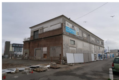
Magasin A, état en 2020 (en cours de réhabilitation) Phot. Erwana L'Haridon IVR53_20202905227NUCA
