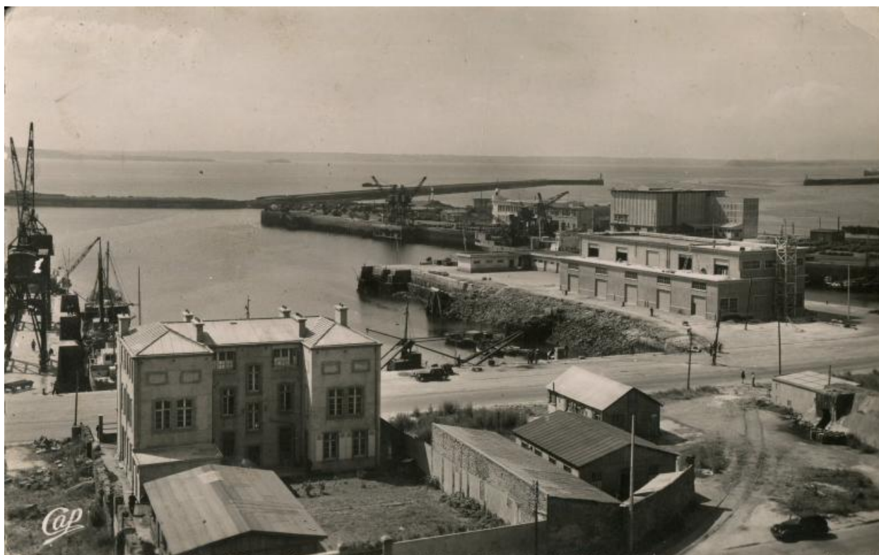
Magasin A en cours de construction en 1955-1956 (carte postale, Ed. Cap ; coll. bibliothèque municipale de Brest)
