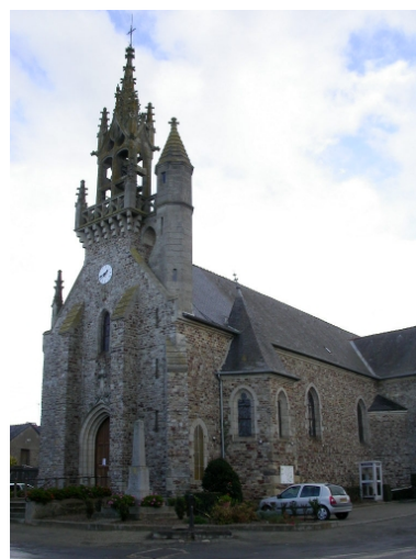
Vue sud-ouest Phot. Stéphanie Ménard IVR53_20043512272NUCA
