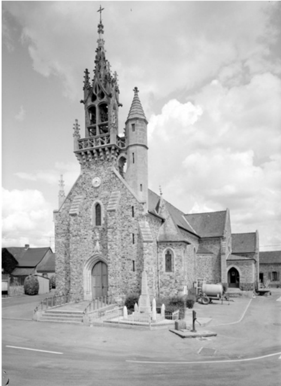
Elévation Ouest : vue générale
