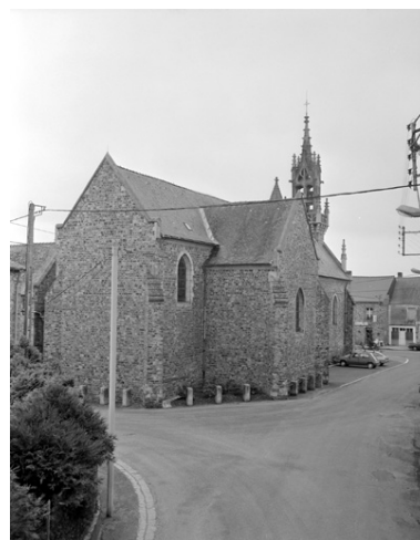
Elévation Nord-Est : vue générale
