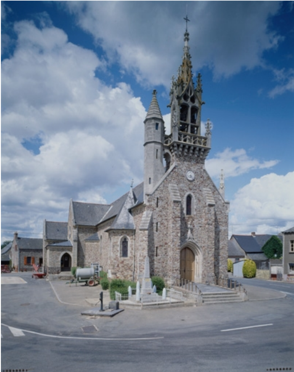
Elévation Ouest : vue générale
