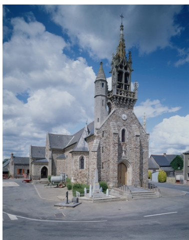
Elévation Ouest : vue générale Phot. Guy Artur, Phot. Norbert Lambart IVR53_19923500605VA
