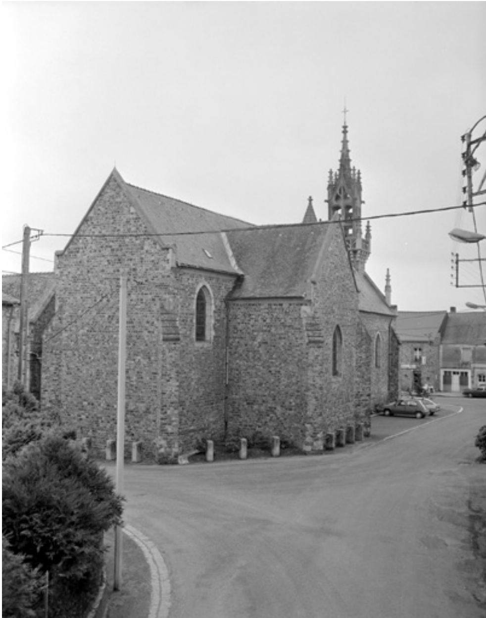
Elévation Nord-Est : vue générale
