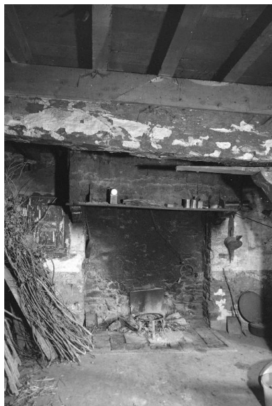
Ancien logis nord est, rez-de-chaussée, vue générale de la cheminée.
