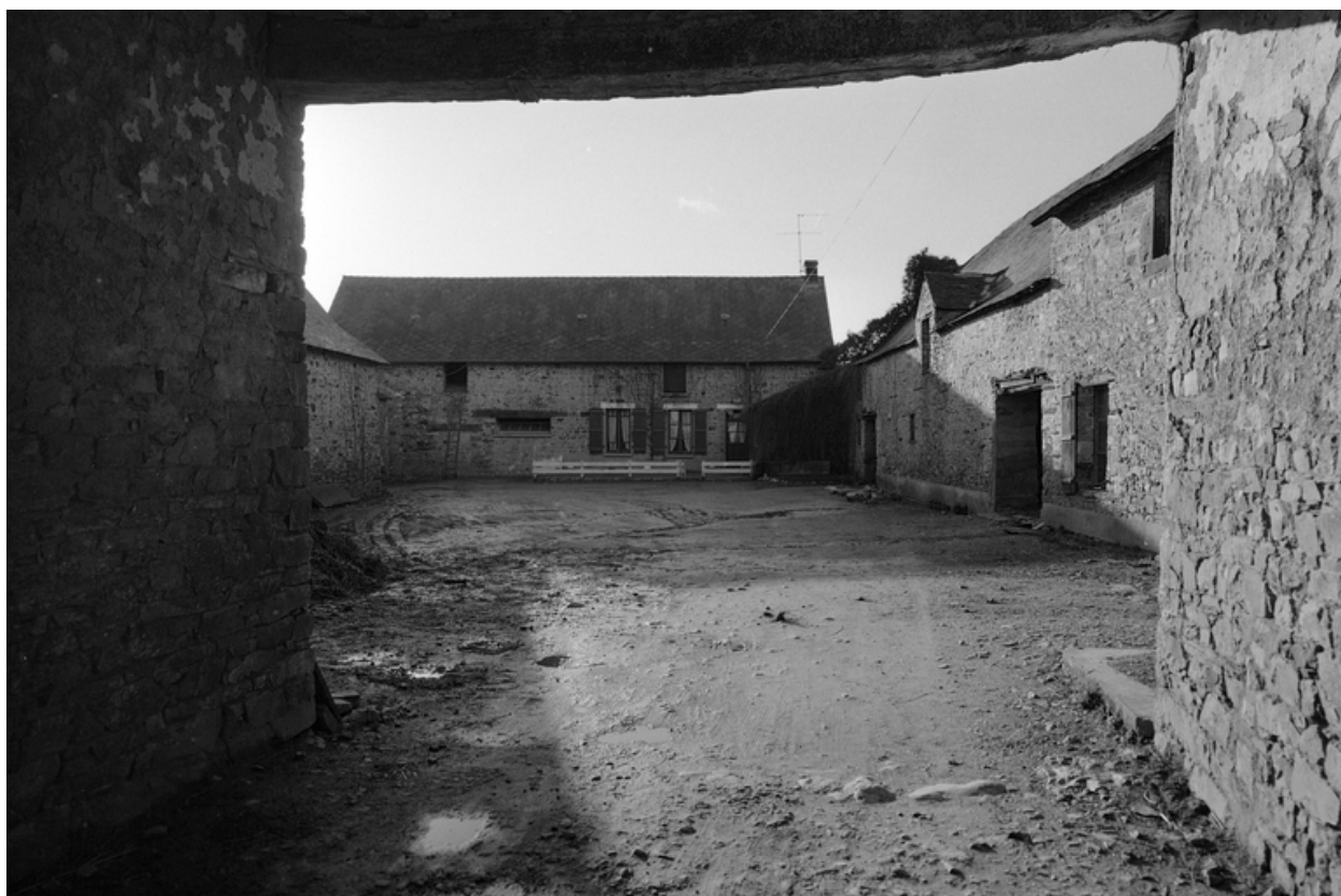
Cour intérieure, vue vers l'ouest.
