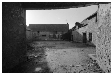
Cour intérieure, vue vers l'ouest.
