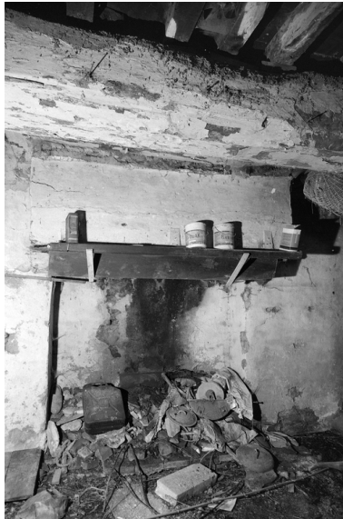
Cheminée, vue générale. Phot. Guy Artur IVR53_19713500037V
