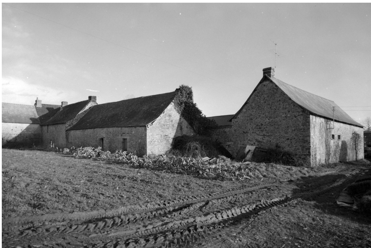
Vue de situation prise du nord ouest.
