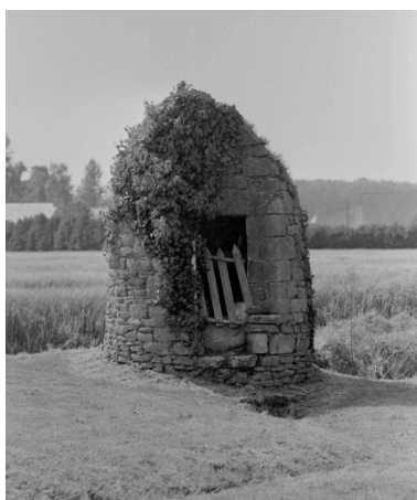
La basse-cour, puits : face antérieure Phot. Guy Artur, Phot. Norbert Lambart IVR53_19952200444X
