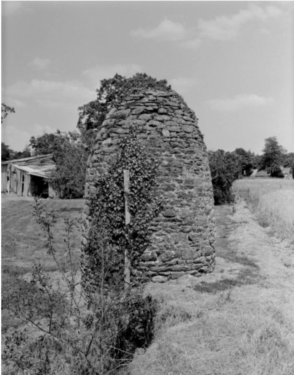
La basse-cour, puits : face postérieure
