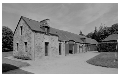
Dépendance, façade ouest Phot. Guy Artur, Phot. Norbert Lambart IVR53_19952200443X
