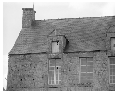
Façade sud : lucarne ouest Phot. Guy Artur IVR53_19752200292X
