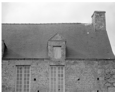
Façade sud : lucarne est Phot. Guy Artur IVR53_19752200294X
