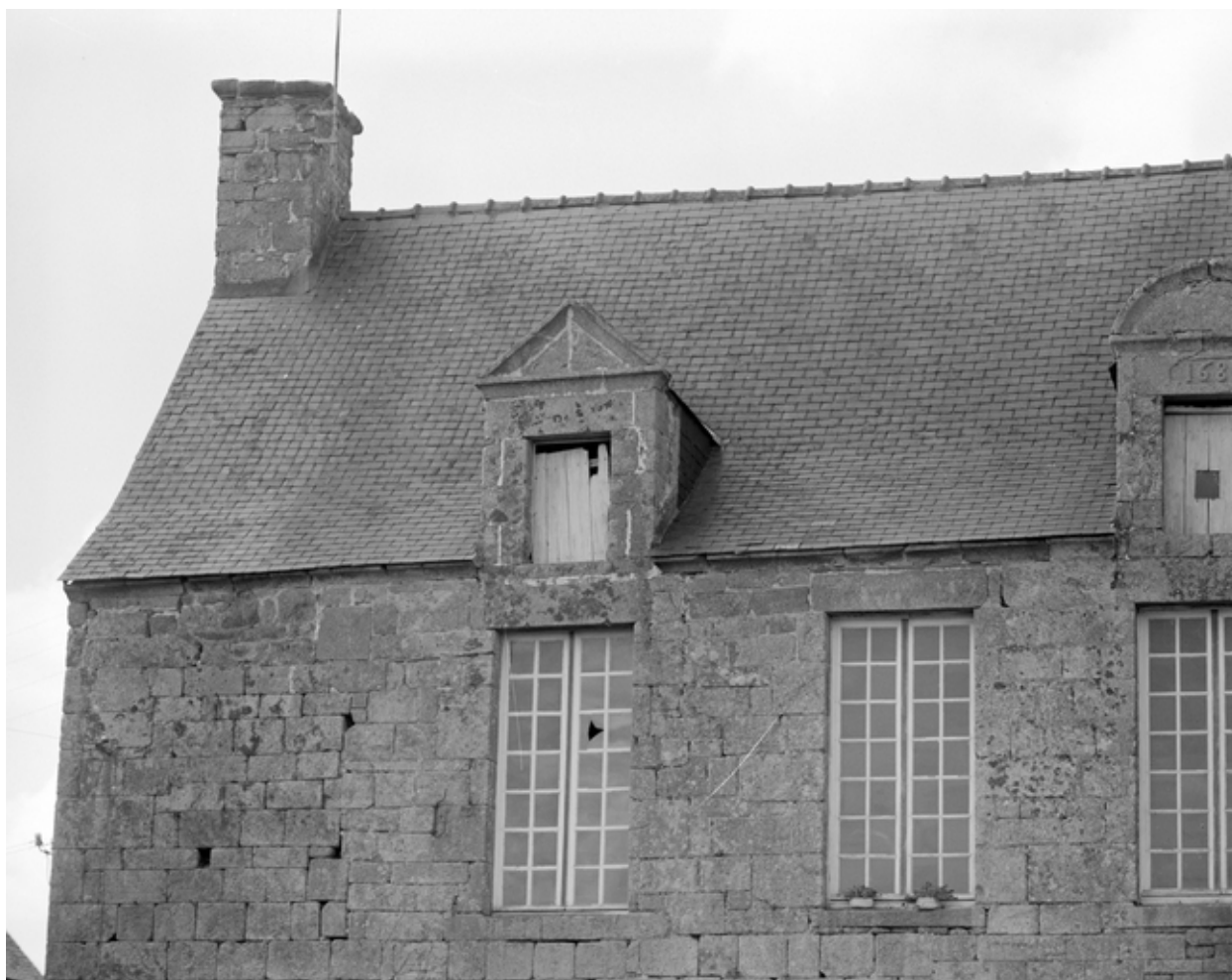
Façade sud : lucarne ouest
