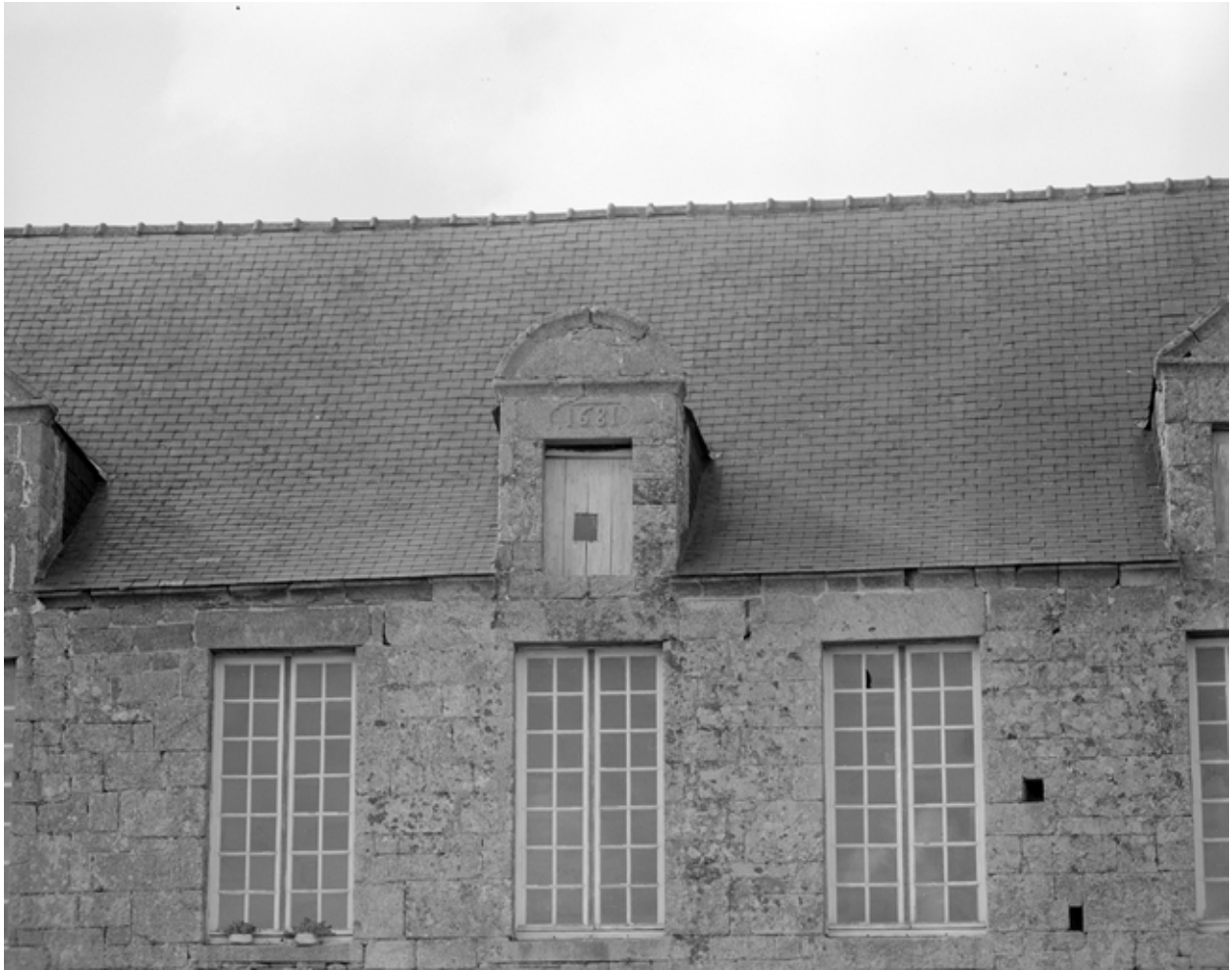
Façade sud : lucarne médiane
