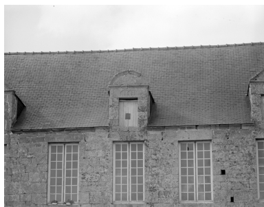
Façade sud : lucarne médiane Phot. Guy Artur IVR53_19752200293X
