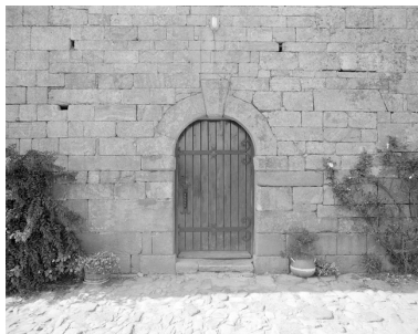
Façade sud : porte plein-cintre Phot. Guy Artur IVR53_19752200291X
