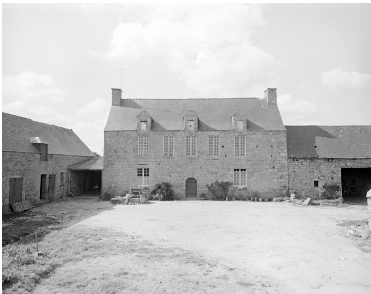
Vue générale sud
