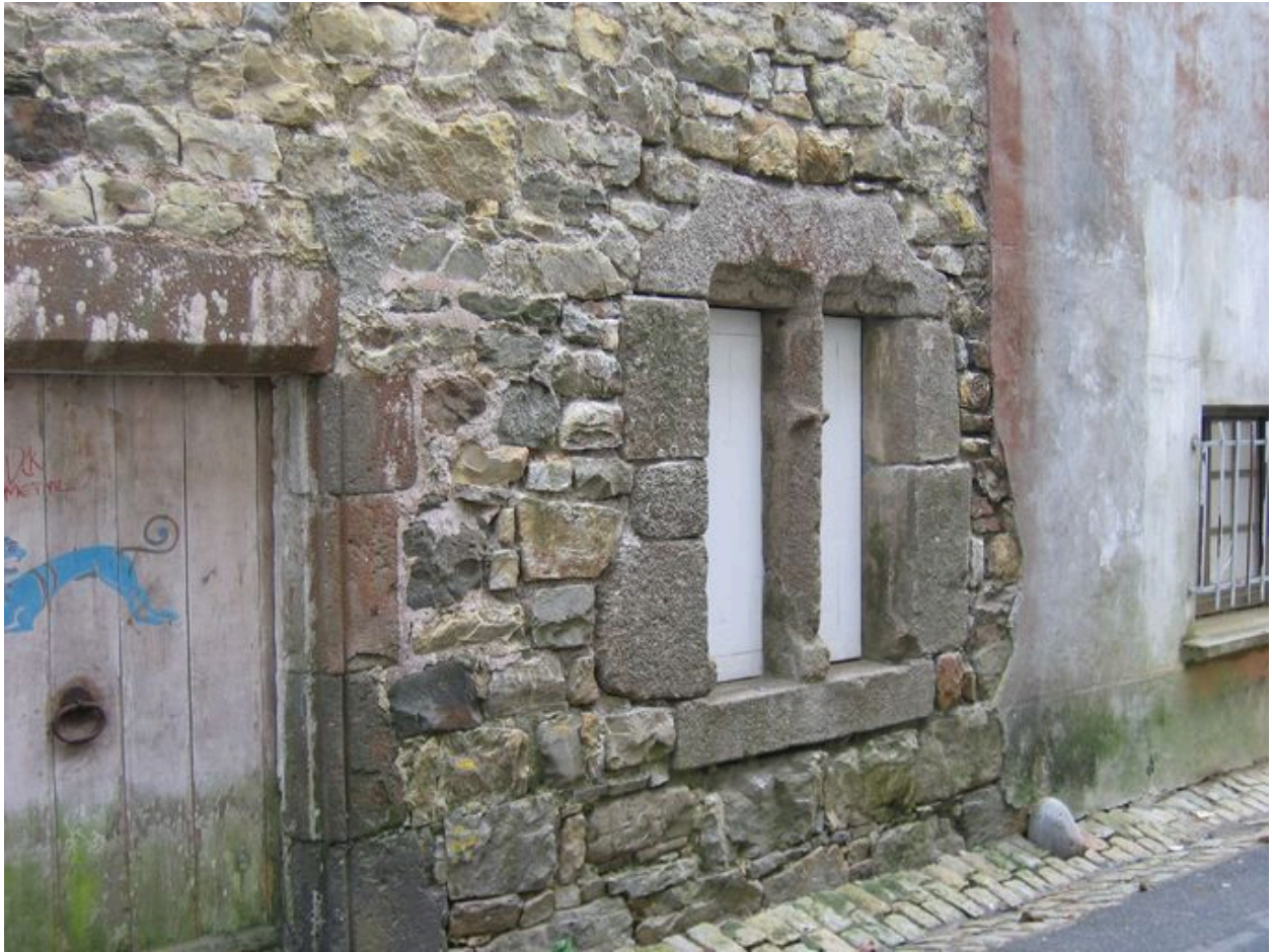
Elévation postérieure, détail de la baie à meneau
