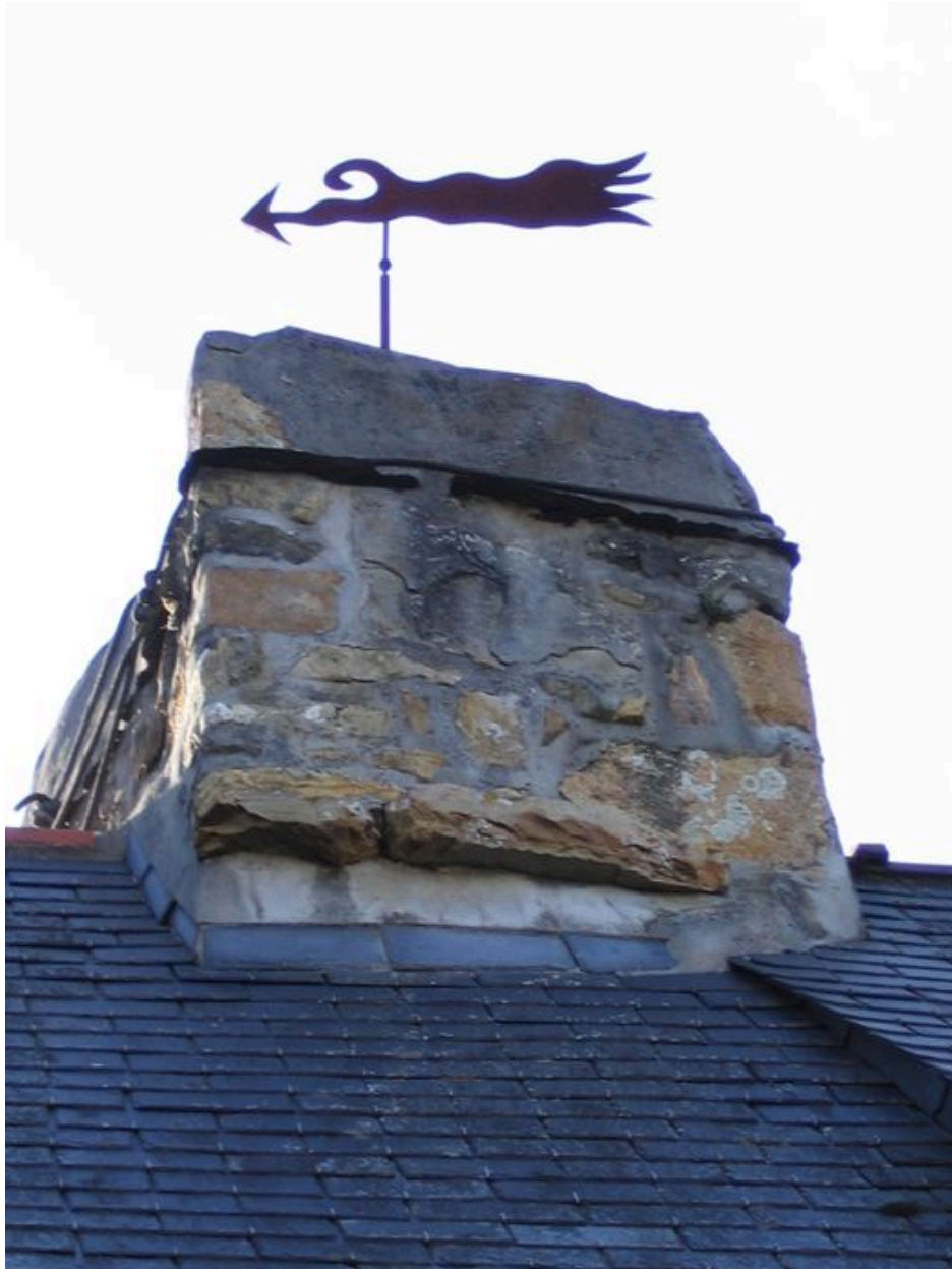
Elévation antérieure, détail de la souche de cheminée
