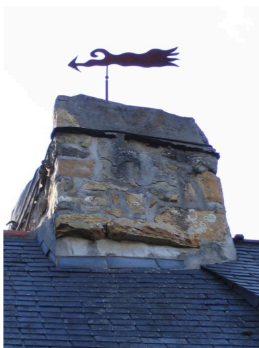
Elévation antérieure, détail de la souche de cheminée Phot. Guillaume Marie IVR53_20062908463NUCA
