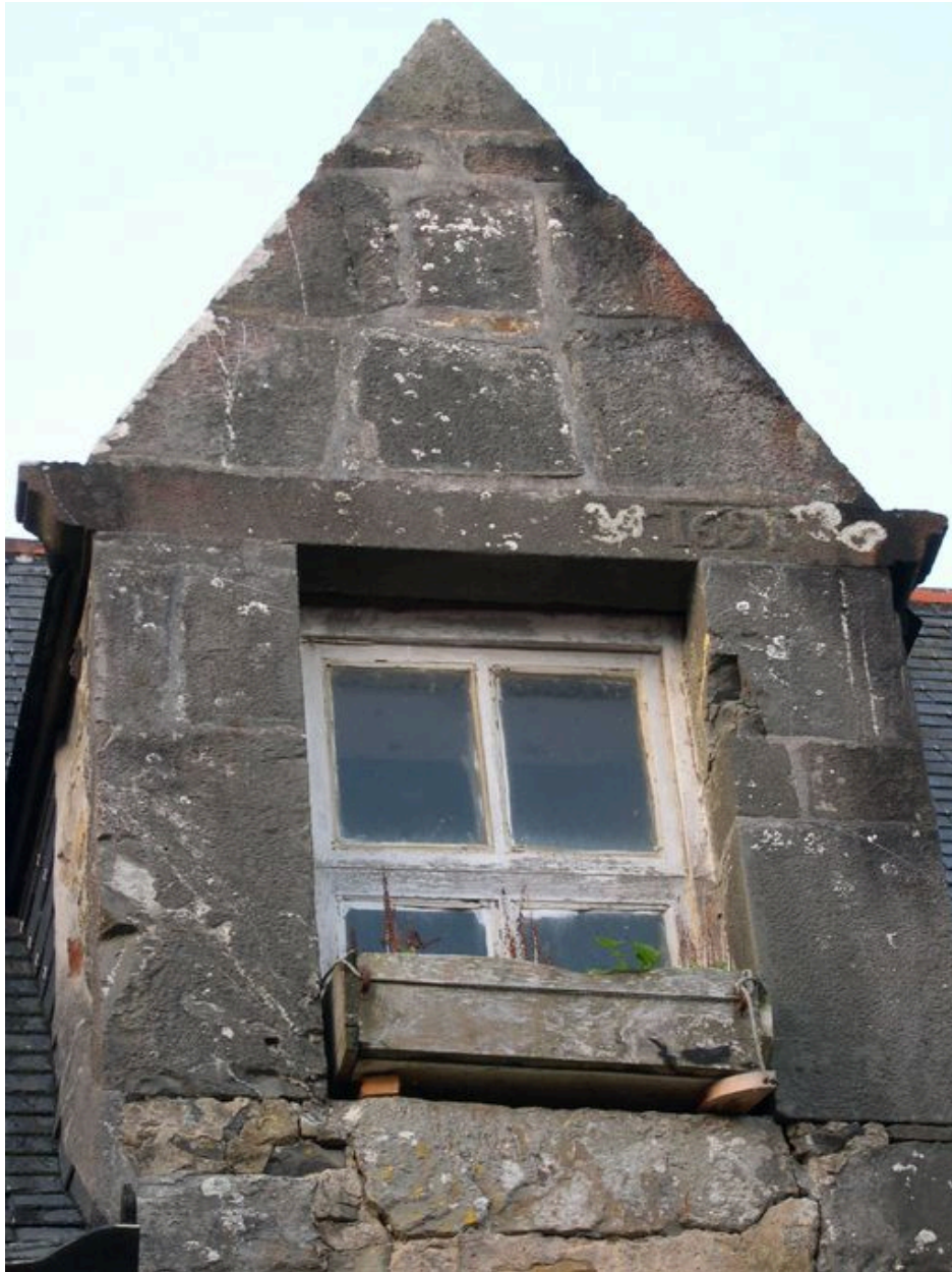
Elévation antérieure, détail de la lucarne datée
