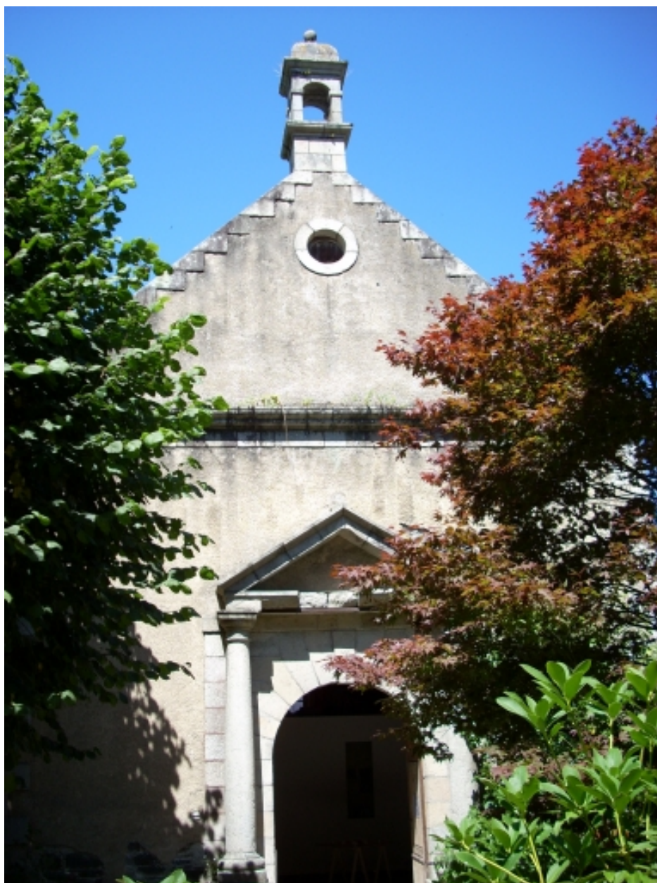
Morlaix, chapelle Notre-Dame du Mur : élévation sud
