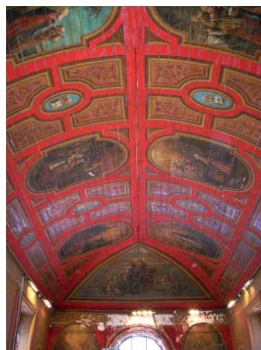
Morlaix, chapelle Notre-Dame du Mur : lambris de couverture de la nef, détail Phot. Gwénaél Fauchille IVR53_20082906609NUCA
