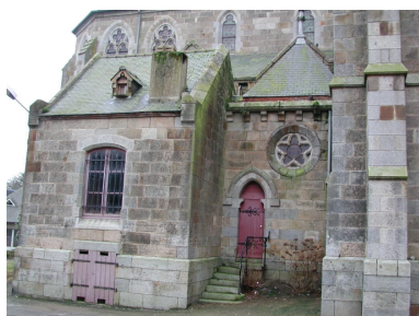
Vue partielle nord : la sacristie Phot. Elise Lauranceau IVR53_20023507859NUCA
