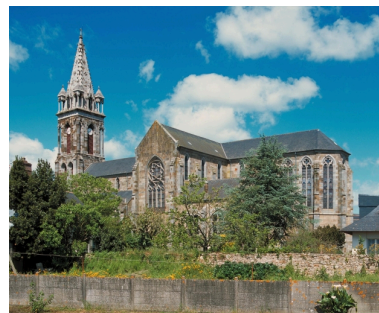
Elévation sud est ; vue générale Phot. Guy Artur, Phot. Norbert Lambart IVR53_20013501199XA
