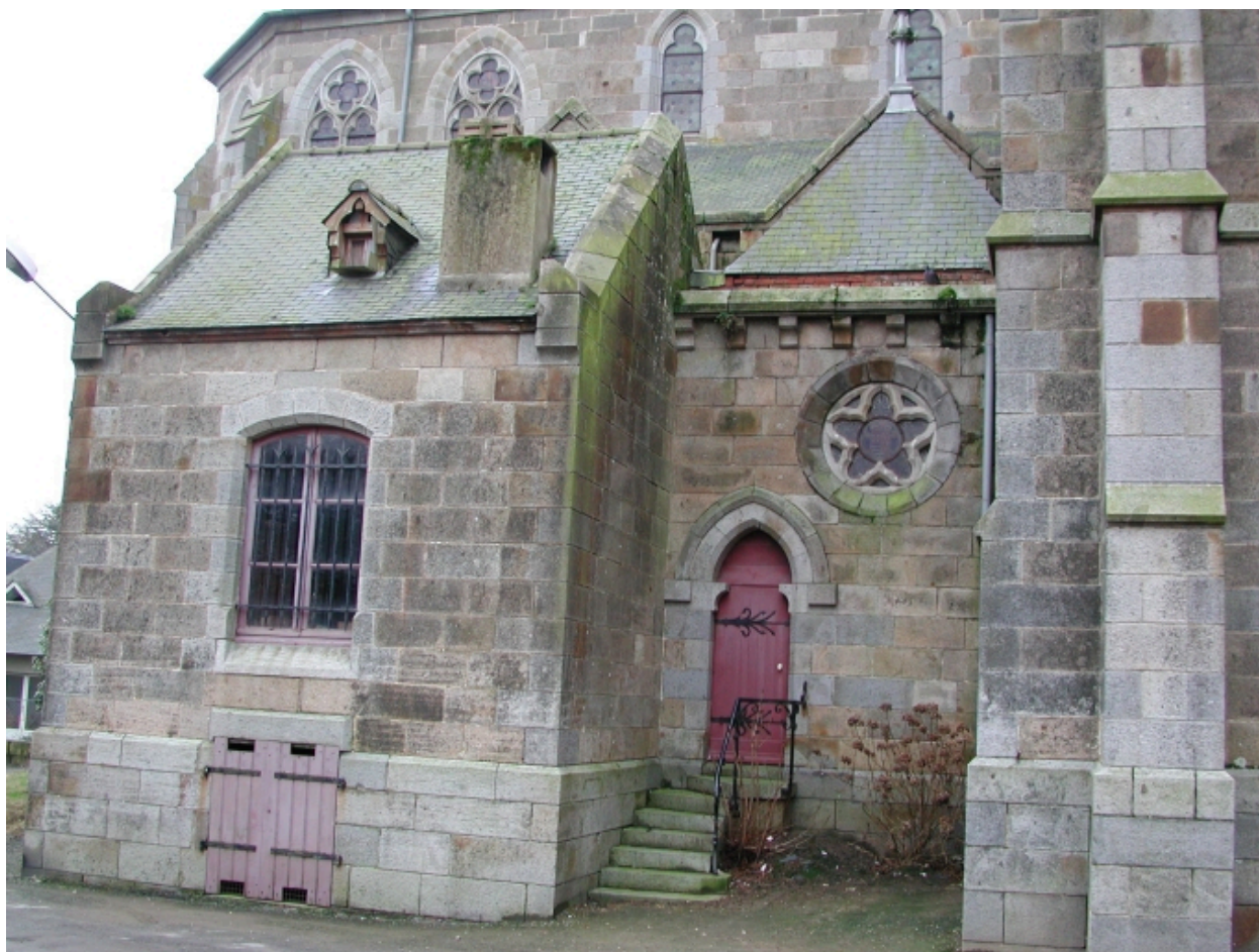
Vue partielle nord : la sacristie
