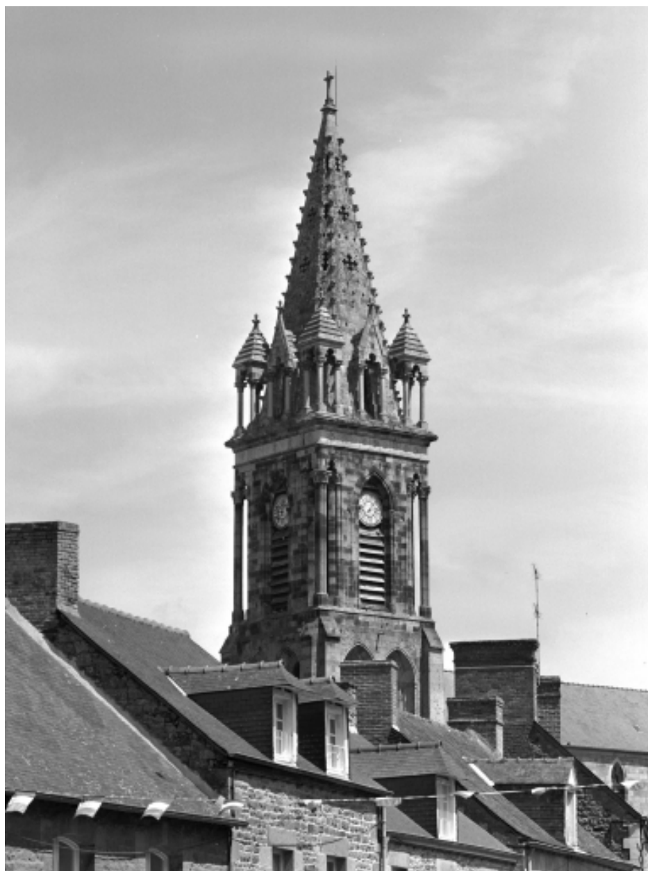
Elévation Sud-Ouest, clocher, partie haute : vue générale
