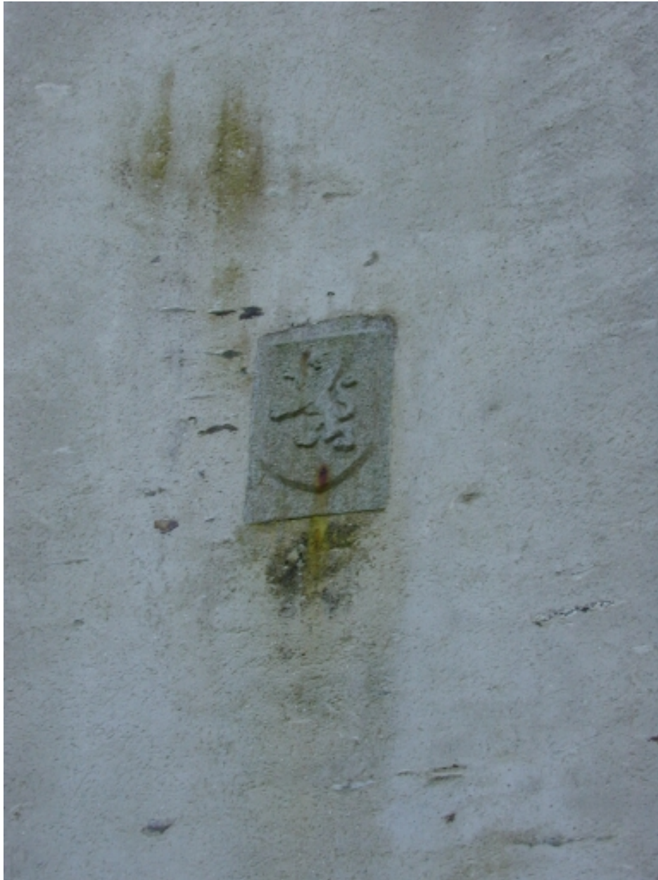
Détail : façade nord, armoiries
