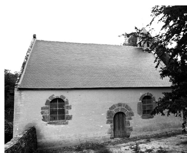
La façade est avec porte en plein cintre à besants décoratifs Phot. Bernard Bègne, Phot. M. Loyon IVR53_19923500791X
