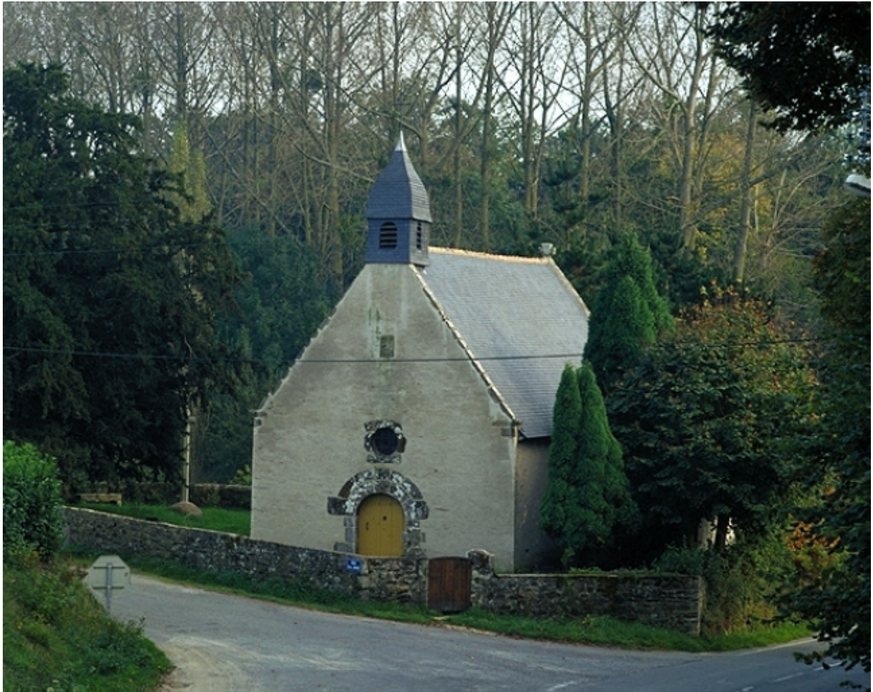
Vue générale nord de la chapelle avec son enclos
