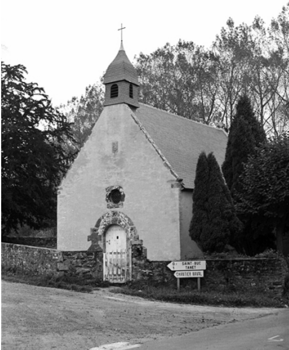
Vue générale nord de la chapelle avec son enclos
