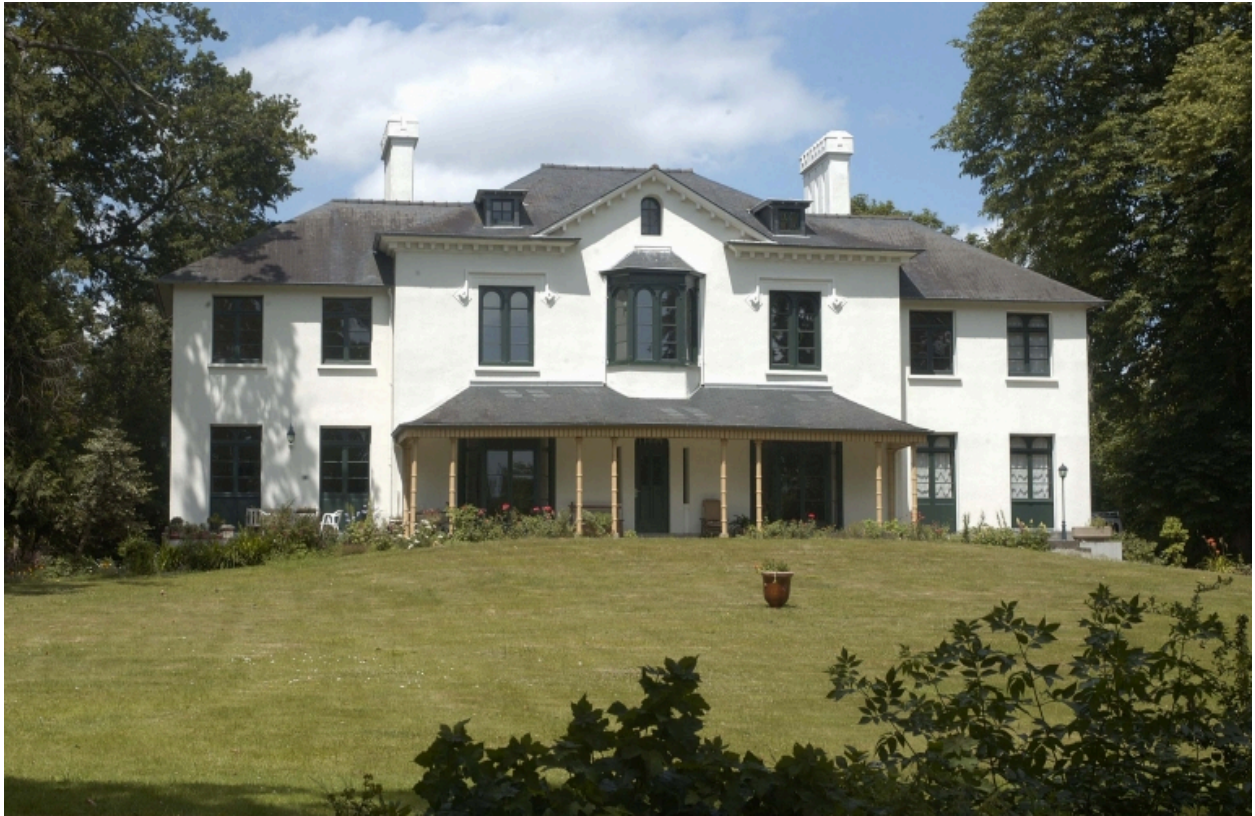
Vue générale de la façade sur jardin
