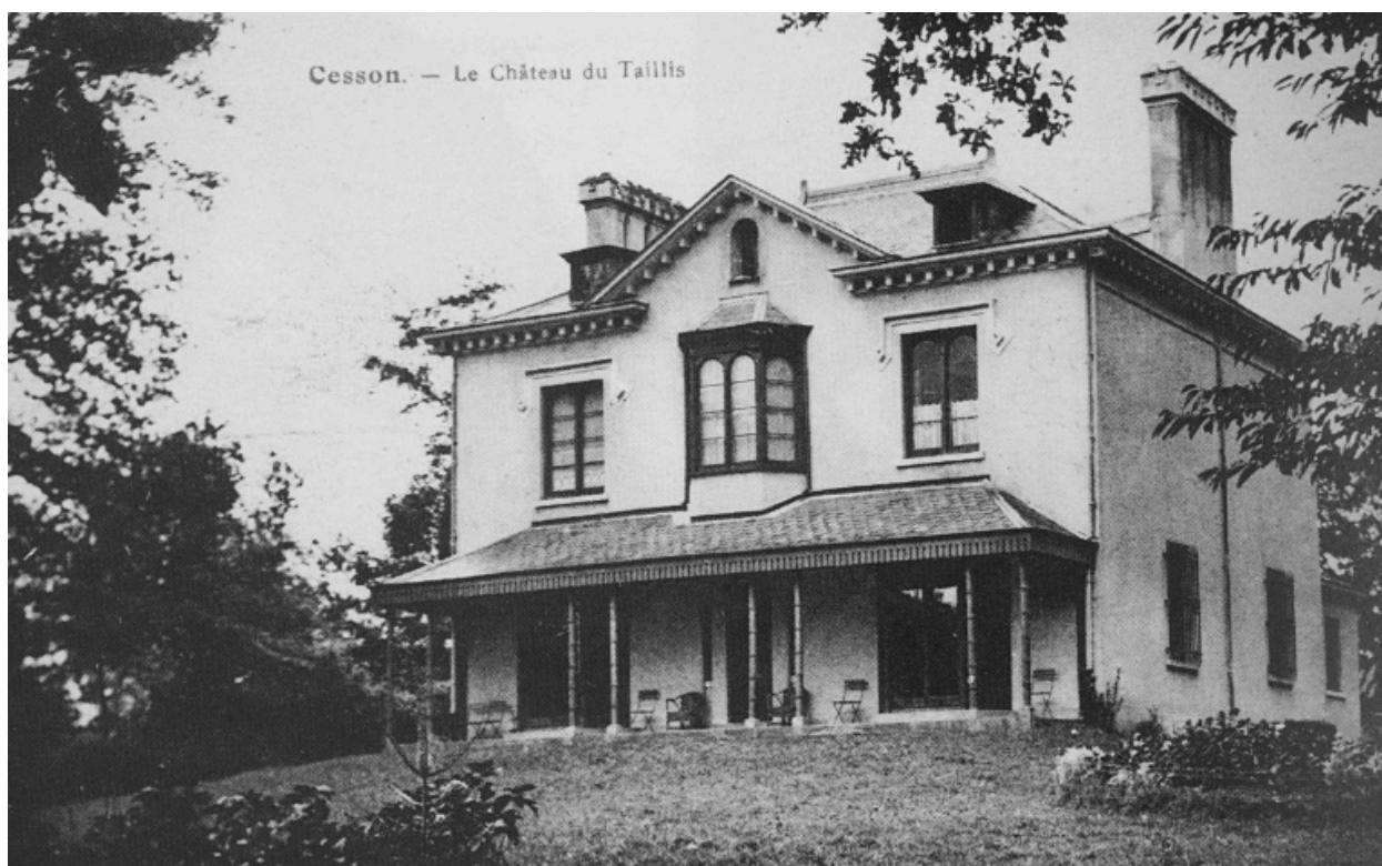
Vue générale de la façade au début du 20e siècle (carte postale extraite de l'ouvrage de Sophie Rémy et Joseph Pèlerin)
