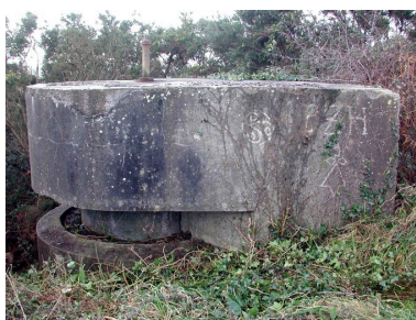
Vue de l'un des postes d'observation et de télémétrie : bâtiment n° 3 (état en 2007) Phot. Guillaume Lécueillier IVR53_20072905970NUCA
