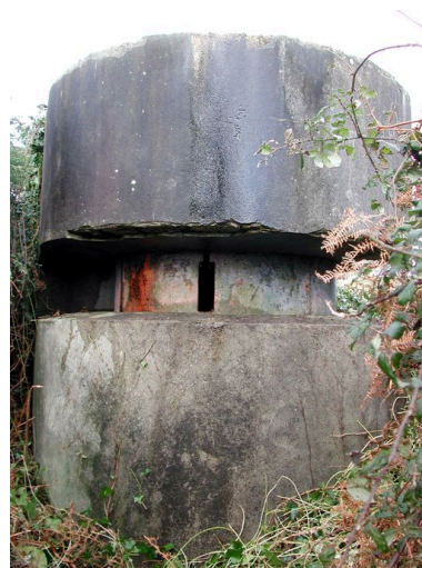
Vue de l'un des postes d'observation et de télémétrie : bâtiment n° 3 (état en 2007) Phot. Guillaume Lécueillier IVR53_20072905971NUCA
