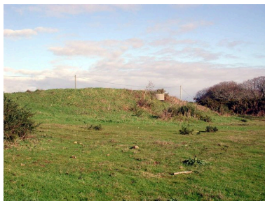
Vue de l'un des postes d'observation et de télémétrie : bâtiment n° 4 (état en 2007) Phot. Guillaume Lécueillier IVR53_20072905955NUCA
