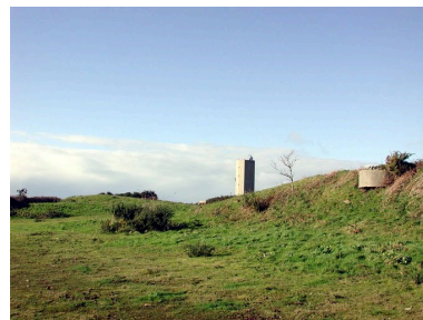
Vue de l'un des postes d'observation et de télémétrie : bâtiment n° 4 (état en 2007) Phot. Guillaume Lécueillier IVR53_20072905957NUCA
