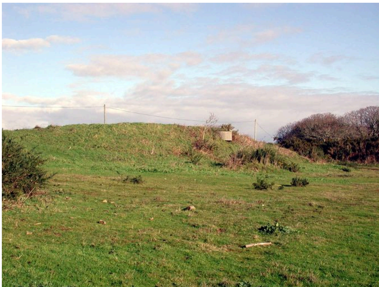
Vue de l'un des postes d'observation et de télémétrie : bâtiment n° 4 (état en 2007)
