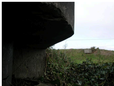
Vue de l'un des postes d'observation et de télémétrie : bâtiment n° 3 (état en 2007) Phot. Guillaume Lécueillier IVR53_20072905972NUCA
