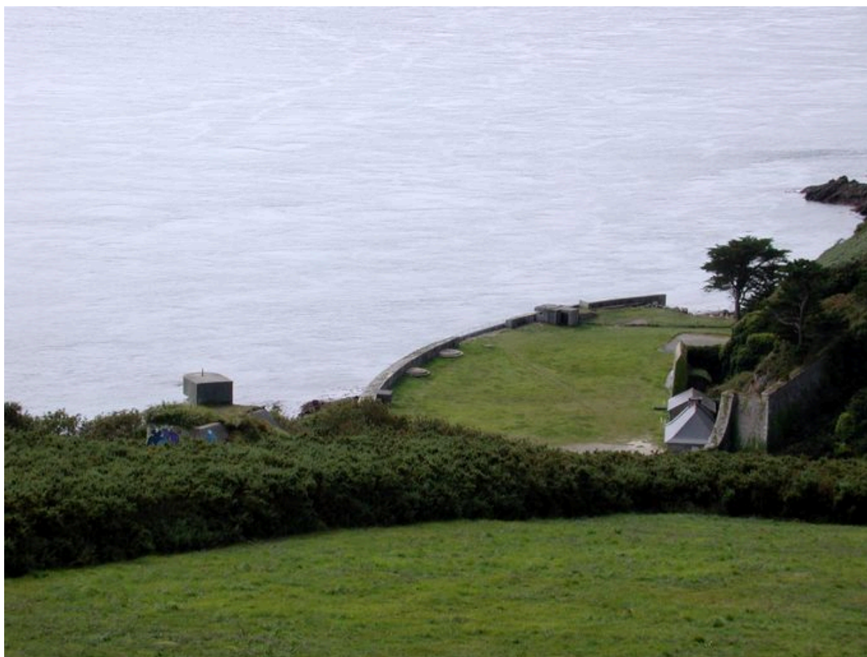
Vue de situation de l'un des postes d'observation et de télémétrie : bâtiment n° 1 (état en 2007)
