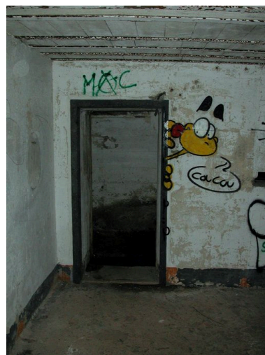
Vue intérieure de l'un des postes d'observation et de télémétrie : bâtiment n° 1 (état en 2007) Phot. Guillaume Lécueillier IVR53_20072905968NUCA
