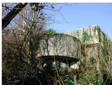
Vue de l'un des postes d'observation et de télémétrie : bâtiment n° 2 (état en 2007) Phot. Guillaume Lécueillier IVR53_20072905969NUCA
