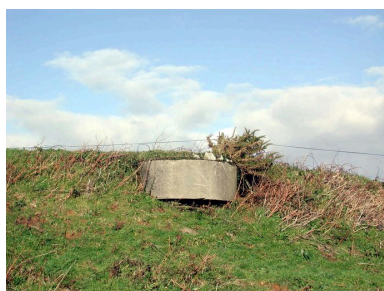
Vue de l'un des postes d'observation et de télémétrie : bâtiment n° 4 (état en 2007) Phot. Guillaume Lécueillier IVR53_20072905956NUCA
