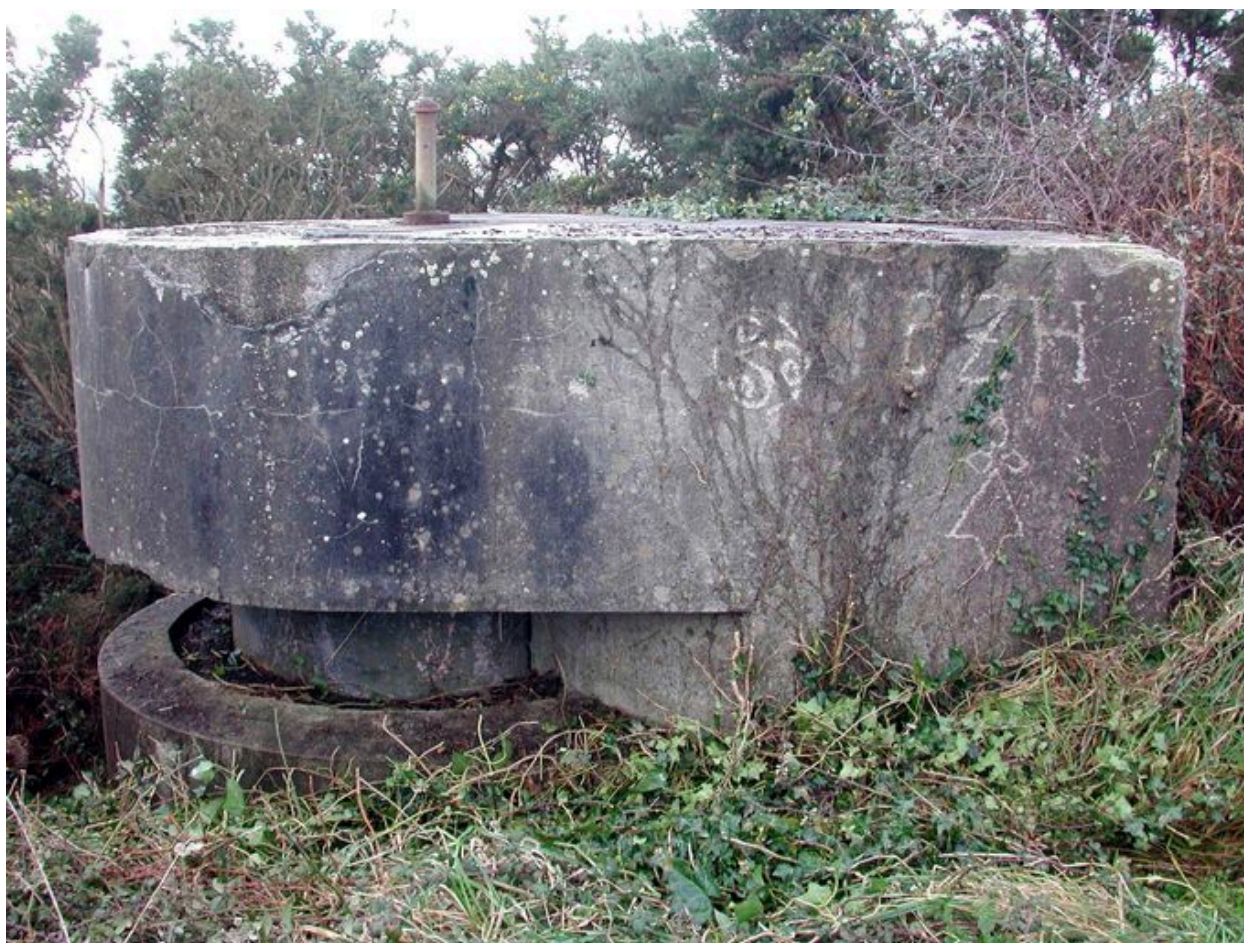
Vue de l'un des postes d'observation et de télémétrie : bâtiment n° 3 (état en 2007)
