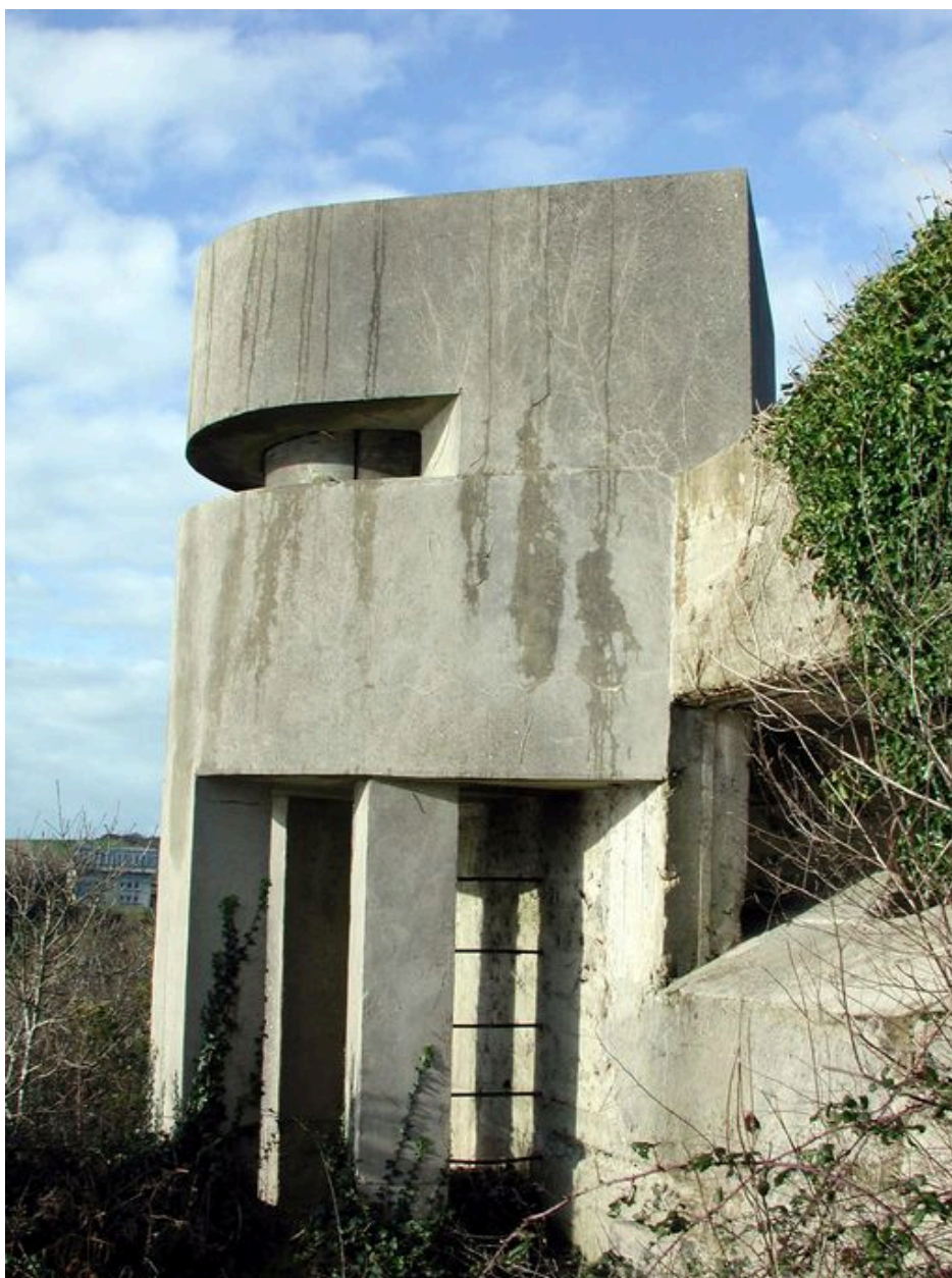
Vue de l'un des postes d'observation et de télémétrie : bâtiment n° 1 (état en 2007)
